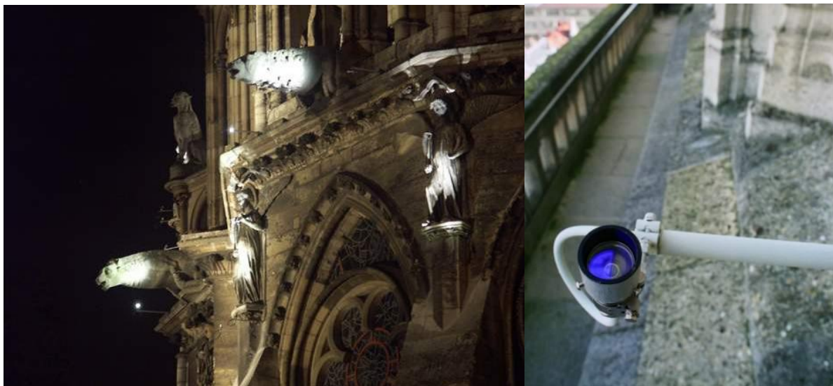
Figura 88: Detalhes de fachada iluminados com lâmpadas de vapor metálico de baixa potência (esq.) e equipamento utilizado para este fim (dir.).
