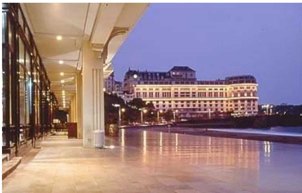
Figura 114 - Intervenção de iluminação em hotel na costa da vila de Biarritz. Espuma do mar. Fonte: www.biarritz.fr/.../environ/popup/eclairage5.jpg , 2007.
