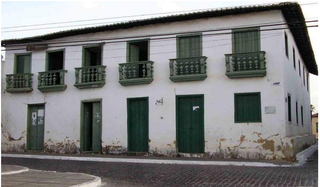
Figura 46 - Sobrado situado na atual Rua Castro Alves, nº2, antes da intervenção do IPHAN, pelo “Monumenta São Cristóvão”.
