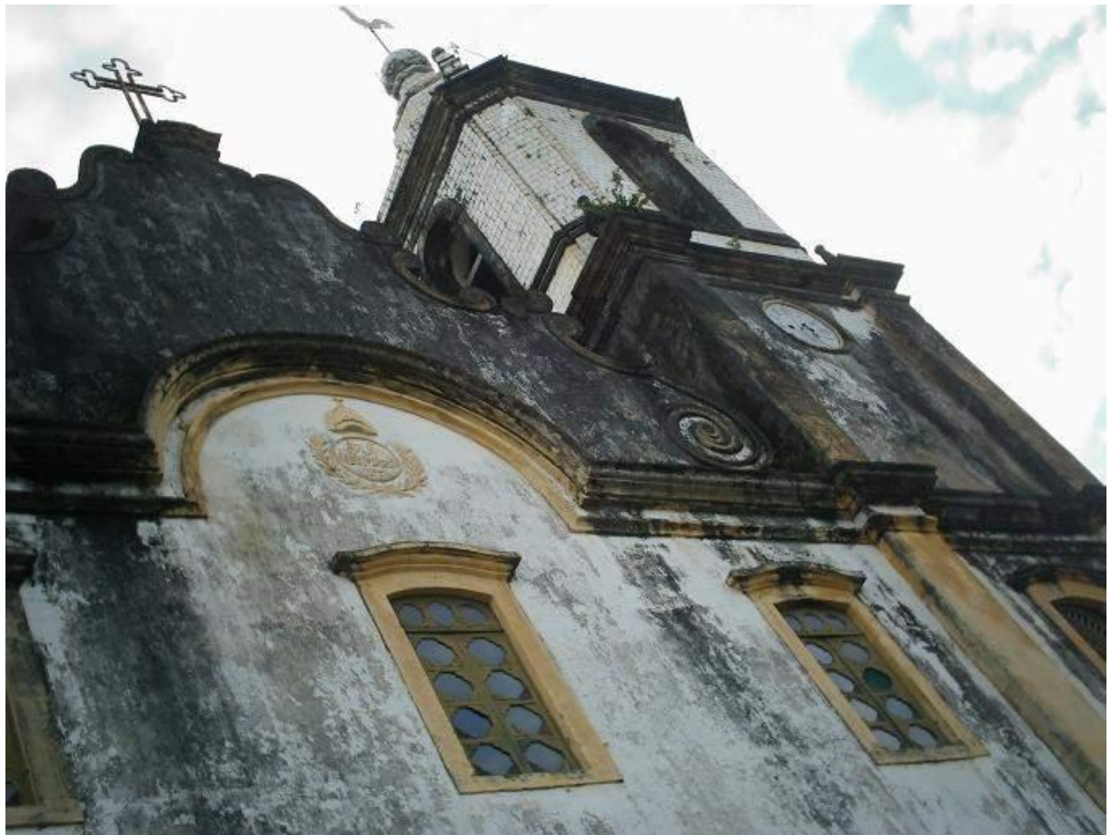
Figura 29 - Foto da Igreja Matriz Nossa Senhora da Vitória. Detalhe do frontão e das torres. Fonte: MOISINHO, 2008.
