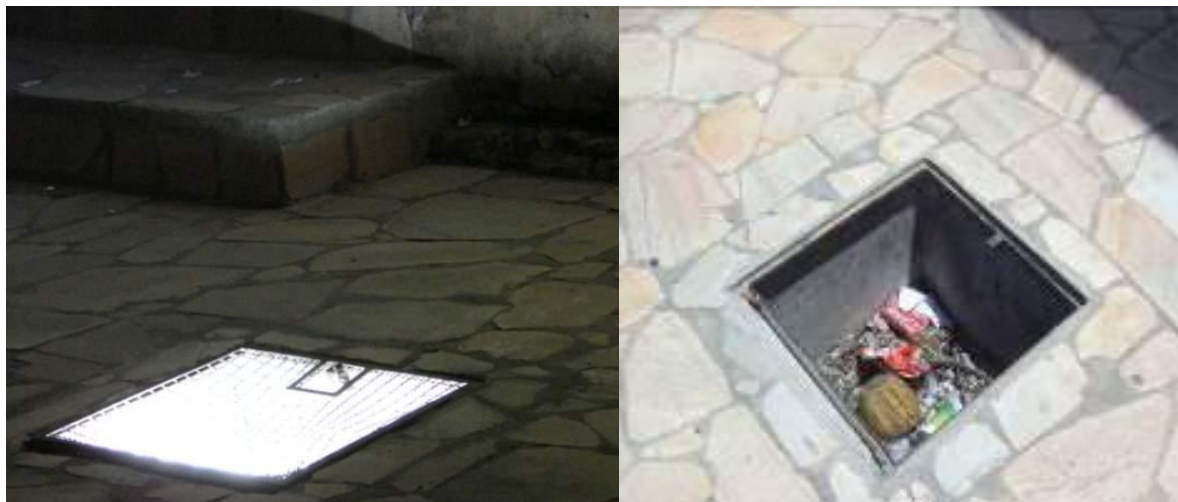
Figura 68 - Iluminação da fachada da antiga Capela dos Capuchinhos na época da Inauguração (esquerda) e um ano depois (direita). Fonte: MOISINHO, 2009.
