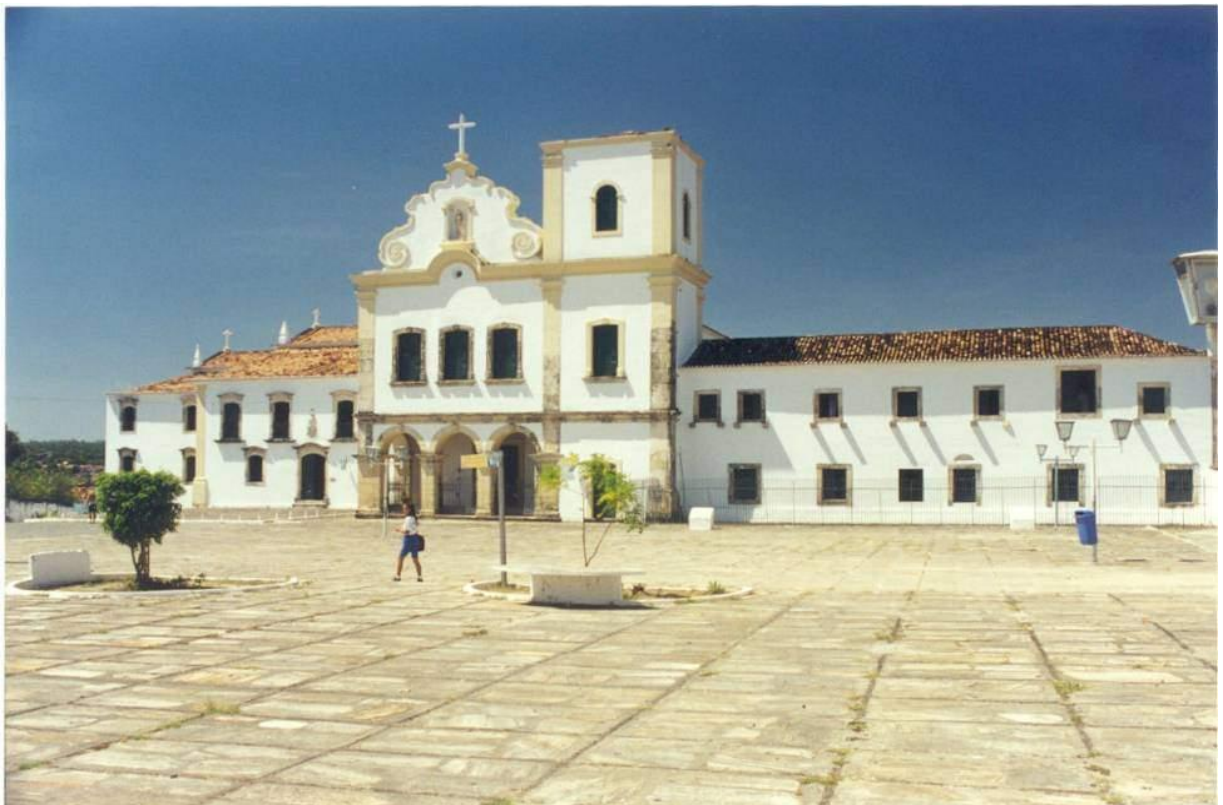
Figura 31 - Foto da Igreja de Ordem Primeira e Terceira e Convento Franciscano. Formação sem pináculos na torre e no frontão. Fonte: IPHAN, 2007.
