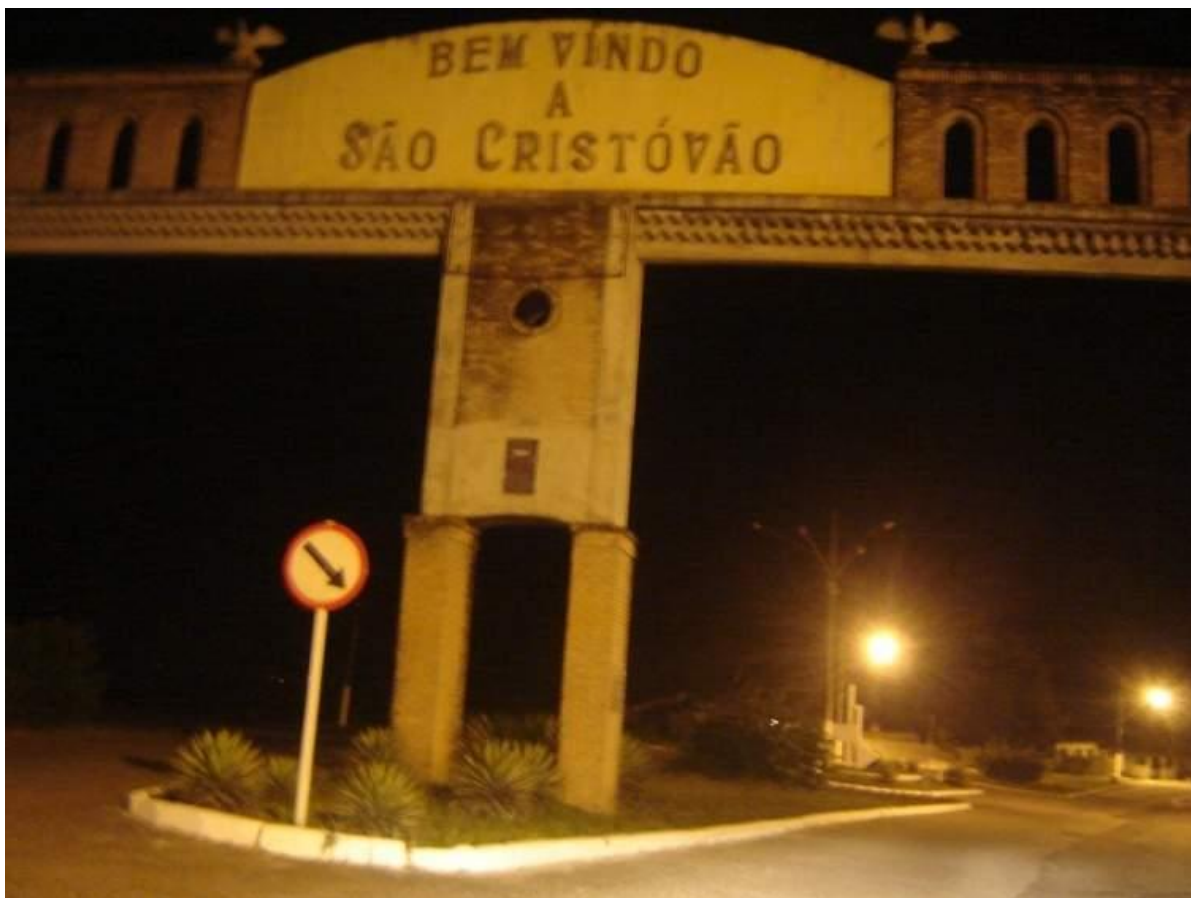
Figura 62 - Vista noturna do pórtico de acesso ao município. Fonte: MOISINHO, 2009.
