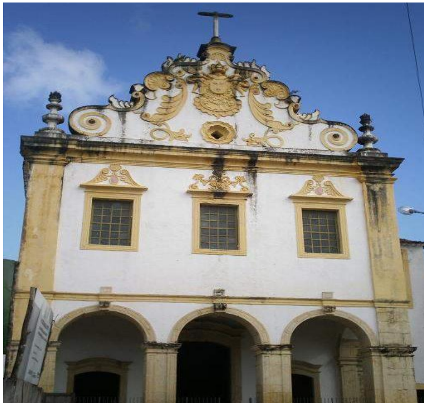
Figura 38 - Igreja de Ordem Primeira do Carmo. Fonte: MOISINHO, 2006.
