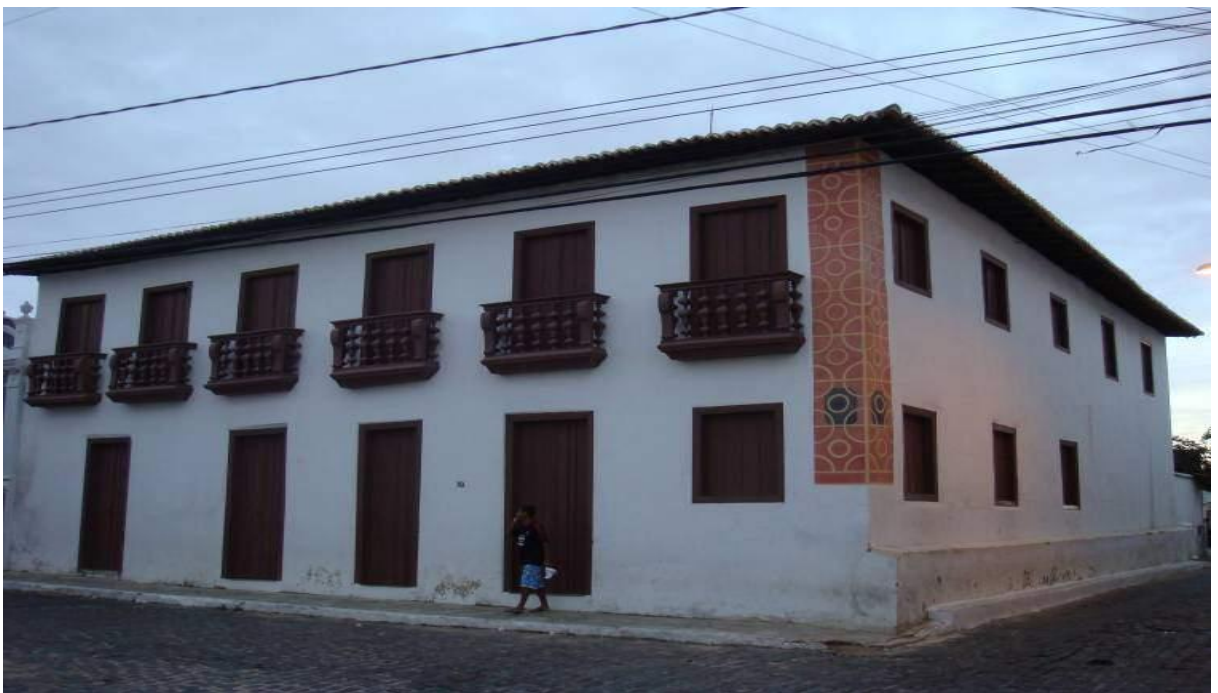
Figura 47 - Sobrado situado na atual Rua Castro Alves, nº2, antes da intervenção do IPHAN, pelo “Monumenta São Cristóvão”.
