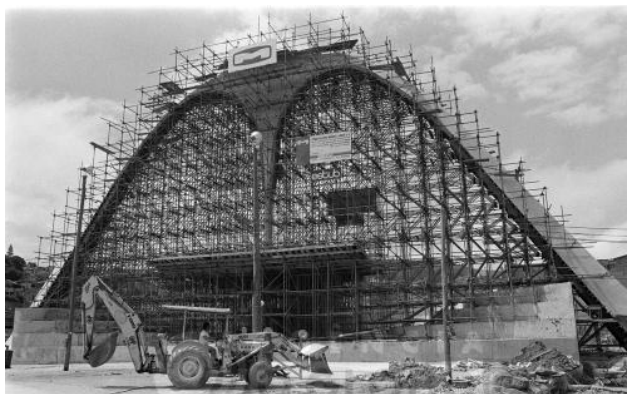
FIGURA 29 - Construção do Sambódromo, 1984 Fonte: AGÊNCIA O GLOBO, [19- -].
