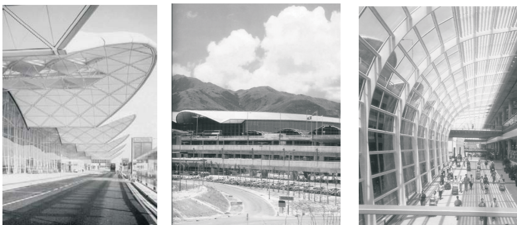
figuras 6.29a, 6.29b e 6.29c: Aeroporto de Hong Kong/Chek Lap Kok. a: Vista da frente do terminal e do meio fio de embarques. b: Pode-se observar na foto a interferência da estação de trens e das estruturas do sistema viário de acesso sobre a visibilidade do volume principal do terminal. c: Centro de transportes terrestres.
