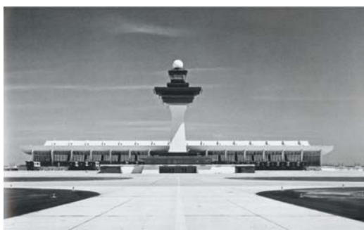
figura 3.24: Terminal de Passageiros do Aeroporto de Washington/Dulles
