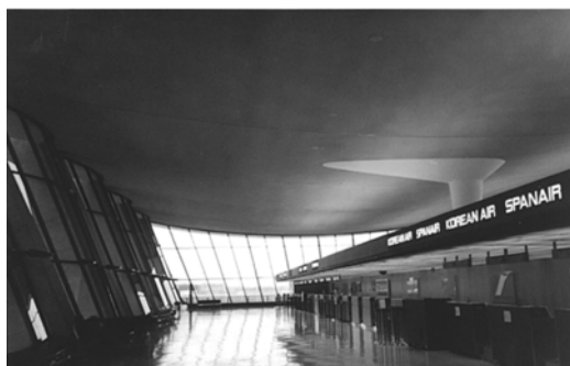
figura 6.38a: Aeroporto de Washington/Dulles – foto do saguão de “check-in”. A qualidade desse espaço-lugar é determinada entre outras razões pelas suas fronteiras: as superfícies envidraçadas das fachadas e o teto abaulado.
