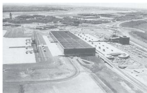
figura 3.25: Terminal de passageiros do Aeroporto de Montreal/Mirabel
