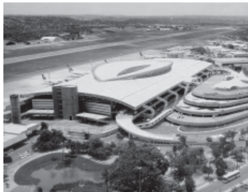
figura 4.23: Aeroporto de Recife/Guararapes – Vista do terminal de passageiros
