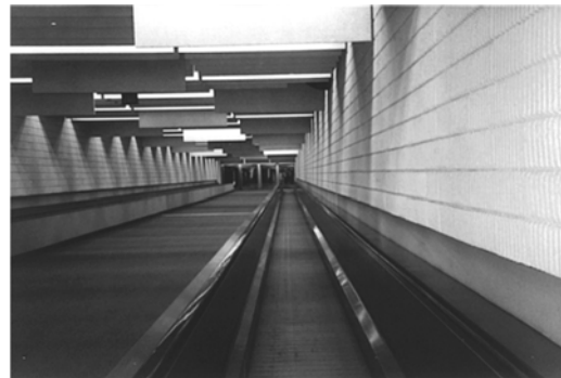
figura 3.13: Túnel de Atlanta, que interliga o Terminal Central com os terminal de páteo. Paralelamente a esse túnel, destinado a pedestres, e equipado com tapetes rolantes, correm os veículos do Sistema de Transporte Automático de Passageiros
