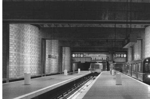
figura 6.37b: Aeroporto de Chicago/O'Hare. Estação de metrô sob os terminais 2, 2 e 3 sob o Terminal de Chicago/O'Hare e o do Centro de Transportes Públicos do Aeroporto de Seul/Incheon. A estação de O'Hare T1, com semelhanças com a de Stansted, no que diz respeito ao acesso ao terminal, possui, no entanto, uma qualidade ambiental superior, pelo tratamento cuidadoso dado ao ambiente das plataformas, de mesmo nível encontrado nos diversos ambientes do
