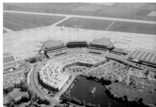
figura 3.30: Vista aérea da Área Terminal de Passageiros do Aeroporto de Hanover, com suas unidades modulares triangulares.
