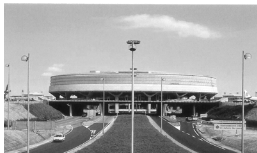
figura 4.13: Terminal 1 do Aeroporto de Paris/CDG
