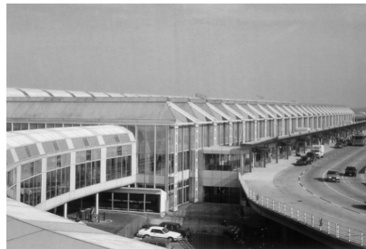
figura 6.26b: Terminal 1. Vista externa.
