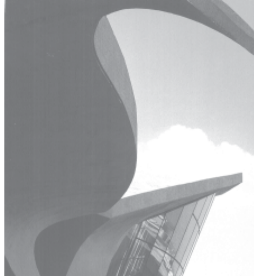
figura 5.12: Terminal da TWA no Aeroporto de Nova York/JFK
