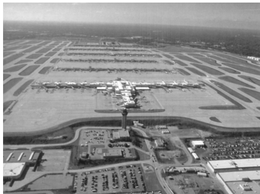
figura 4.38: Aeroporto de Atlanta/Hartsfield. Vista aérea do conjunto formado pelo terminal central e terminais de pátio
