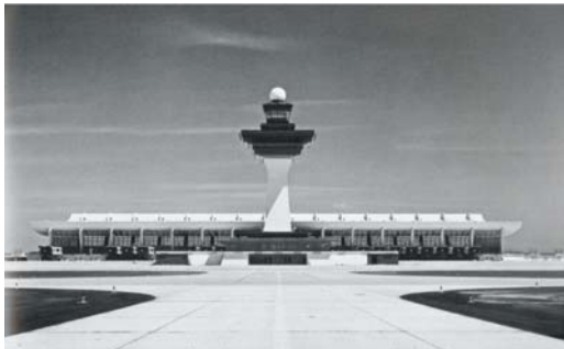
figura 6.63: Aeroporto de Washington/Dulles – Vista do lado-ar.
