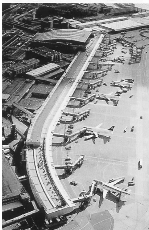
figura 4.36: Aeroporto de Hamburgo. Na foto, observa-se o extenso “pier” ao qual estarão conectados, no futuro, novos terminais (ou novas unidades modulares) previstos no plano.
