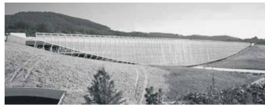
figura 6.35c: Vista do edifício garagem
