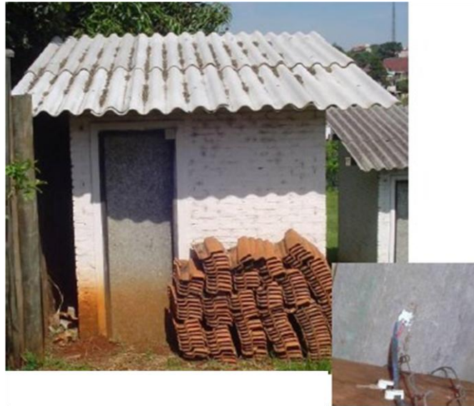
Figura 16- Célula de teste 01 após terem sido trocadas as telhas; no detalhe aparece o termopar fixado à telha de fibrocimento.
