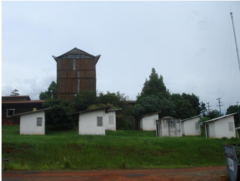
Figura 15- Células de teste do canteiro experimental (Departamento de Arquitetura e Urbanismo/ EESC/ USP – Campus I).
