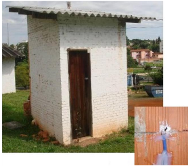
Figura 18- Célula de teste 03; no detalhe aparece o termopar fixado à laje mista.
