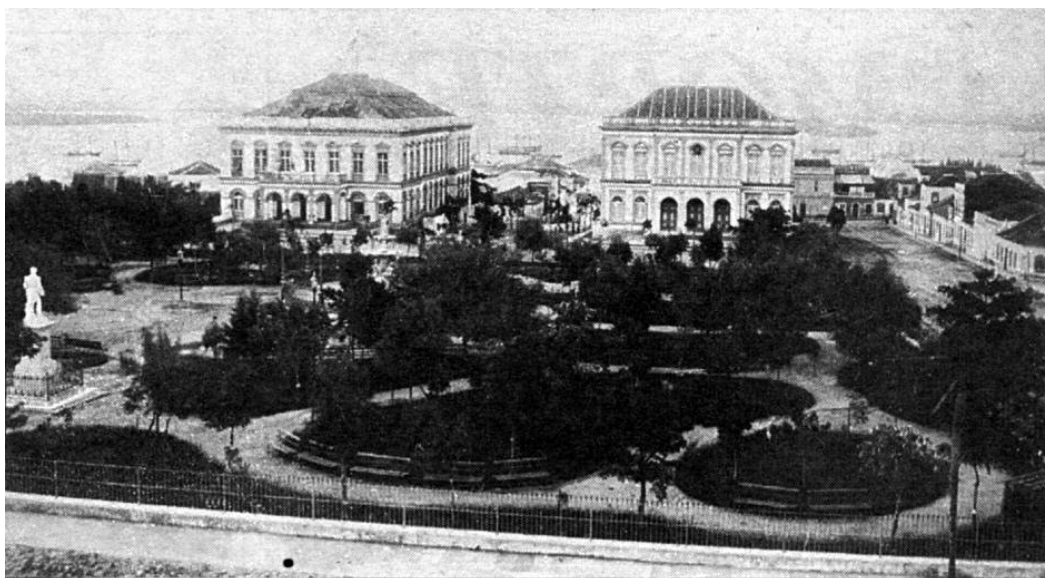
Figura 48: Foto por Ferrari e Irmão, 1890. Edifícios gêmeos do teatro e da Câmara. À frente a praça da matriz. Fonte: HACH, 2001, CD de imagens.
