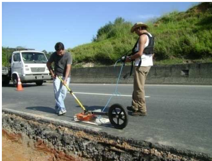
Figura 32. Aquisição dos dados de GPR na Via DUTRA, Pista Sul, km 239+760.
