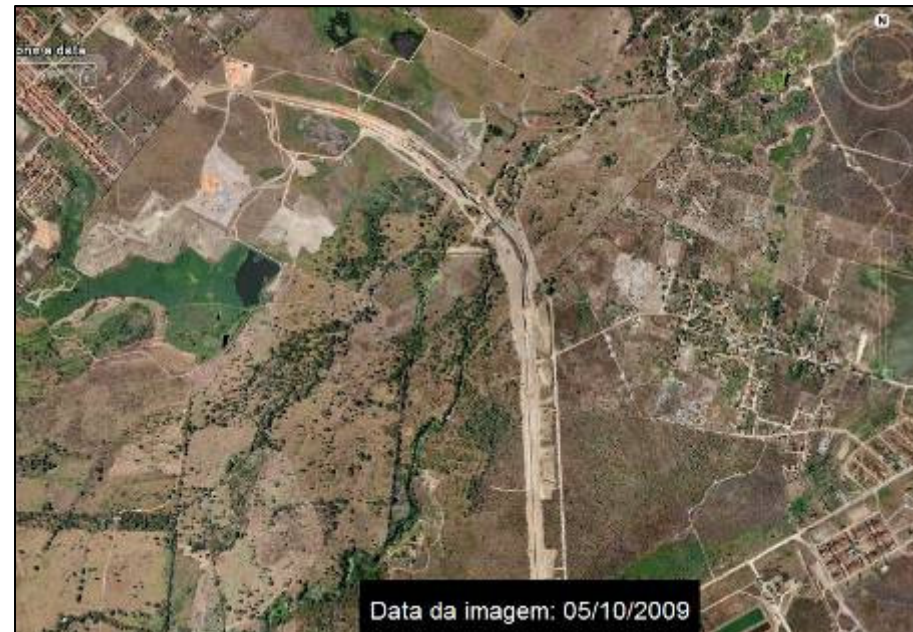
Imagem de satélite da área da Barragem Maranguapinho após o início das obras. Fonte: Google Earth.
