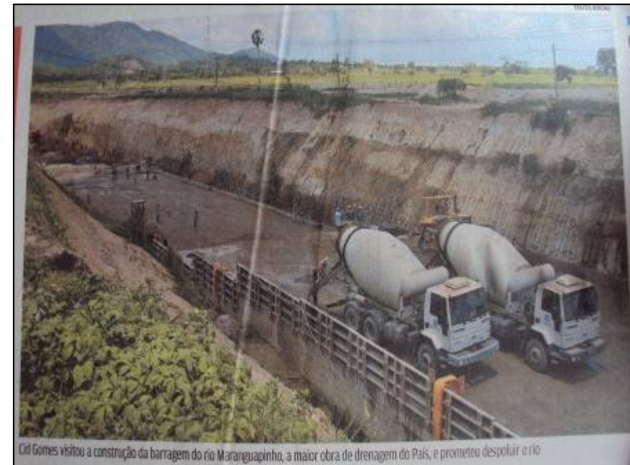
Manchete de jornal sobre a as obras da barragem. Fonte: Jornal O Povo de 24/02/2010. Foto por: Talita Rocha.
