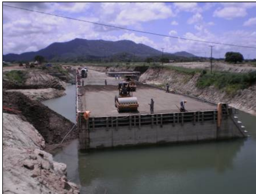
Fotografia das obras da Barragem Maranguapinho em 10/04/2010. Foto por: Eng. Rafael Costa M. S. Braga.
