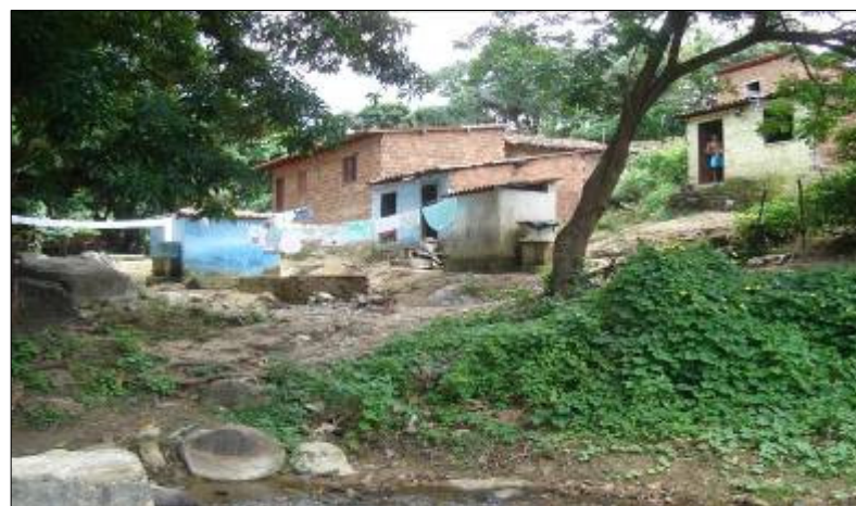
Banheiros coletivos e fossas rudimentares no Planalto dos Cajueiros com risco de contaminação das águas fluviais. Fonte: Ícaro Maia, 2009.
