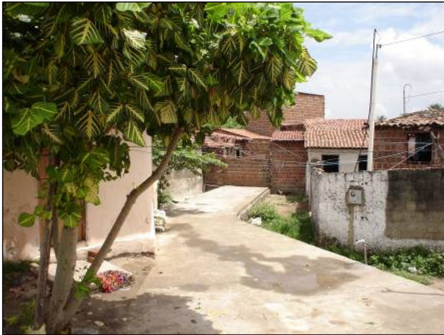
Trecho de riacho canalizado em bairro periférico da cidade de Maranguape. Observar que a frente das residências é voltada para o canal. Fonte: Ícaro Maia, 2008.
