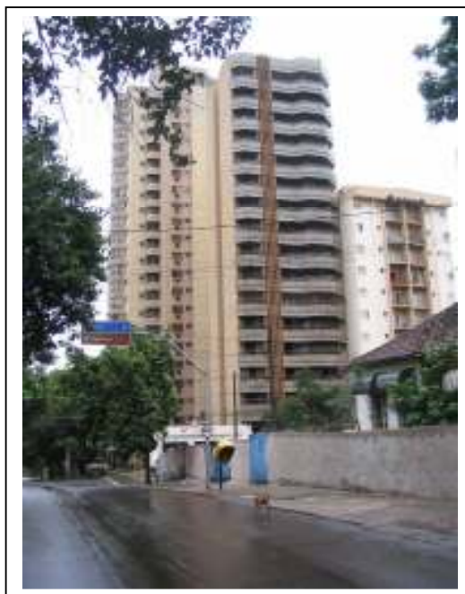
Foto 20 – Edifício Flor da Mata – construído em 1986 pela Construtora Quadra, Rua Belo Horizonte, 860, com 18 pavimentos e 15 apartamentos que totalizaram 5.035,88 m 2 .
