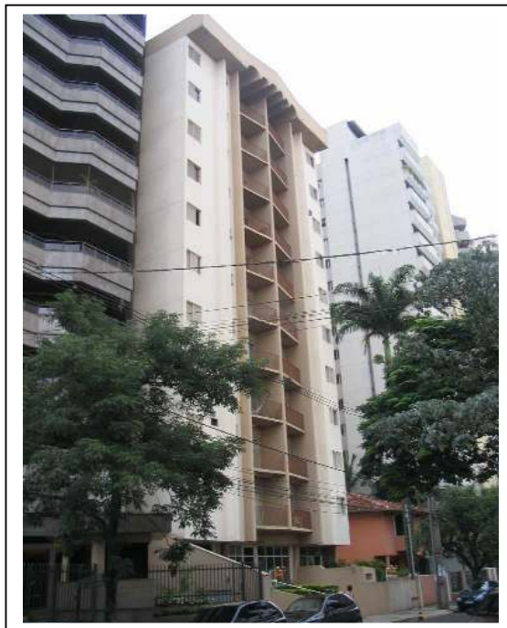
Foto 23 – Edifício San Conrado - Construído pela Artenge em 1982, à Rua Belo Horizonte, 840, com 11 pavimentos e 40 apartamentos com 77,65m 2 de área. Fonte: Passos, Viviane Rodrigues de Lima, 2006.
