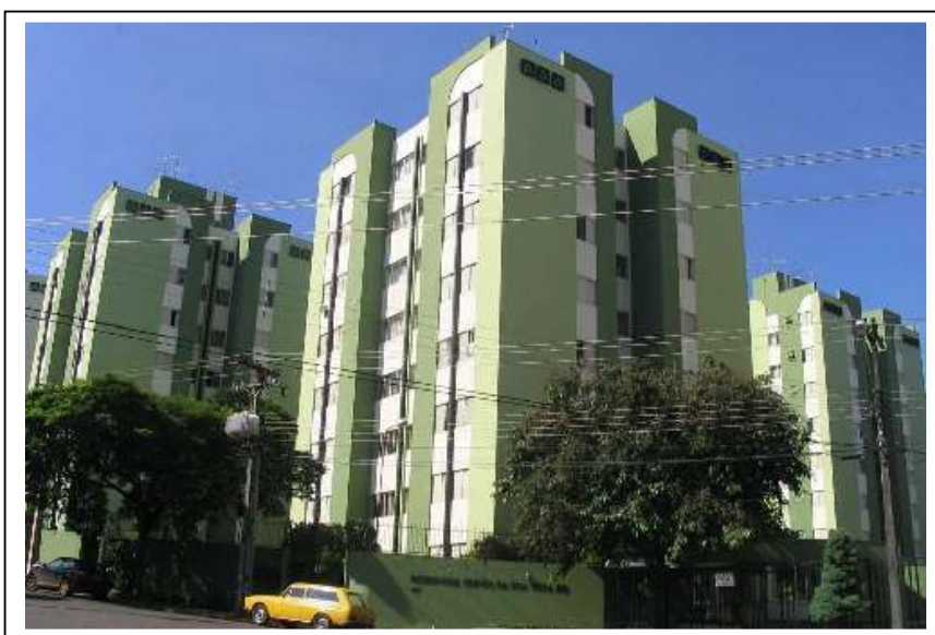
Foto 10 – Quinta da Boa Vista III C – Residencial construído em 1989 pela Construtora Plano's, sito à Rua Garibaldi Deliberador, 545, composto por 3 edifícios de 8 pavimentos e 31 unidades cada, com 60,48 m 2 .
