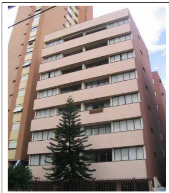
Foto 17 – Edifício Santa Paula - Edifício construído pela Construtora Dinardi em 1982, à Rua Prefeito Hugo Cabral, 1.161, com 8 pavimentos e 28 apartamentos com 71,73m 2 de área. Fonte: Passos, Viviane Rodrigues de Lima, 2006.
