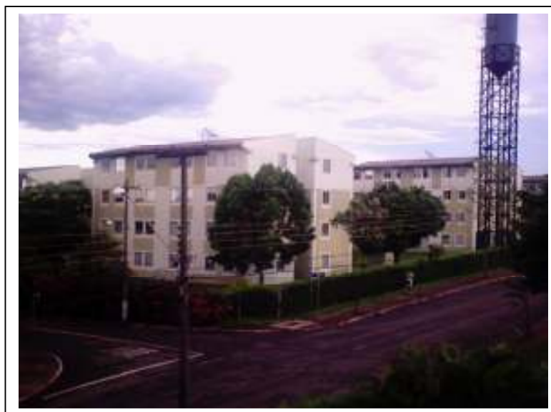
Foto 19 – Residencial América do Norte II – Construído pela Santa Cruz em 1991, sito à Rua Mário Oncken, 305, composto por 14 blocos de 4 pavimentos e 16 unidades cada, sendo que 4 blocos apresentam unidades de 48,05m 2 e os demais com apartamentos de 62,07m 2 . Fonte: Passos, Viviane Rodrigues de Lima, 2006.
