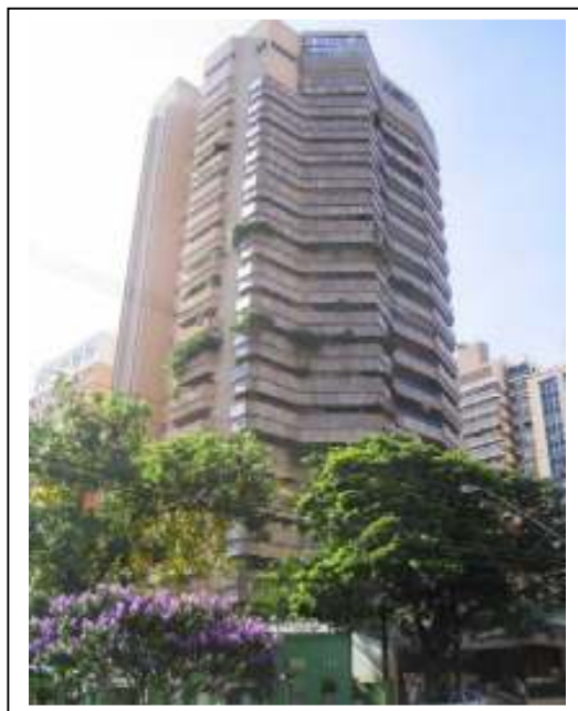
Foto 24 – Edifício Imperador – Construído pela Brastec em 1986, pelo sistema de condomínio, sito à Avenida Higienópolis, 562, com 20 pavimentos e 18 apartamentos com 381,6m 2 . Fonte: Passos, Viviane Rodrigues de Lima, 2006.
