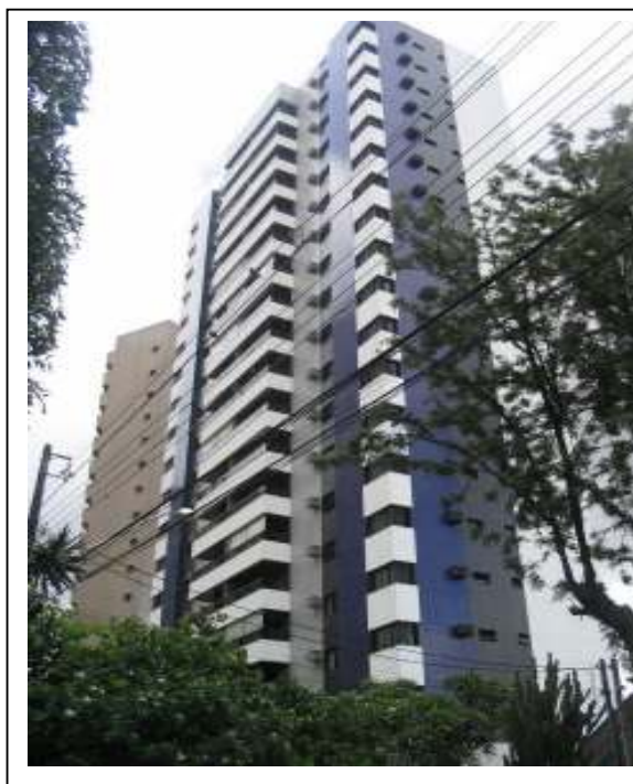
Foto 15 – Edifício Philadelpho Garcia Solar - Edifício construído em 1986 pela Construtora Plaenge, à Rua Belo Horizonte, 1.445, com 20 pavimentos e 40 apartamentos com 292,57m 2 .
