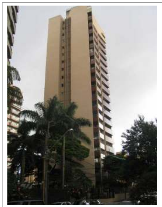
Foto 07 – Edifício Embaixador construído pela Construtora Brasília em 1979, situado à Rua Belo Horizonte, 734. É um edifício de 20 pavimentos com 18 apartamentos, com área de 245,15 m 2 . Fonte: Passos, Viviane Rodrigues de Lima, 2006.
