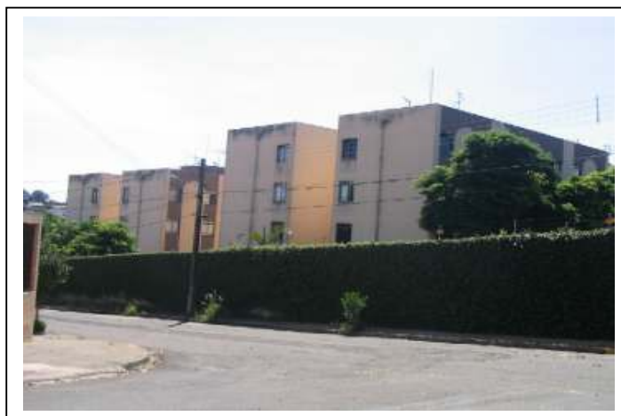
Foto 22 – Residencial Novo Horizonte - Construído pela Artenge em 1987, à Rua Serra do Maracajú, 70, composto por 9 prédios de 4 pavimentos e unidades com 59,73m 2 e 66,26m 2 . Fonte: Passos, Viviane Rodrigues de Lima, 2006.
