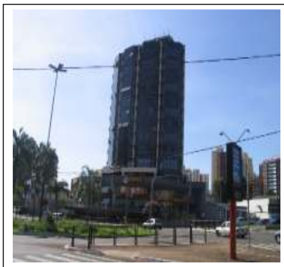
Foto 25 – Edifício Pioneiros do Café – Construído pela Brastec em 1986 pelo sistema de condomínio, sito à Avenida Higienópolis 1.100, com 13 pavimentos, de uso comercial, com área total de 5.541,66m 2 . Fonte: Passos, Viviane Rodrigues de Lima, 2006.
