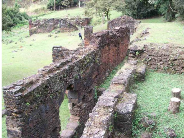
Figura 7: Ruínas Fábrica de Ferro Patriótica, Ouro Preto, MG. Foto: Defender, s/ data 69 .
