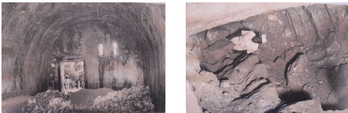
Figura 30: Vista do interior da Casa da Pólvora com as obras de escavações e foto que evidencia a profundidade das escavações. Fotos: Arquivo IPHAN, s/ data.
