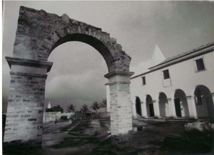
Figura 12: Ruínas Convento de N. Senhora de Nazaré. Cabo de Santo Agostinho, PE. Arquivo IPHAN, 1960.
