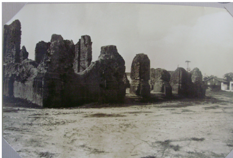
Figura 21: Fachada Sul das ruínas de Vila Bela da Santíssima Trindade, MT. Foto: Arquivo IPHAN, 1984.
