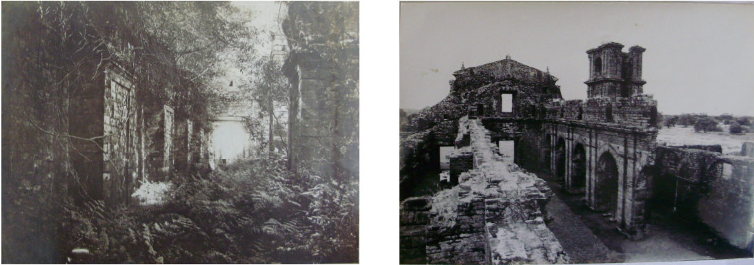
Figura 6: Ruínas de São Miguel das Missões a partir de seu interior nos anos de 1928 e 1982, respectivamente. Fotos: Arquivo IPHAN, 1928; 1982.
