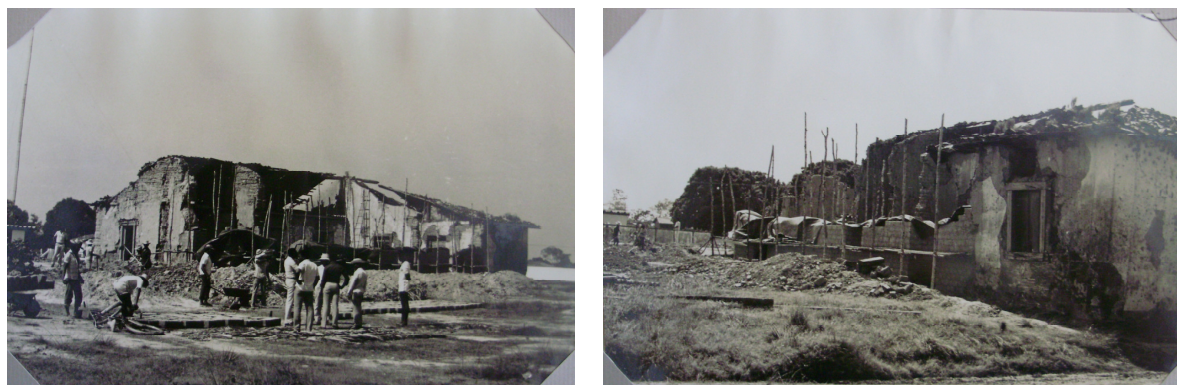
Figura 22: Palácios dos Capitães e o seu canteiro de obras. Detalhe. Foto: Arquivo IPHAN, 1984.
