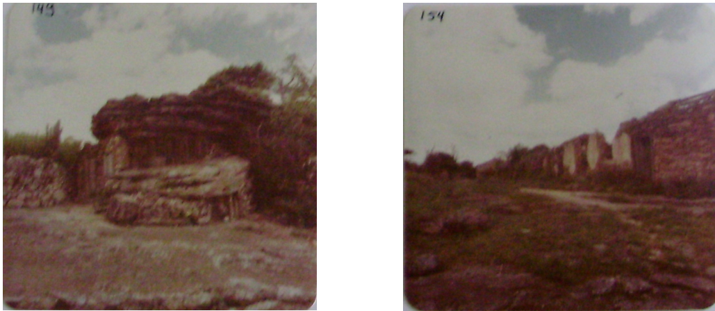
Figura 23: Ruínas das locas presentes no conjunto arquitetônico, urbanístico e paisagístico de Igatu, Andaraí, Bahia. Foto: Arquivo IPHAN, 1982.
