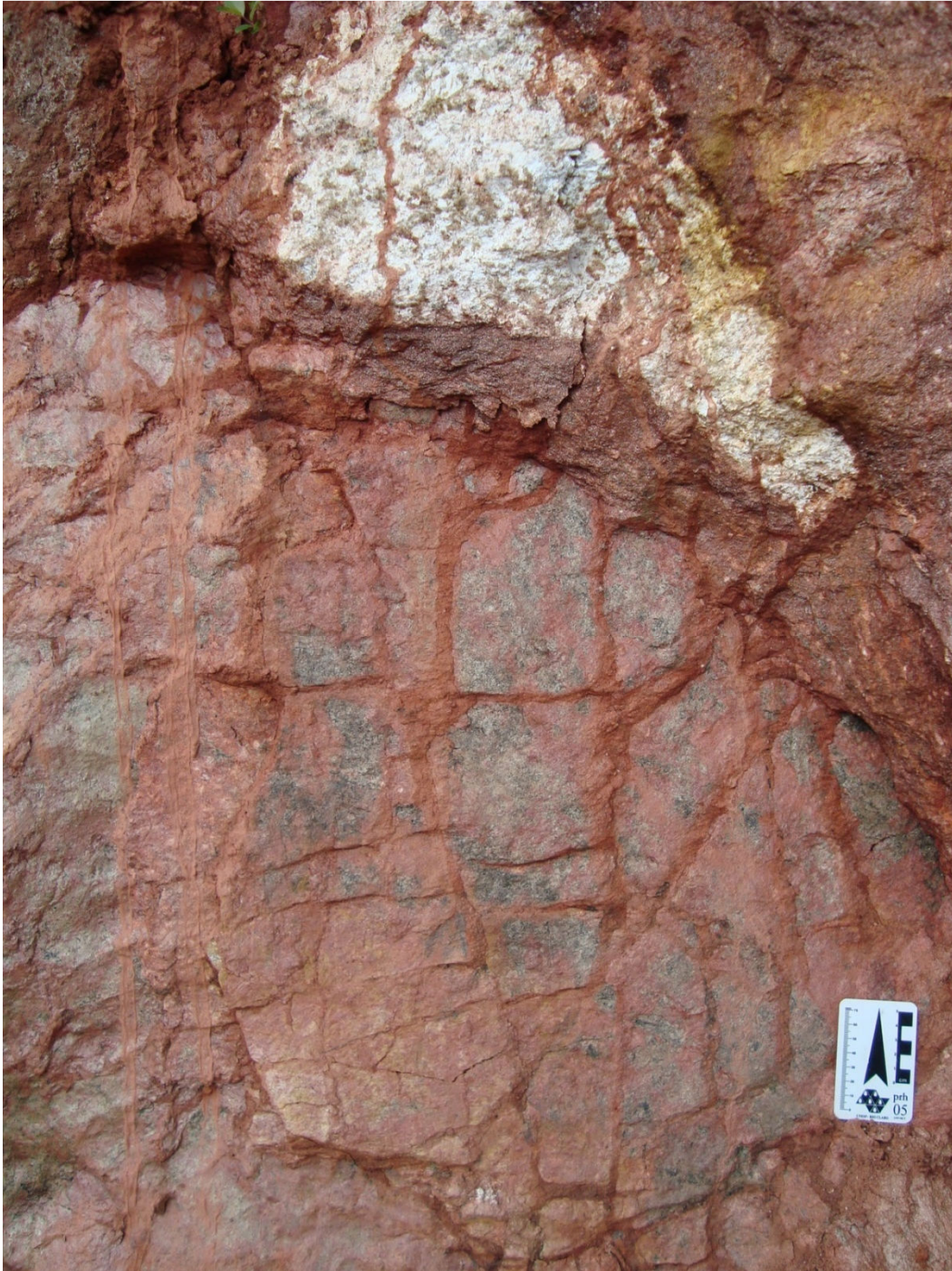
Figura 25 - Fraturas em rocha xistosa, abertas, preenchidas por argila, formando sistema conjugado. Ponto 04, rumo da foto: azimuth 75.
