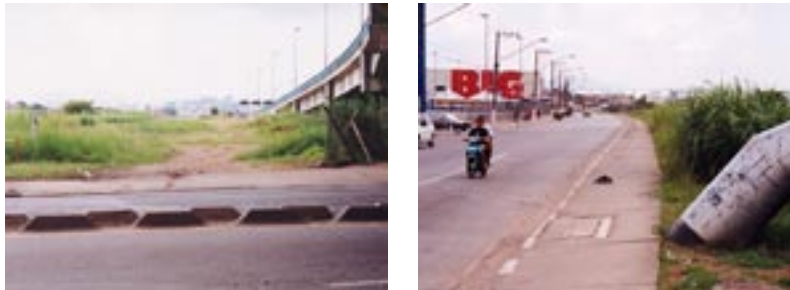
Fig. 92 e 93. Fotos antes da intervenção.
