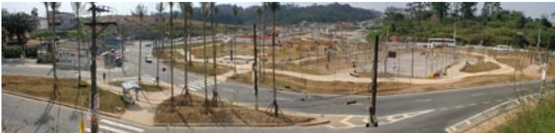
Fig. 89. Foto antes da intervenção – fevereiro de 2002.
