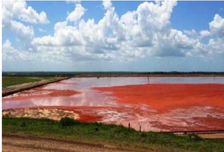
Figura 3.1: Reservatório de lama vermelha da Alumar (Ilha de São Luís - Maranhão)
