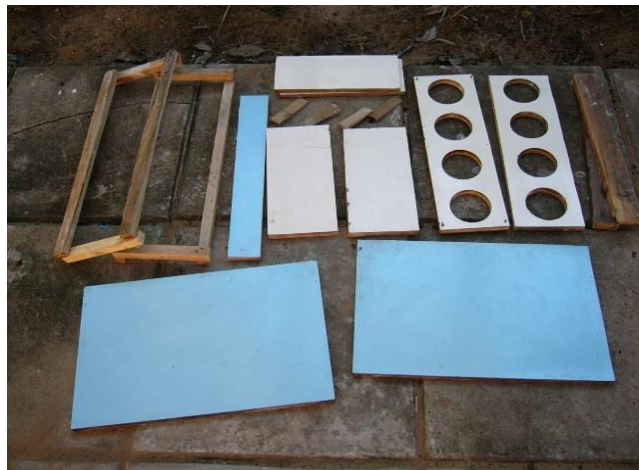
Figura 17: Componentes da forma.
