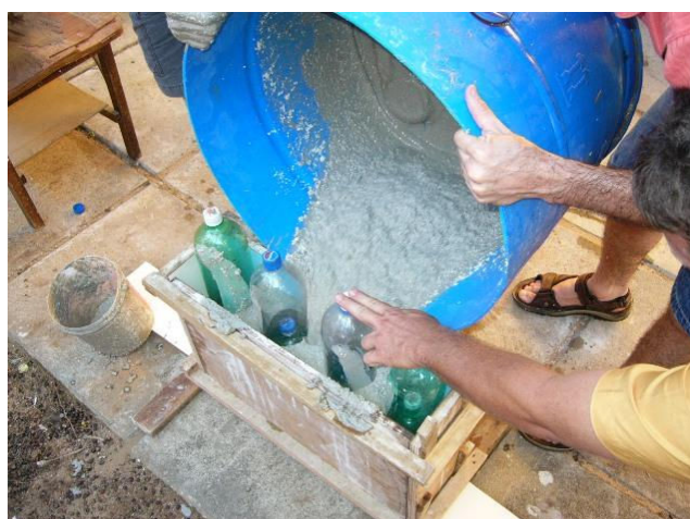
Figura 25: Enchimento da forma com o compósito.
