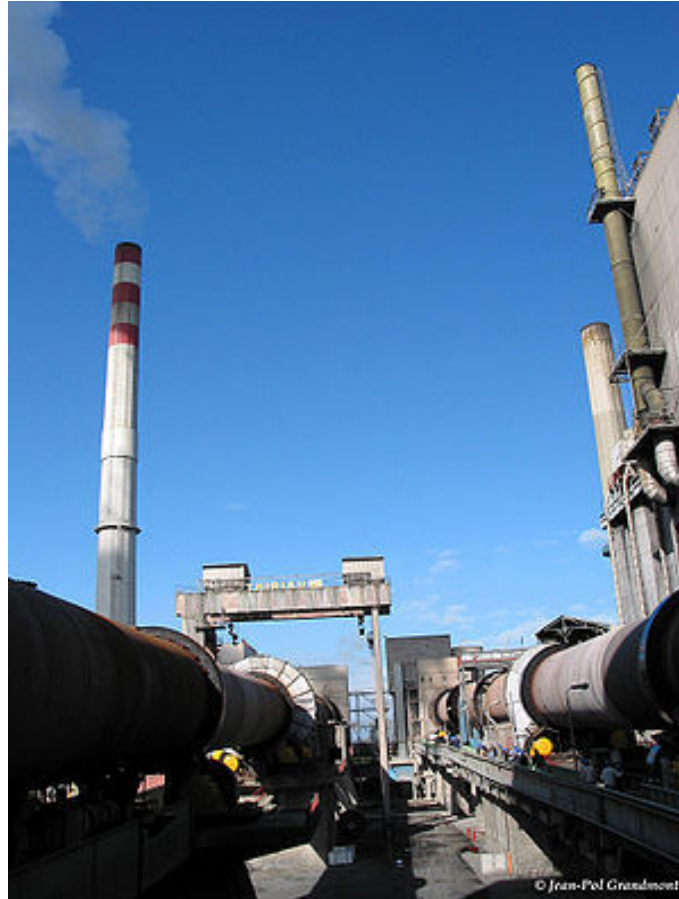
Figura 11: Fornos Rotativos de Cimento - Holcim – Bélgica.
