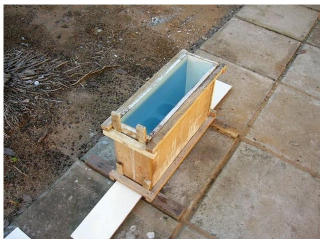
Figura 19: Montagem final da forma.
