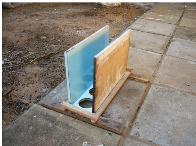
Figura 18: Montagem da base e paredes laterais da forma.
