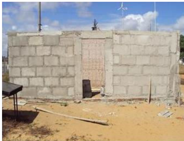
Figura 30. Vista da parede “Leste” com todos os blocos assentados.
