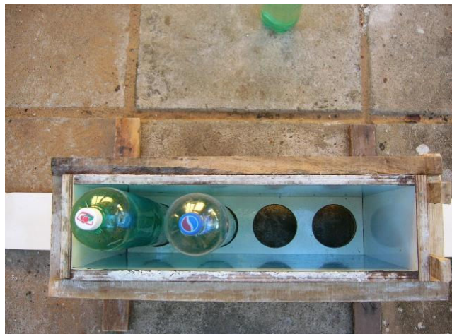
Figura 21: Posicionamento das garrafas no interior da forma.
