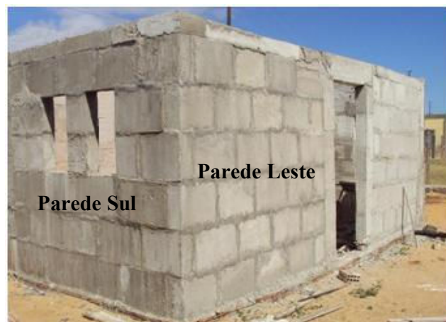
Figura 31. Vista das paredes Leste e Sul com todos os blocos assentados.
