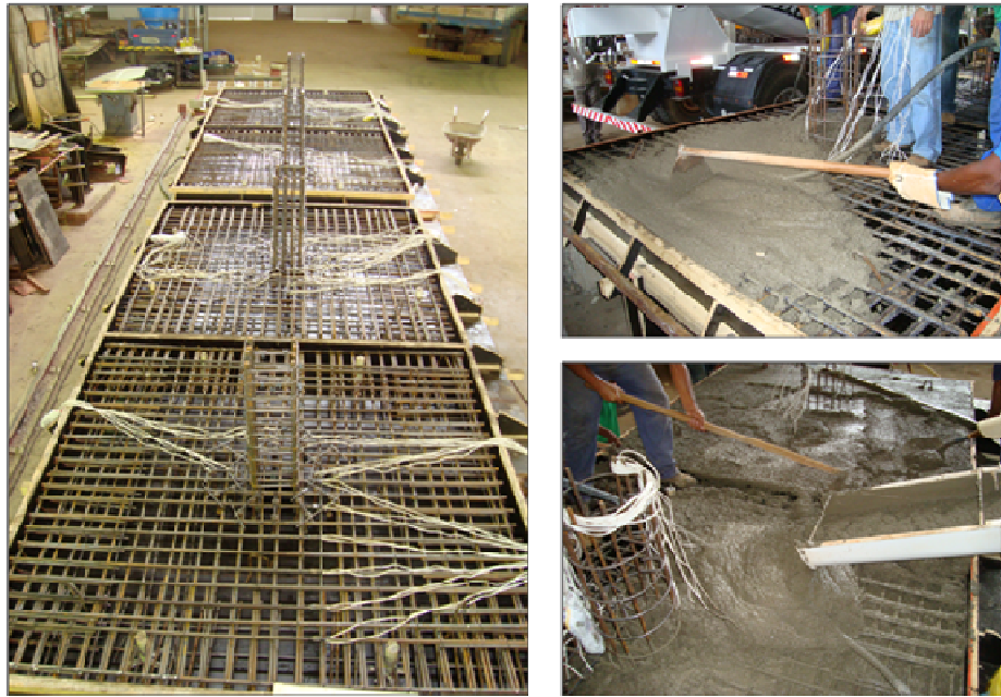
Figura 3.24 – Concretagem das lajes
