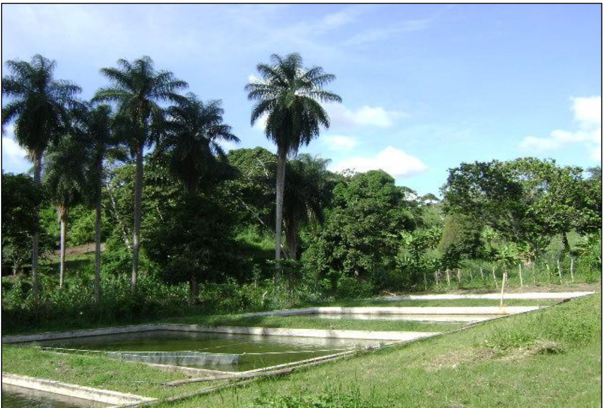
Figura 02: Vista geral dos tanques de alvenaria com fundo de terra com sistema de abastecimento e escoamento individual (módulo de piscicultura – UFPB – Campus II).
