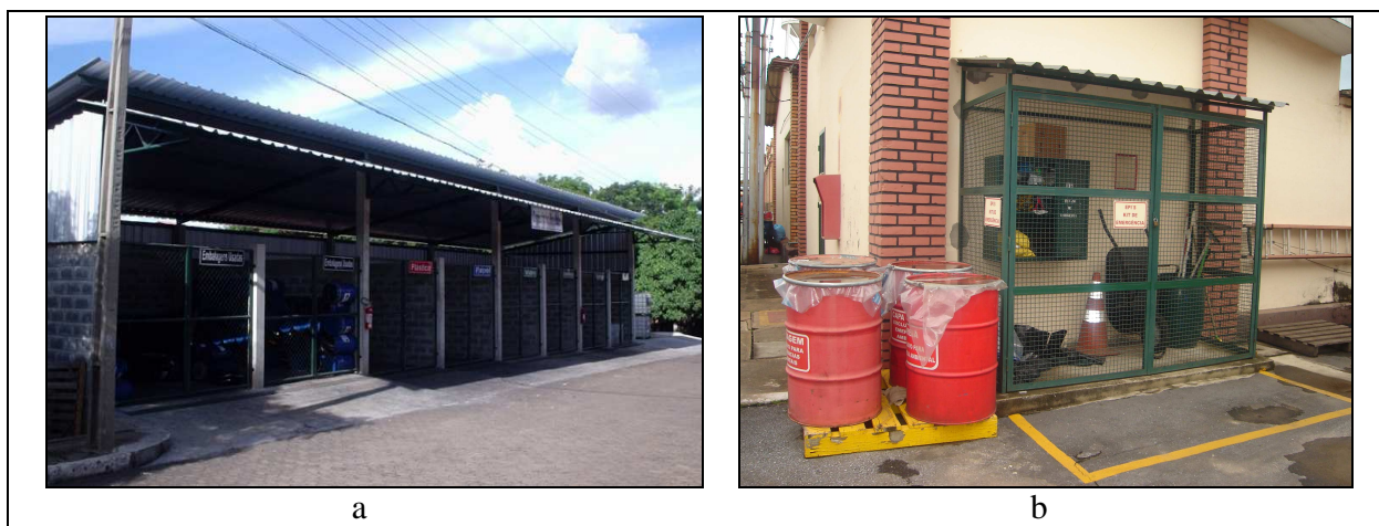
FIGURA 6.6 - Local de armazenamento de resíduos e kit de emergência da empresa X
