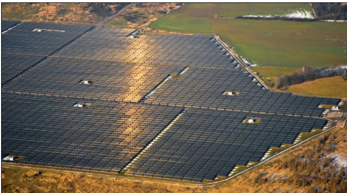
Figura 7 – Grid-connected centralized em Solarpark Waldpolenz, Brandis, Alemanha. Fonte: pvresources.com
