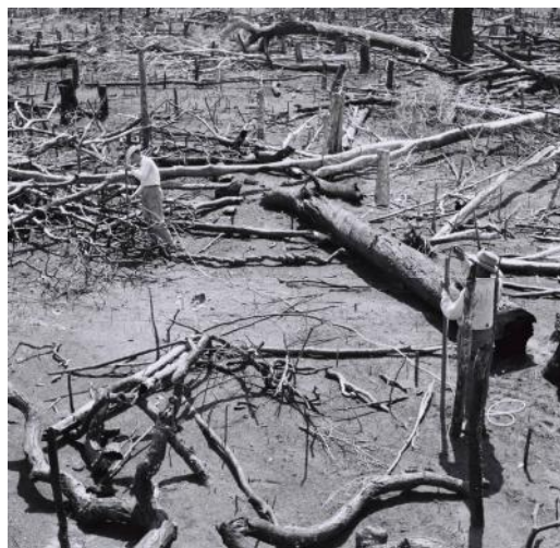
Figura 22 – Locação de niveladas básicas com nível de borracha. Fazenda Santa Rosa. Prop. Francisco Cisneros Sanches. Nova Londrina, Paraná. 1958 Fotografias: Armínio Kaiser
