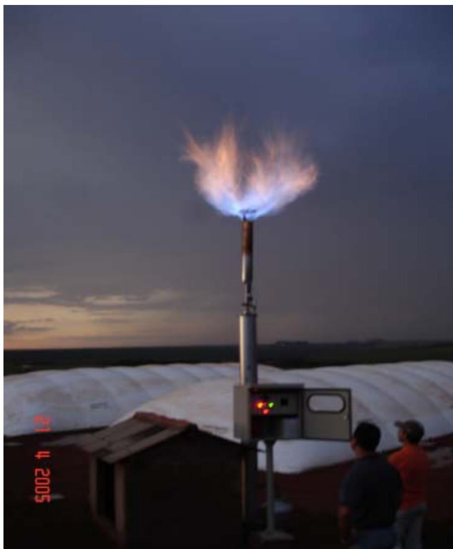
FIGURA 3.14 – Queima do biogás pelo flare.
