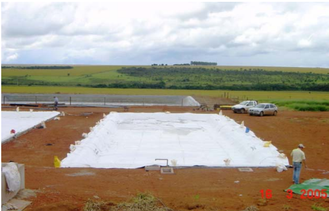
FIGURA 3.10 – Instalação de gasômetro de PVC (câmara de gás).
