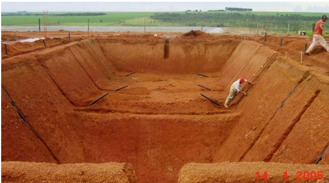
FIGURA 3.5 – Instalação de tubulações.
