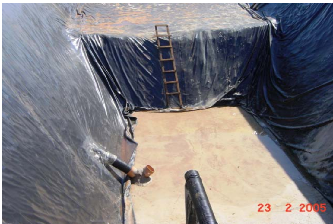
FIGURA 3.8 – Acabamento das tubulações.
