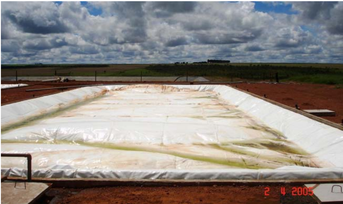
FIGURA 3.11 – Início do enchimento do gasômetro.
