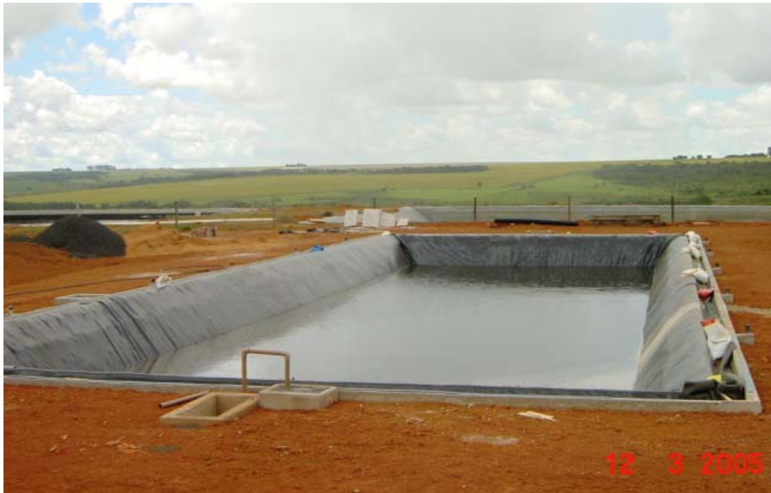
FIGURA 3.9 – Início de enchimento do biodigestor.
