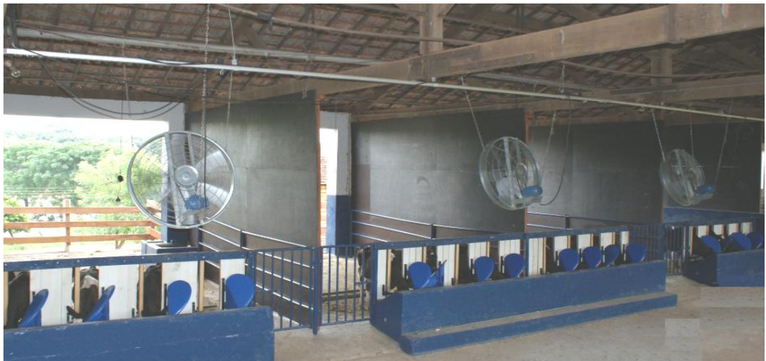
Figura 1- Visão geral das instalações.
