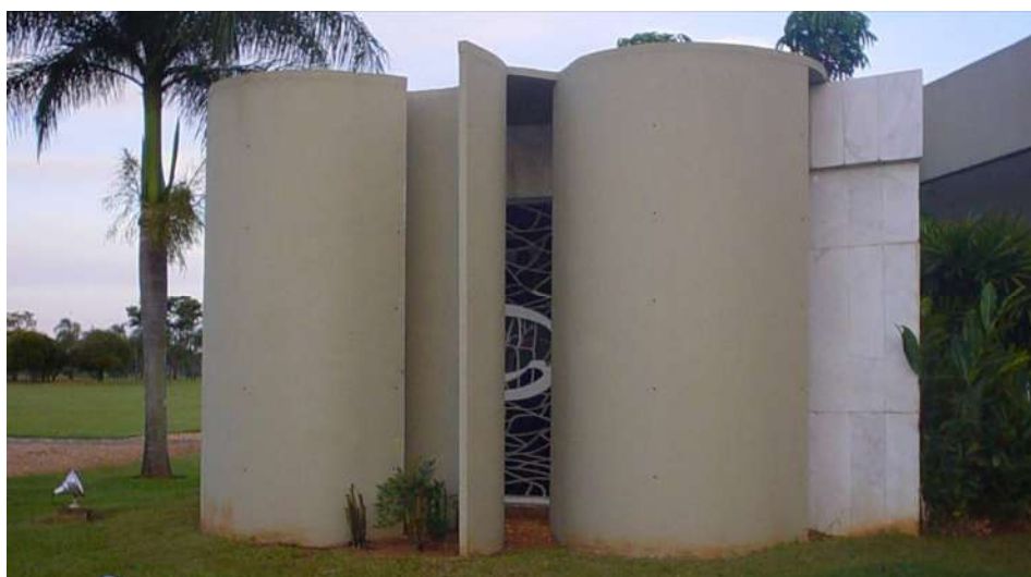
Figura 80 - Capela do Palácio Jaburu
