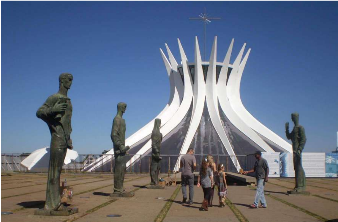
Figura 94 – Catedral ainda em reforma, já com metade dos vitrais colocados. Fonte: Foto da autora, 25 jun. 2010.
