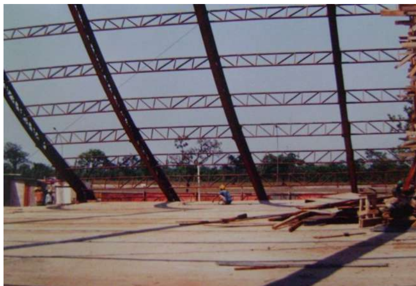
Figura 20 - Construção. Sem data. Fonte: Acervo da Catedral.
