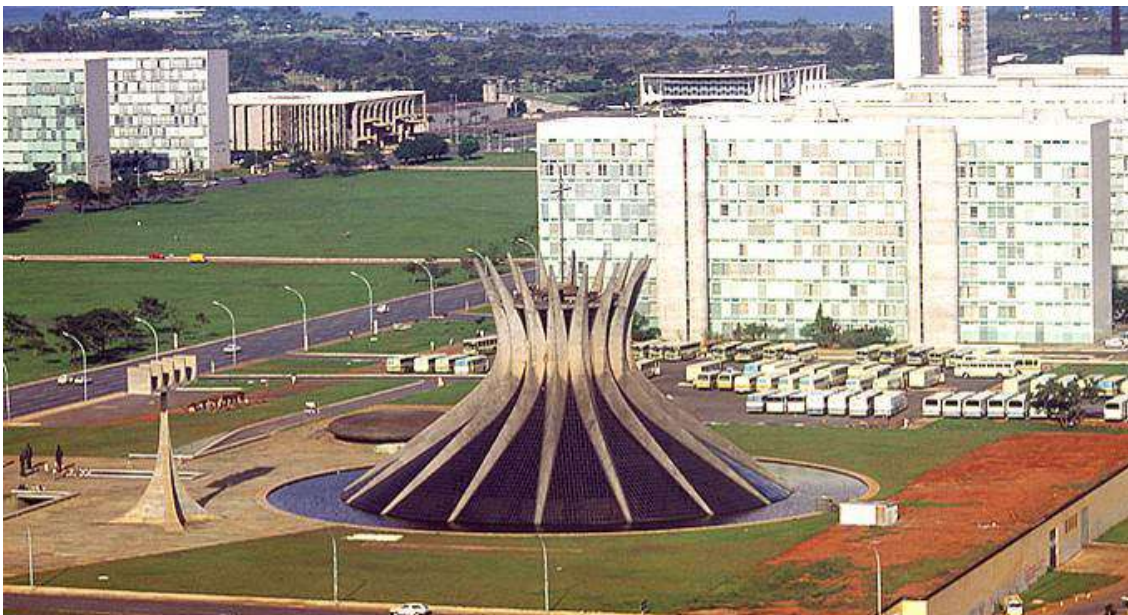
Figura 74 – Catedral antes da reforma.
