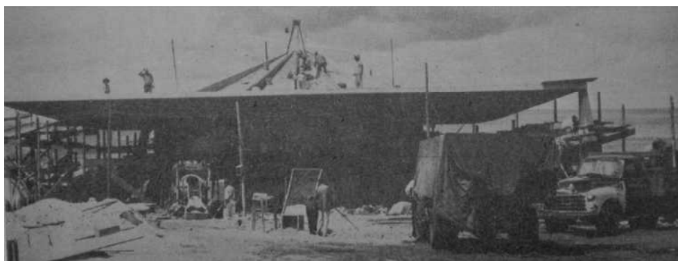
Figura 26 - Igreja Nossa Senhora de Fátima em construção. Fonte: Brasília nº 16, abr. 1958. p. 04.
