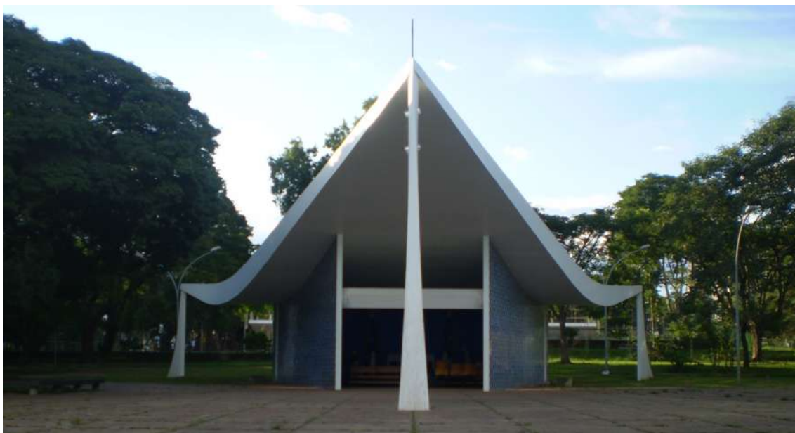
Figura 60 - Igreja Nossa Senhora de Fátima, 2010, após a restauração do IPHAN. Fonte: foto da autora.
