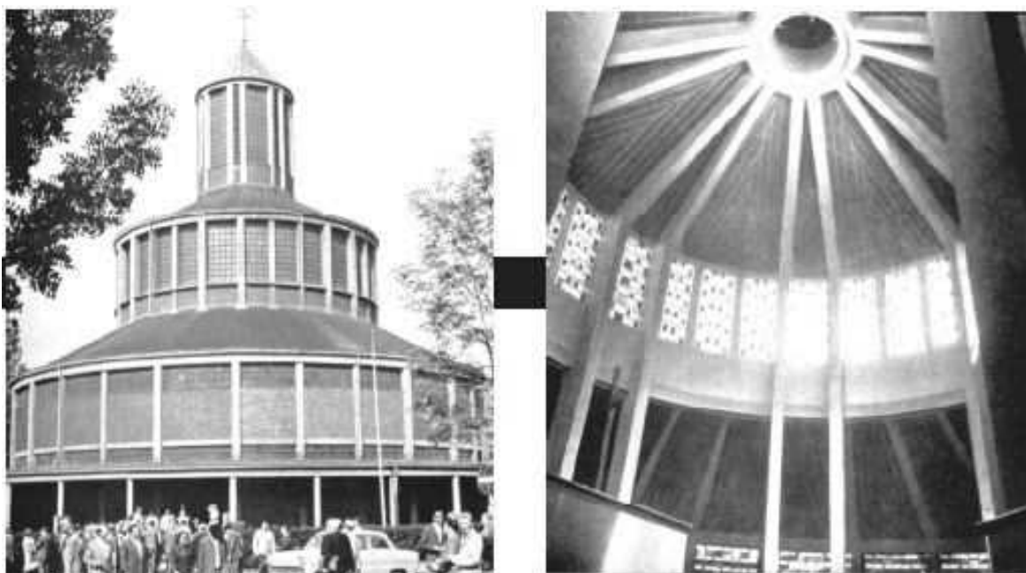
Figura 9 - Auferstehungskirche ou Igreja da Ressurreição, Otto Bartning, 1929/30.
