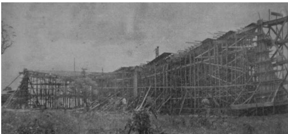
Figura 24 – Igreja Nossa Senhora de Fátima em construção. Fonte: Brasília nº 15, mar. 1958. p. 02.
