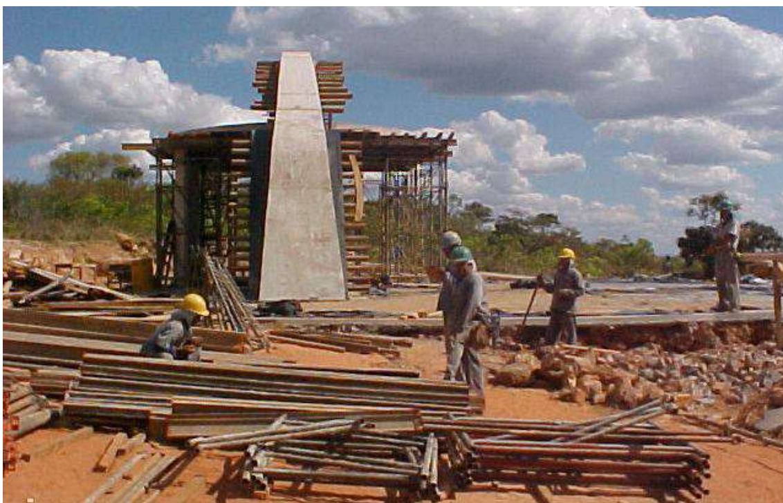
Figura 8 - Capela em Obras, 2005. Fonte: Acervo de Natanry Osório, 22 ago 2005.
