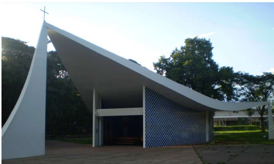
Figura 56 - Igreja Nossa Senhora de Fátima, 2010, após a restauração do IPHAN Fonte: foto da autora
