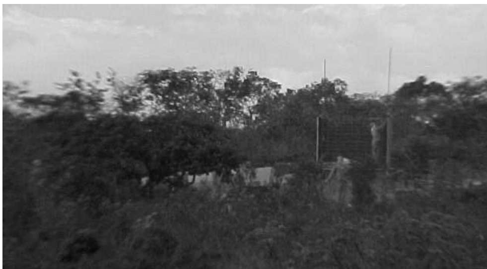
Figura 5 - Início da obra. 2005 Fonte: Acervo de Natanry Osório, 22 ago 2005.
