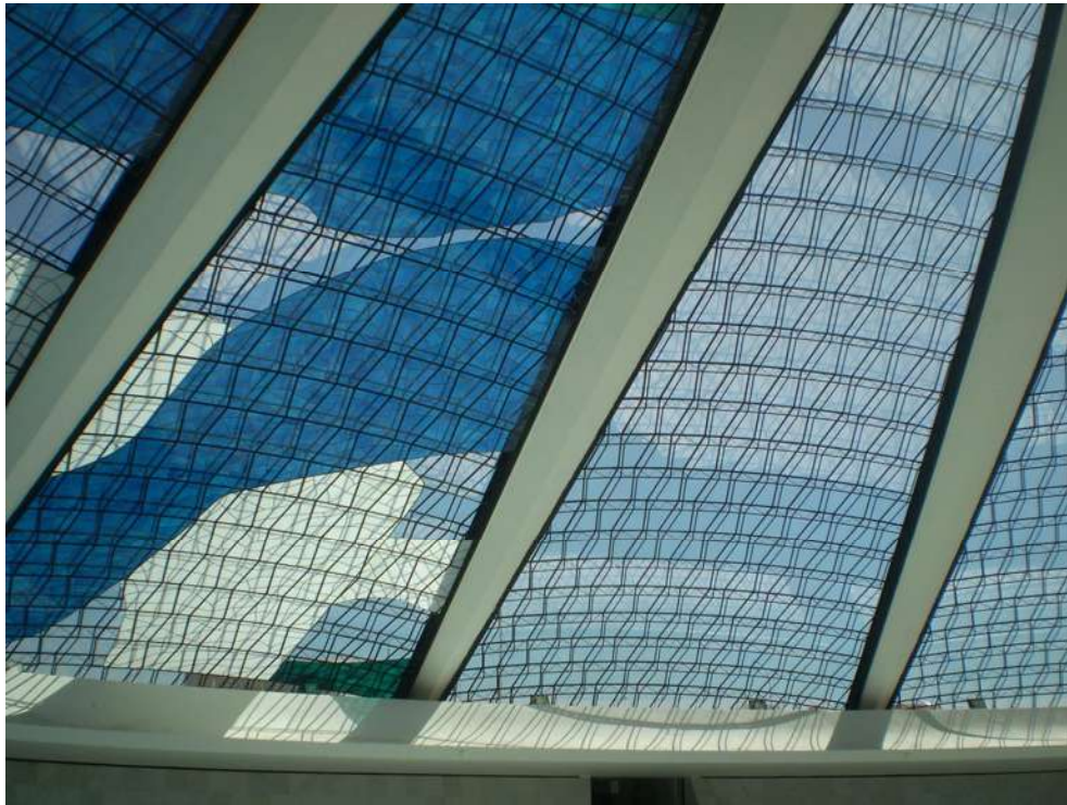
Figura 96 - Catedral ainda em reforma, já com metade dos vitrais colocados. Fonte: Foto da autora, 25 jun. 2010.
