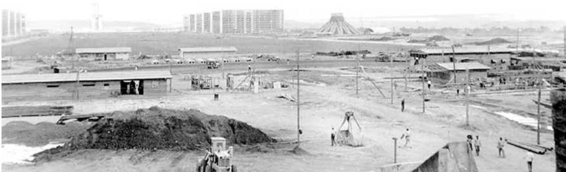
Figura 62 – Construção da Catedral.
