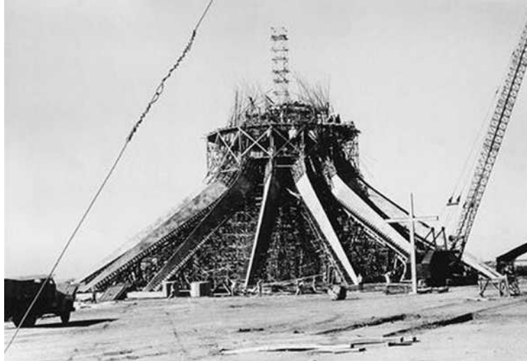
Figura 59 - Construção da Catedral.
