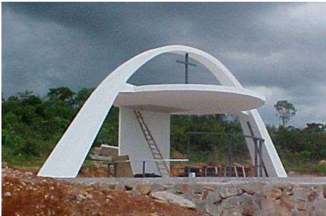
Figura 9 – Estrutura sendo pintada, Nov. 2005. Fonte: Acervo de Natanry Osório, 22 ago 2005.
