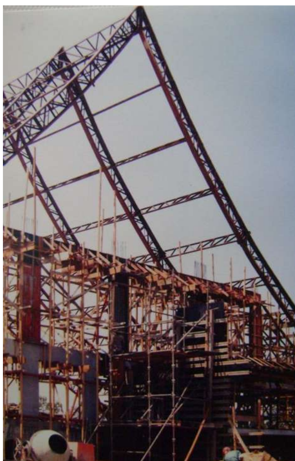
Figura 21 - Construção. Sem data. Fonte: Acervo da Catedral.
