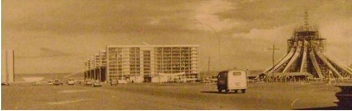
Figura 61 - Catedral em Construção.
