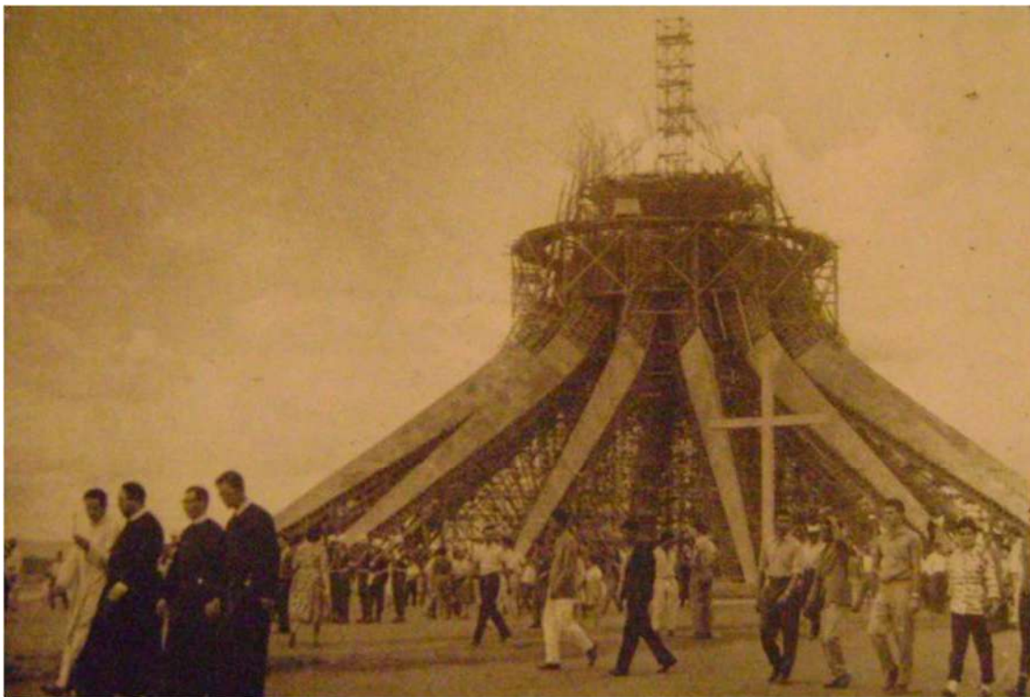
Figura 60 - Catedral em Construção.
