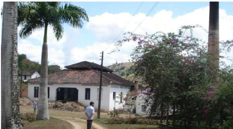
**Figura 31** Fábrica do Engenho Vaca Brava de Baixo, em alvenaria com coberta em quatro águas. Fotografia de Anna Cristina A. Ferreira, em 15/01/2009.
