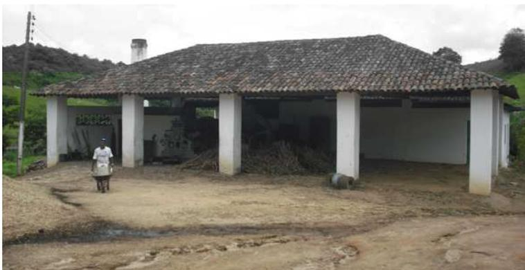
**Figura 27** Fábrica do Engenho Ipueira, em alvenaria com pilares, e coberta em quatro águas. Fotografia de Anna Cristina A. Ferreira, em 29/04/2009.
