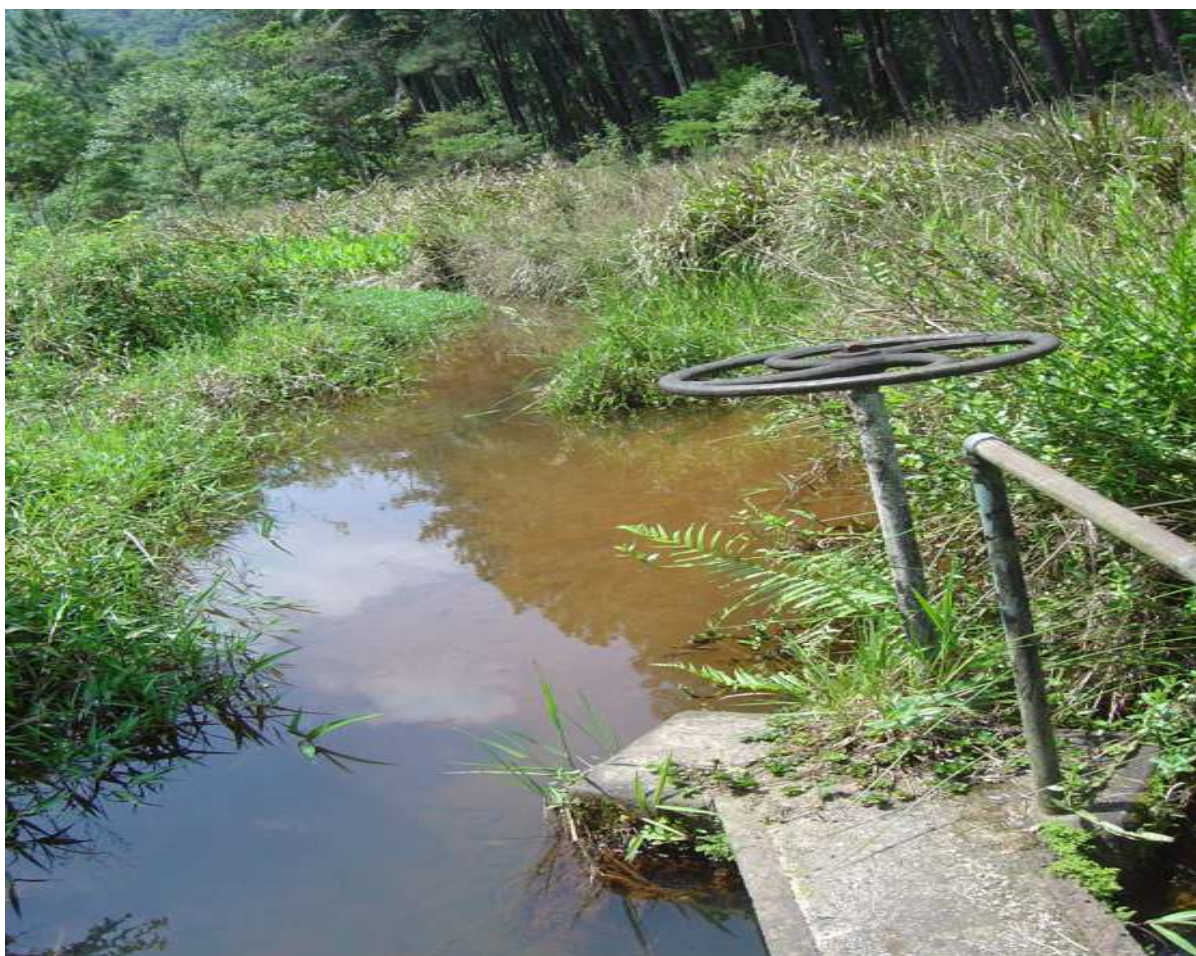
Foto de outubro de 2006, volante para a manobra da comporta ao final do passadiço.
