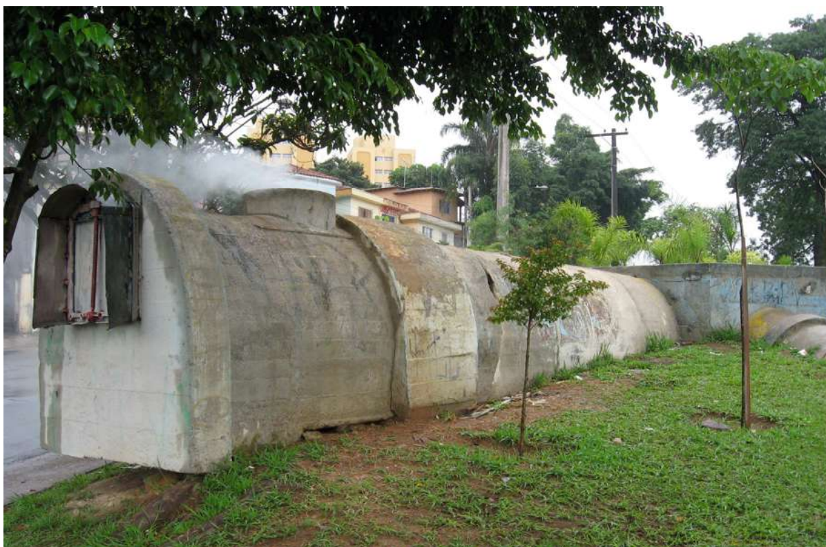
Foto de setembro de 2007, em que se vê um dos 28 sifões que constituíam o sistema de adução.
