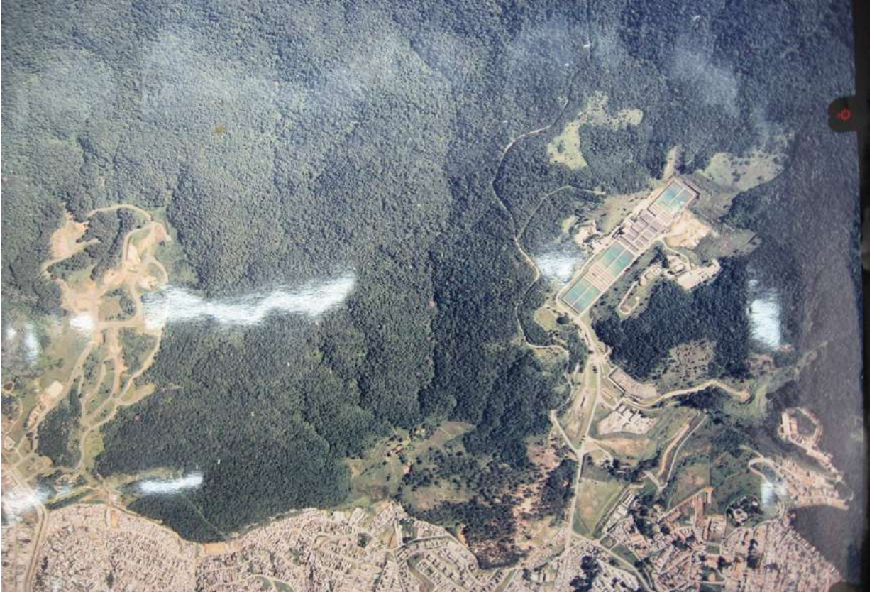
Foto aérea de 1974, logo após a inauguração da estação de tratamento do Guarapé. Acervo SABESP
