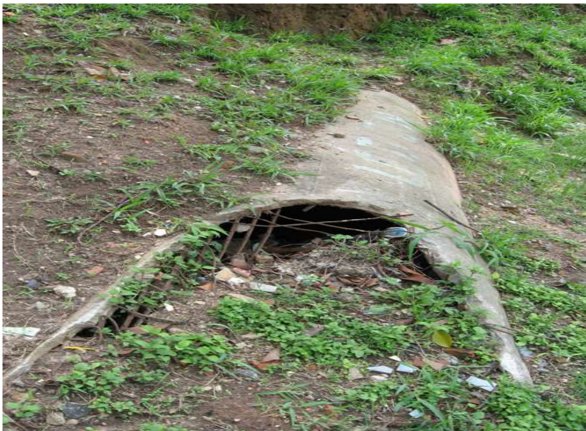
Fotos das barras de ferro do concreto armado, outubro de 2007.
