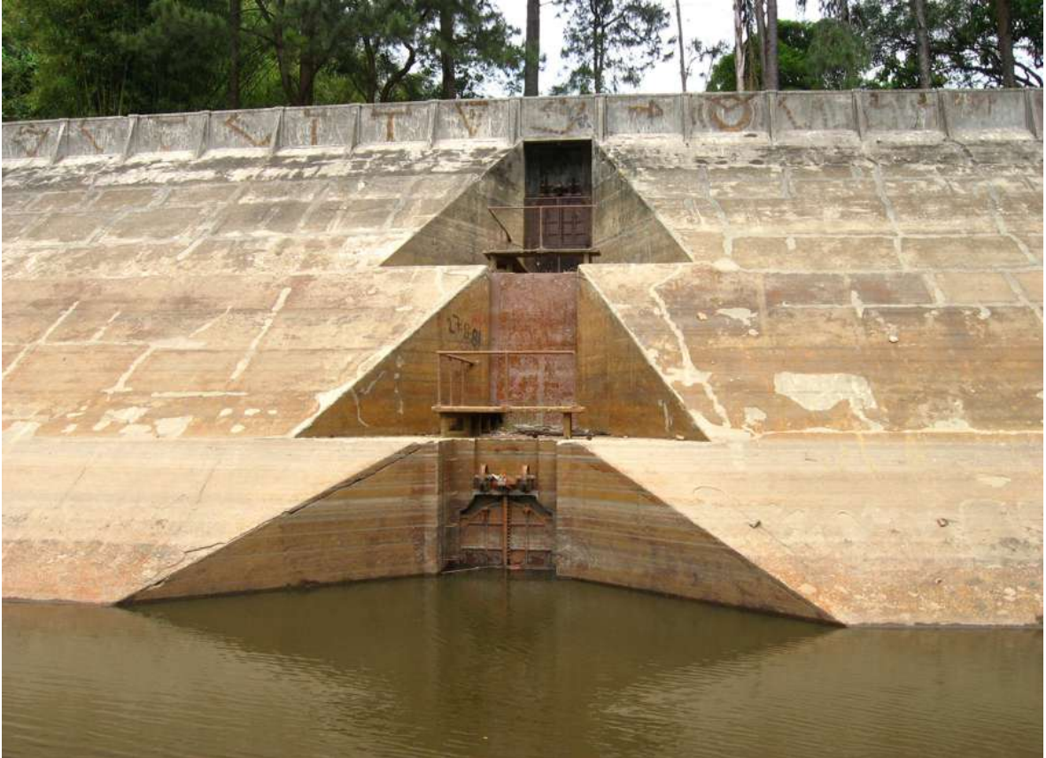
Foto de outubro de 2007, com o detalhe das três etapas das eclusas.
