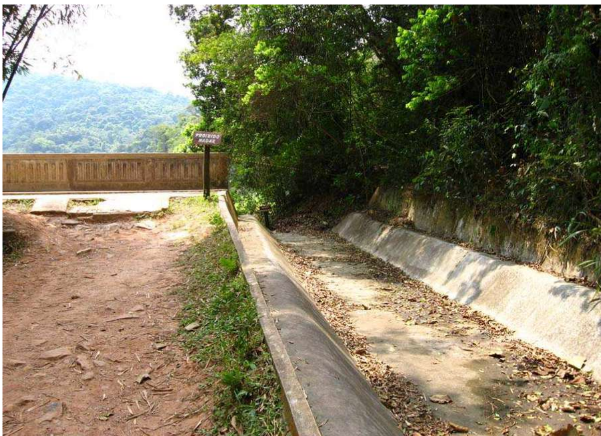
Foto de outubro de 2007 – detalhe do vertedouro.
