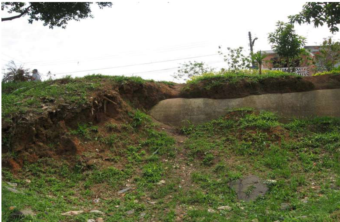
Foto da adutora, outubro de 2007.
