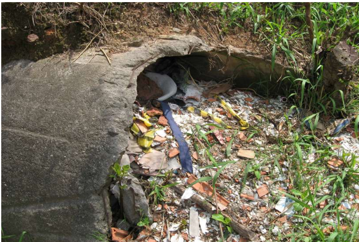
Foto da estrutura da adutora, outubro de 2007.
