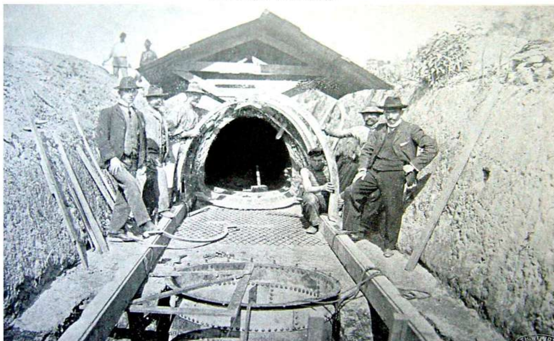
Ligação de um syphão com o aqueducto
