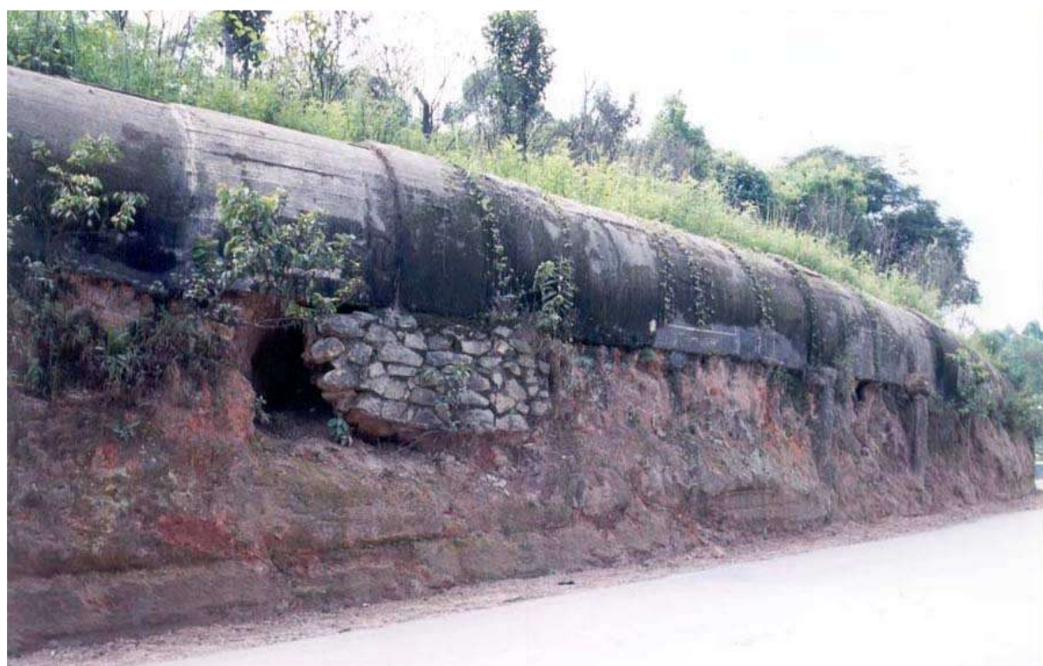
Foto da adutora, acervo Plínio Thomaz, década de 1990.
