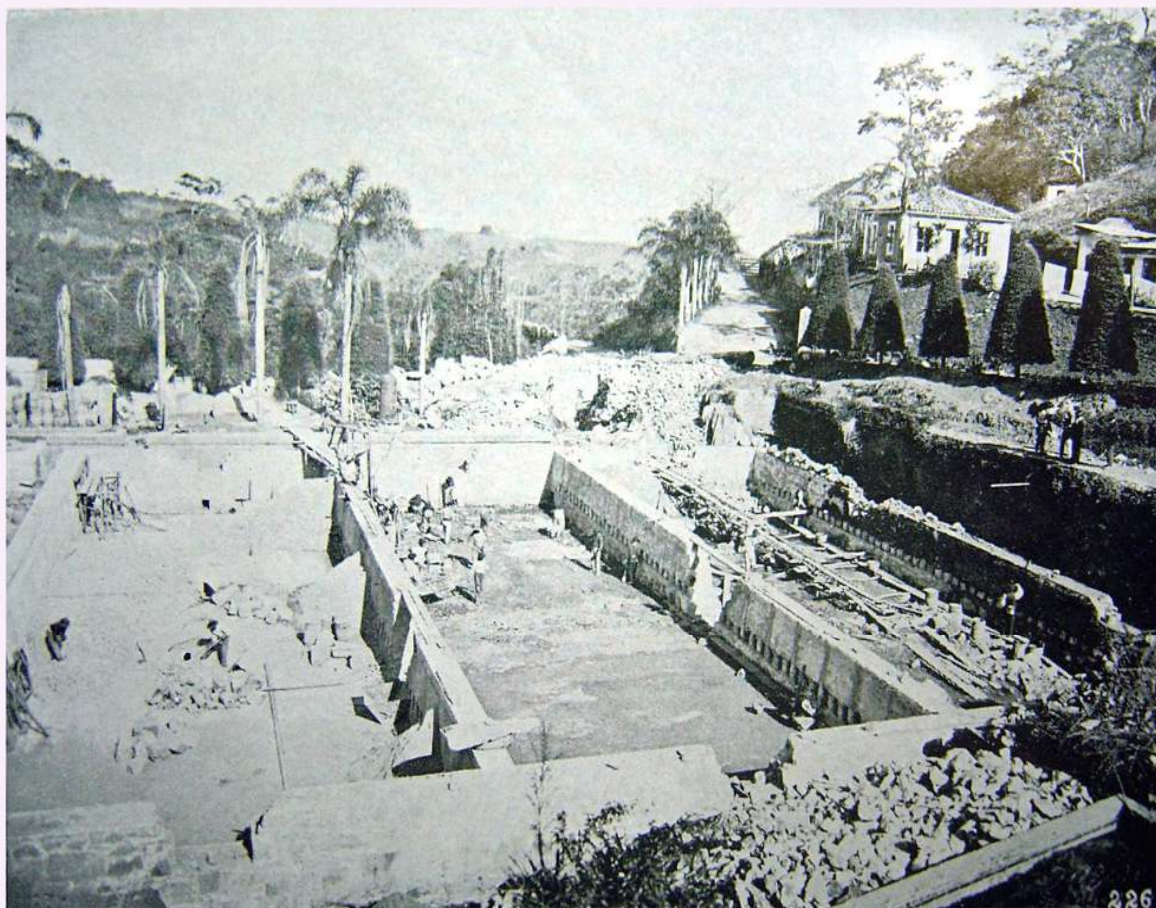
Construção do clarificador do Guarahú
