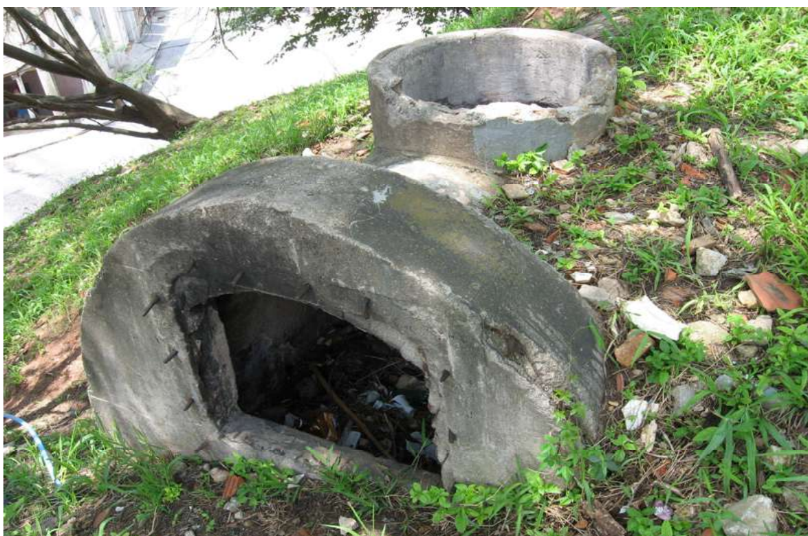
Foto de outubro de 2007, no detalhe parte do sifão.
