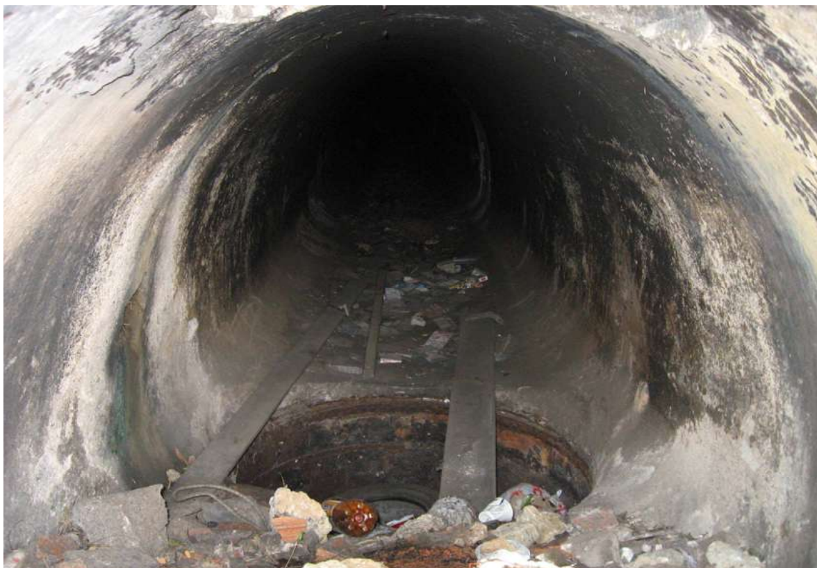
Foto de outubro de 2007, onde se vê em detalhe a ligação do aqueduto com o sifão.
