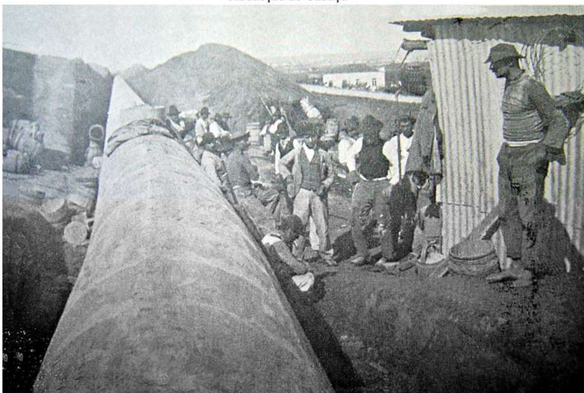
Trecho do aqueduto de cimento armado proximo a Sant' Anna
