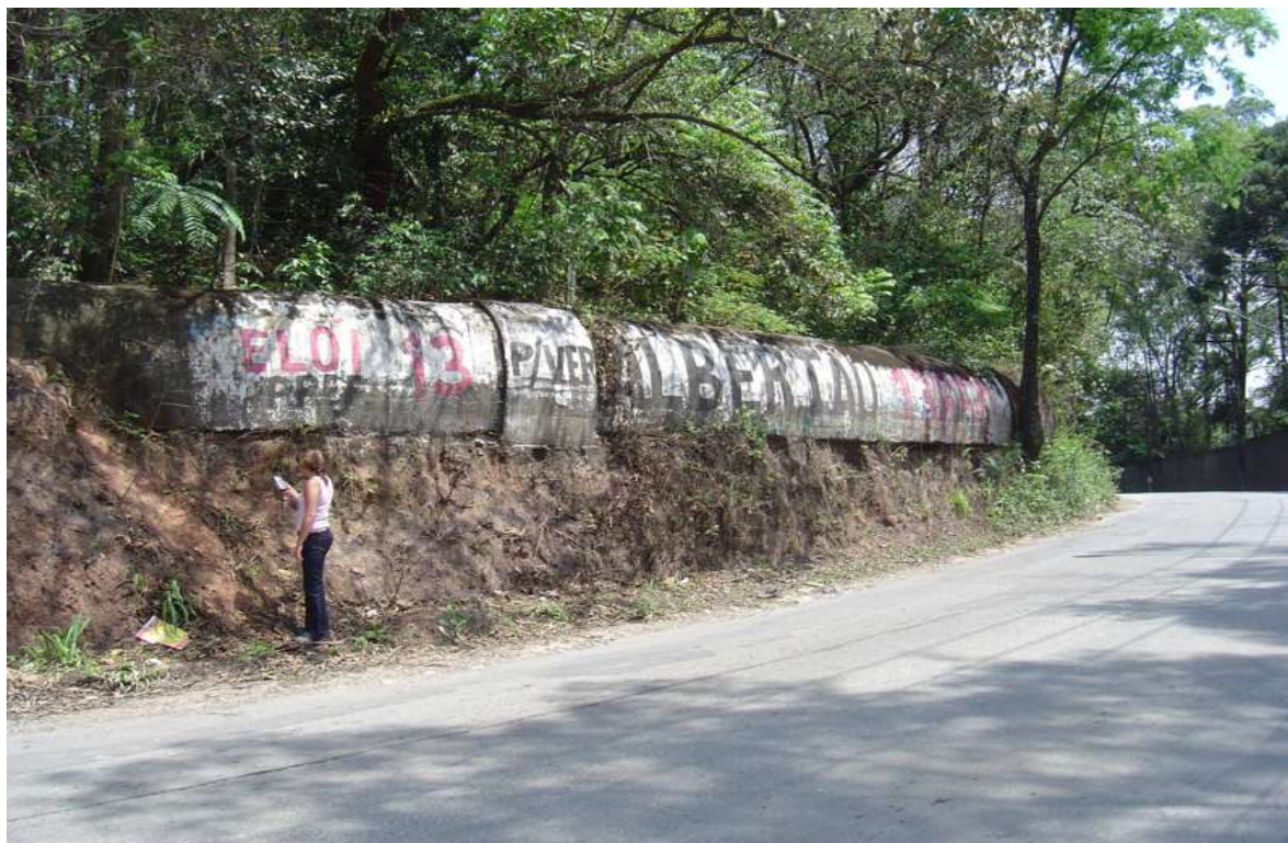
Foto da adutora no mesmo ângulo, outubro de 2006.
