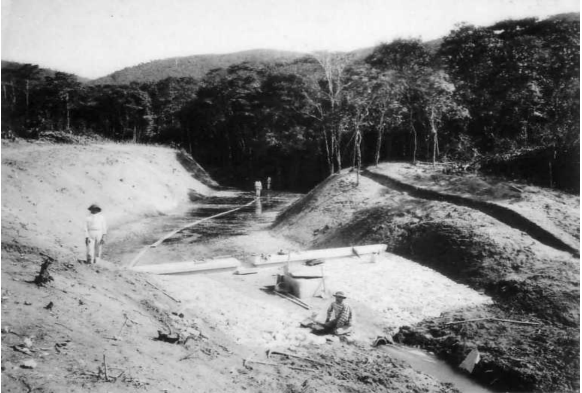
Foto P.Doumet 1894. Construção da pequena barragem do Engordador.
