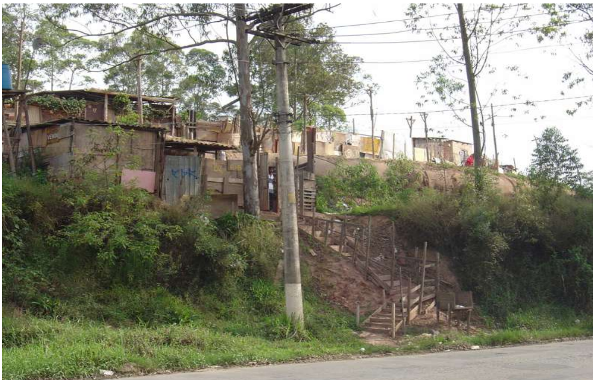
Foto da adutora em outubro de 2006.
