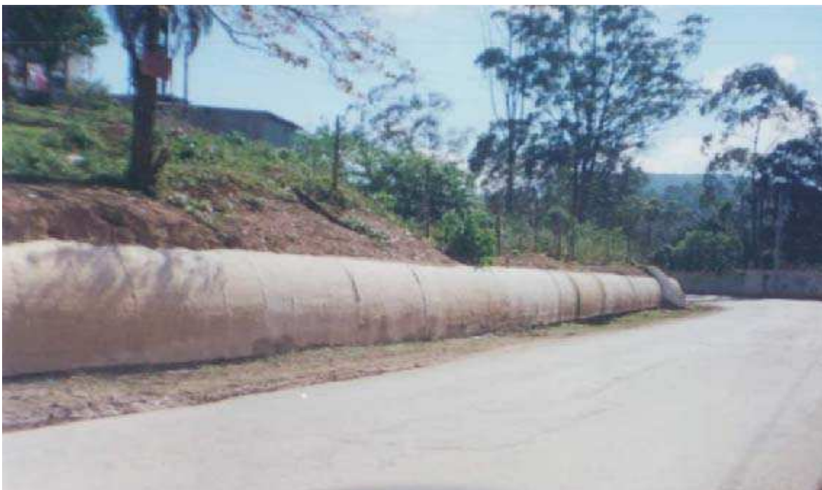
Foto da adutora na Estrada do Cabuçu, do acervo particular da Empresa Hagaplan Engenharia, 1990.
