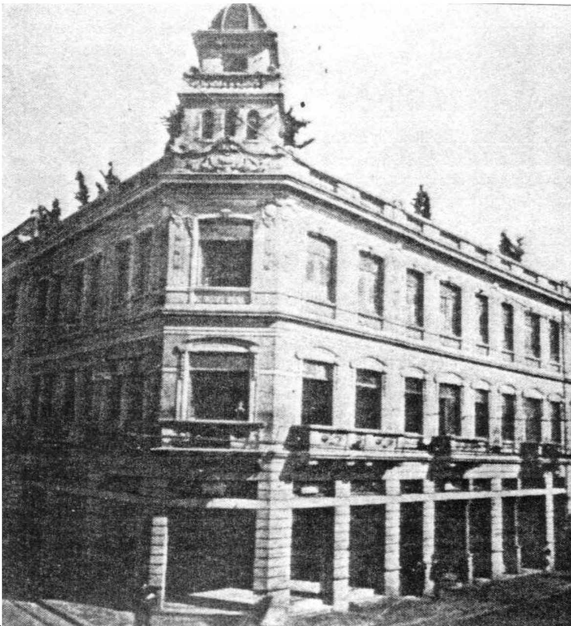
Prédio de concreto armado na rua São Bento (1909), do livro “O Concreto no Brasil – Recordes, Realizações, História” de Augusto Carlos de Vasconcelos. Coleção do autor
