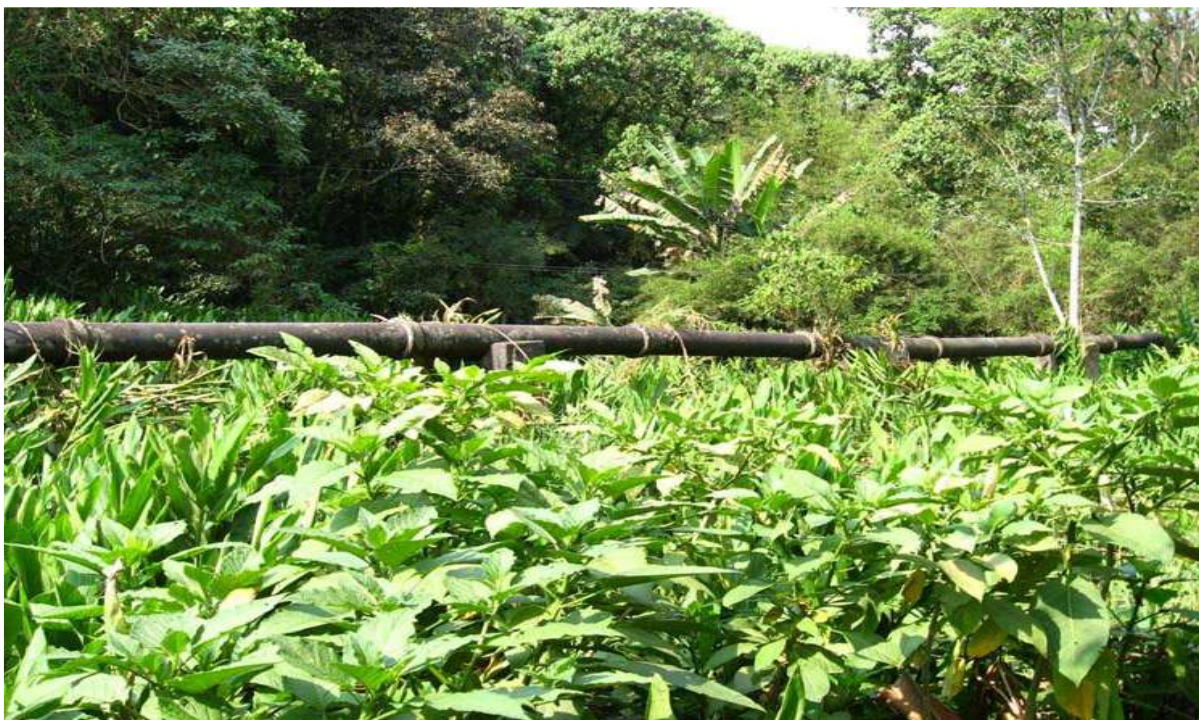
Foto de outubro de 2007, adutora que conduzia as águas da represa em direção à caixa do Gonçalves, para a rede distribuidora.
