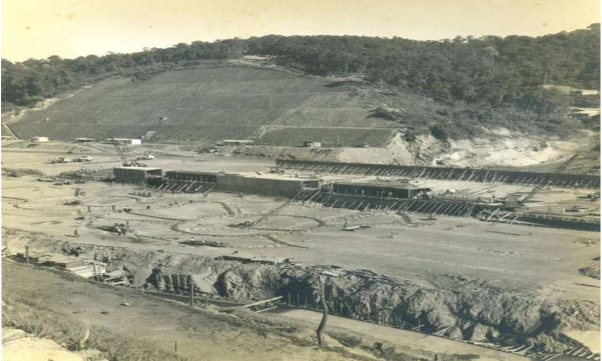
Início da construção da Estação de Tratamento do Guarapé, na década de 70, acervo SABESP
