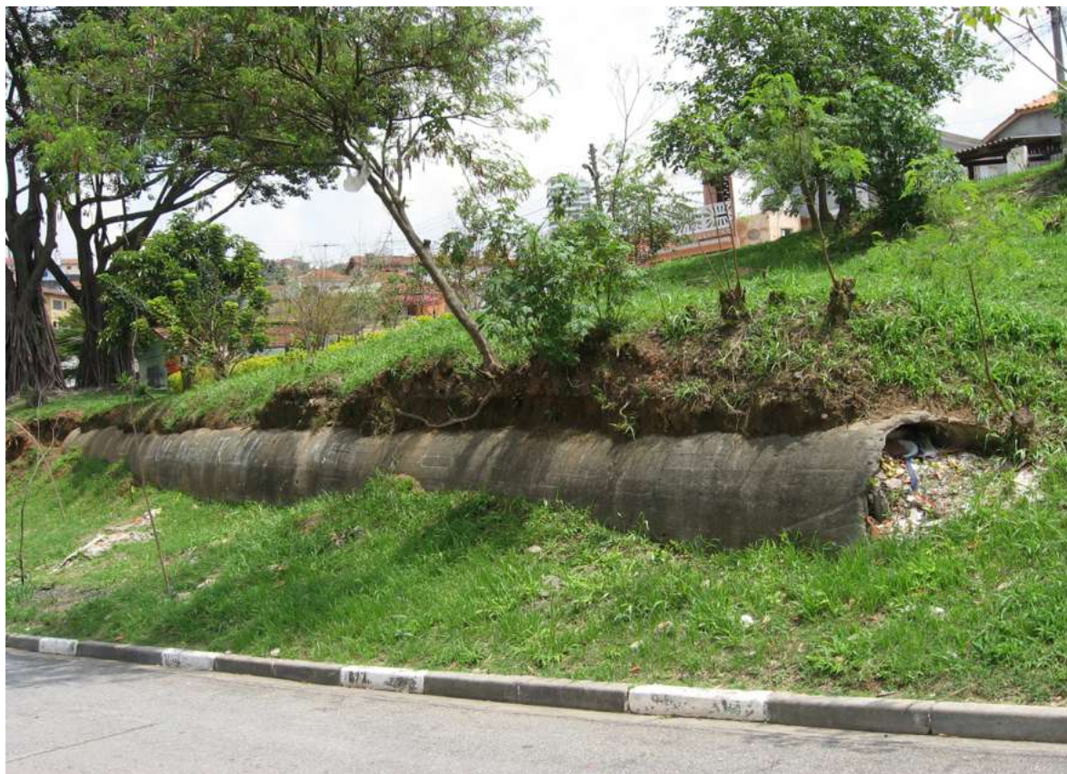
Foto da adutora, outubro de 2007
