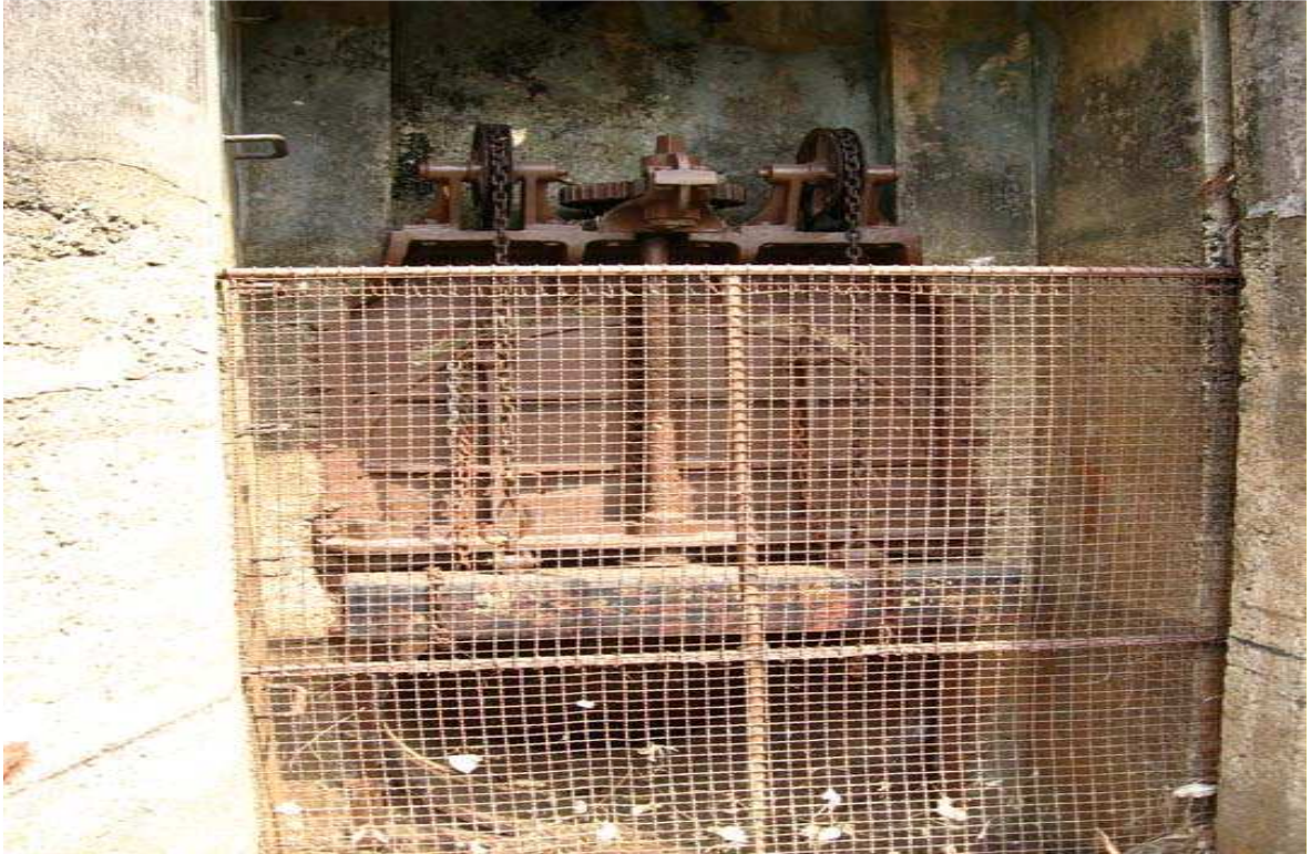
Foto de outubro de 2007. Grades de proteção do sistema de engrenagens das comportas.
