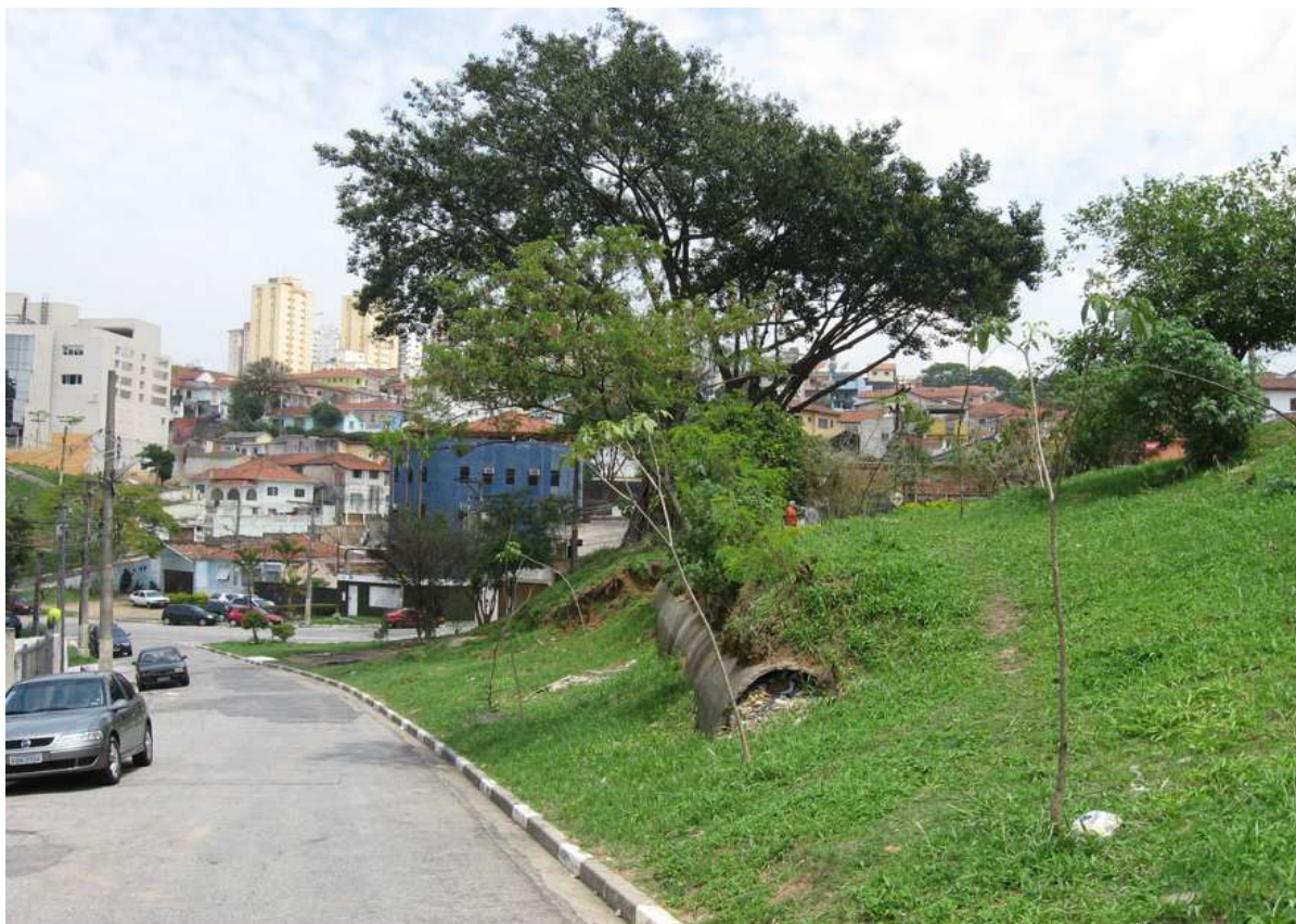
Foto da adutora, outubro de 2007
