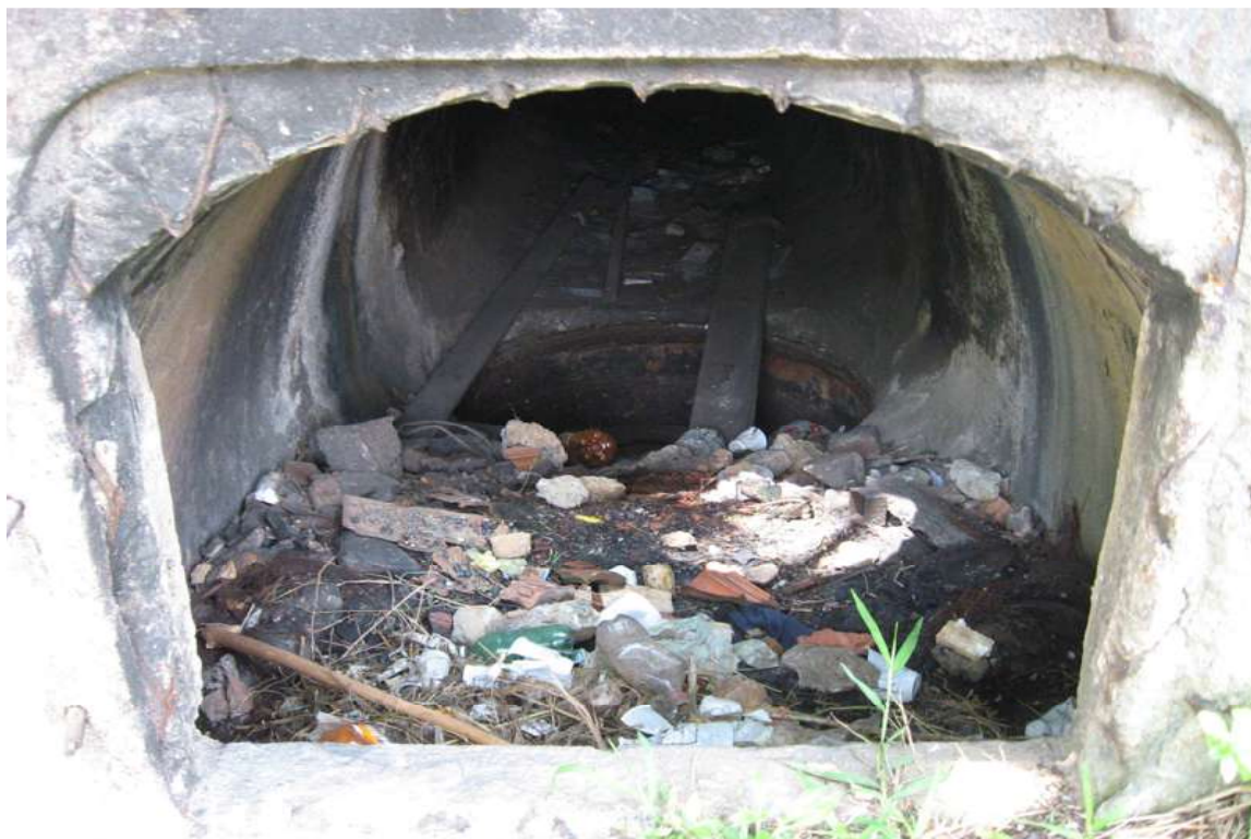
Foto de outubro de 2007, da ligação do aqueduto com o sifão.
