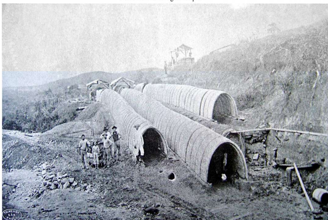
Abobadas de cimento armado para o aqueducto em tunel
