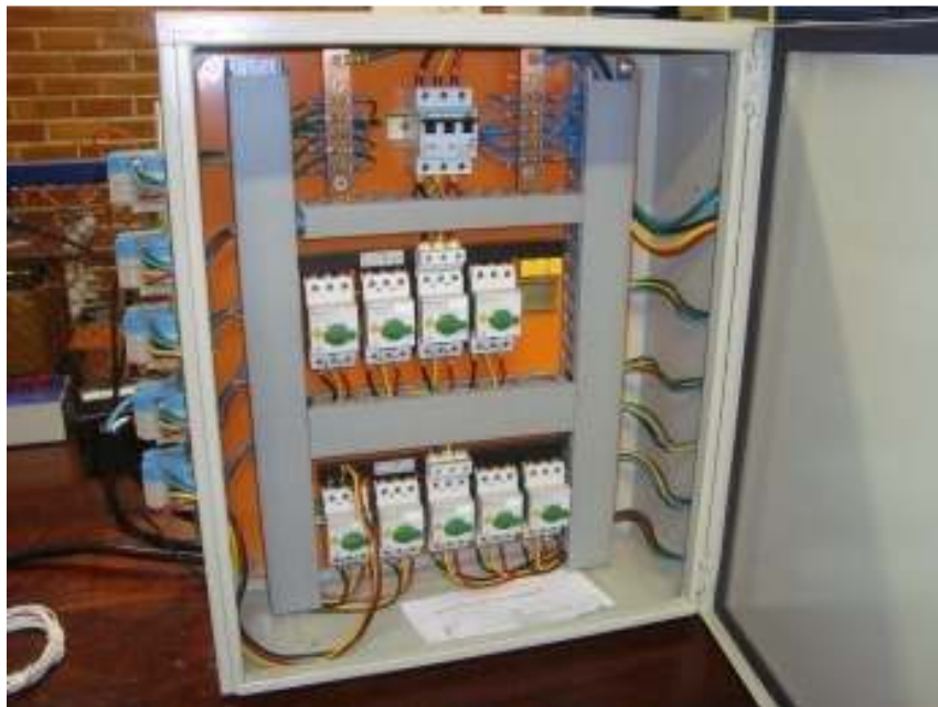
Fig. B-11 – Quadro de cargas.
