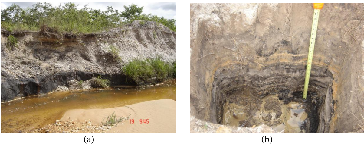
Figura 11: Material arenoso com presença de matéria orgânica. (a) Material arenoso de coloração escura, de ocorrência “in situ” às margens do córrego Pau Grosso, sob rejeito de dragagem. (b) Rejeito proveniente de dragagem, depositados no fundo do vale, cores variadas, com destaque para o material de cor escura alternando-se com material de cor cinza.
