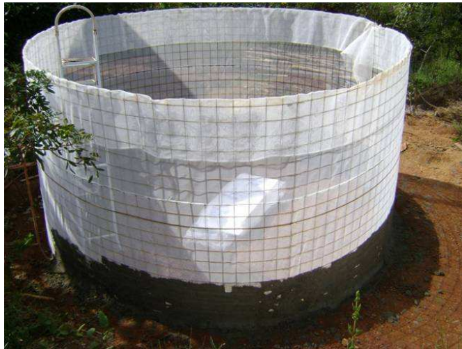
Foto 2 – Estrutura do tanque de ferrocimento do Sítio Tamanduá.
