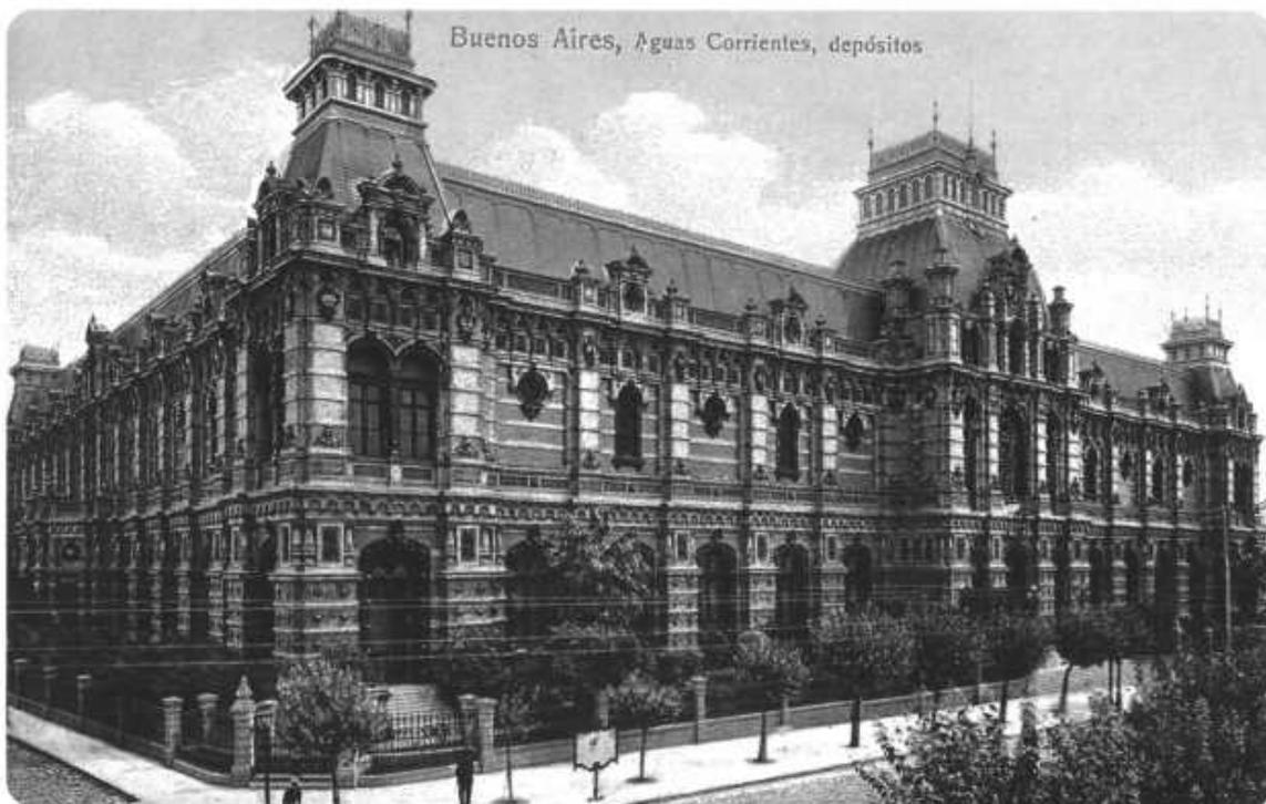
Figura 2- Palacio de las Aguas. Embora as fachadas sugiram um edifício normal trata-se na verdade de um enorme depósito de água. Fica na Avenida Córdoba e foi construído entre os anos 1887 e 1894, com utilização massiva de materiais importados.
