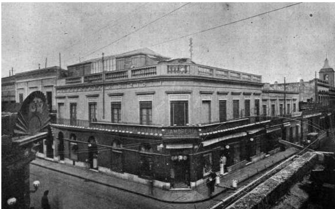
Figura 178 - Uma das formas usuais de adensamento em Buenos Aires foi a ocupação dos terraços com estruturas de madeira e chapa.
