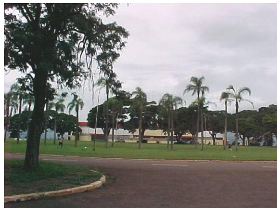
Figura 12.29 O terminal de passageiros e a praça do aeroporto.
