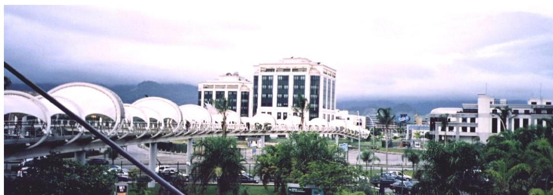
Figura 10.32 A passarela de ligação do Shopping ao Centro Empresarial BarraShopping - ao fundo Estácio de Sá. Fonte: Foto do autor, mar. 2005.
