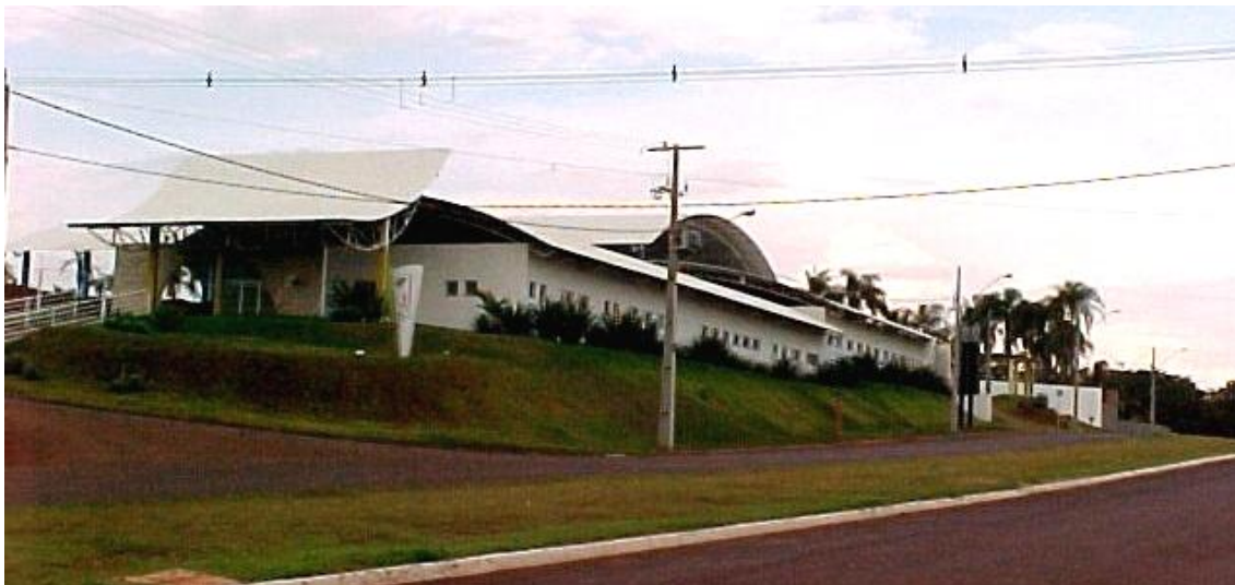
Figura 9.40 A Escola Saint James. Fonte: Foto do autor, mar. 2005.
