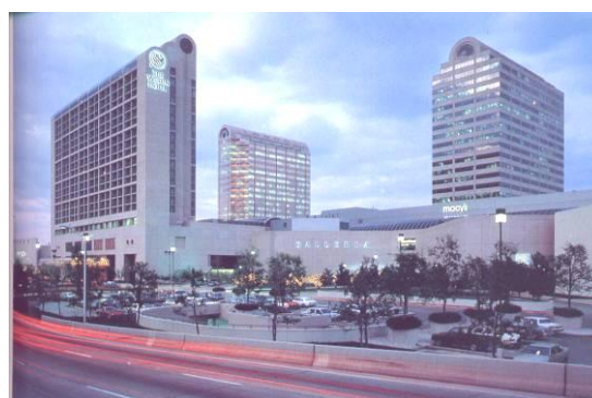
Figura 5.28 Vista do Complexo Dallas Galleria da auto-estrada. Fonte: CERVER, s.d., p. 79.
