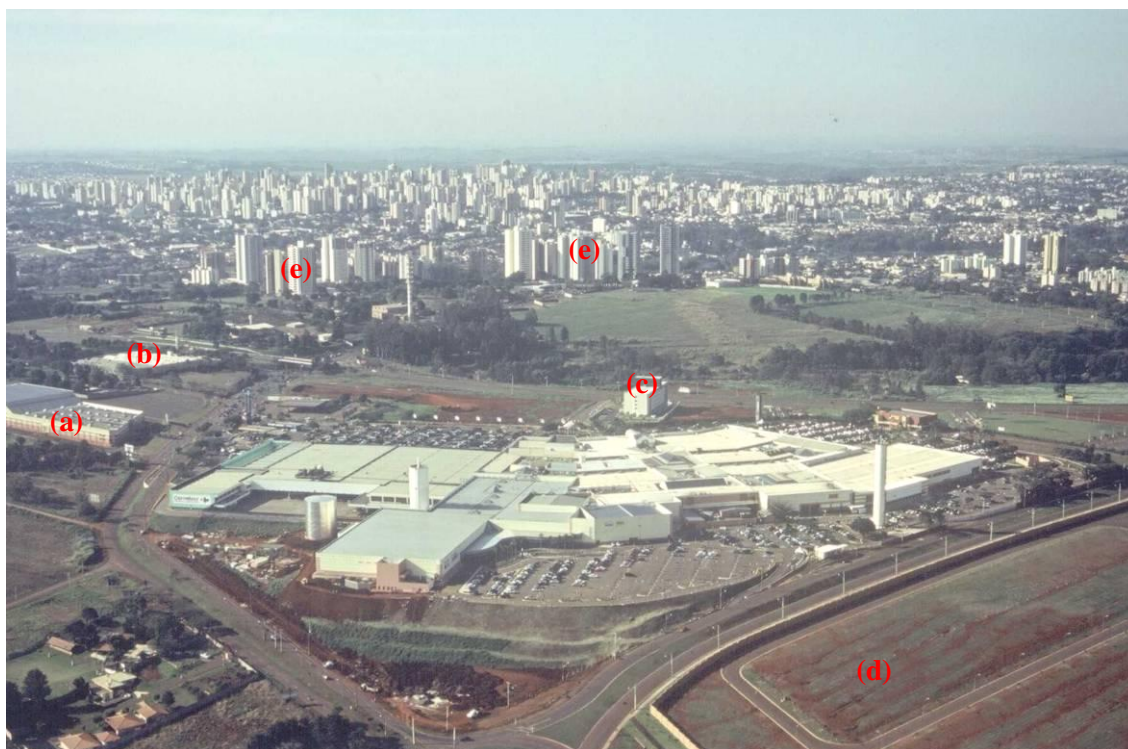
Figura 9.3 Catuaí Shopping Center - vista aérea: (a) Shopping Center Sul; (b) EQUIPE - Distribuidora de Medicamentos; (c) Comfort Suites; (d) AlphaVille Londrina; (e) Edifícios Gleba Palhano; ao longe centro da cidade. Fonte: Catuaí Shopping - Administração, abr. 2005.
