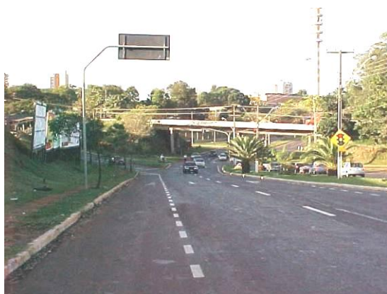
Figura 9.32 O viaduto da PR 445. Fonte: Foto do autor, jun. 2002.
