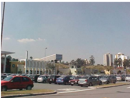
Figura 6.30 O talude ao fundo do Shopping e a ocupação do entorno. Fonte: Foto do autor, ago. 2004.
