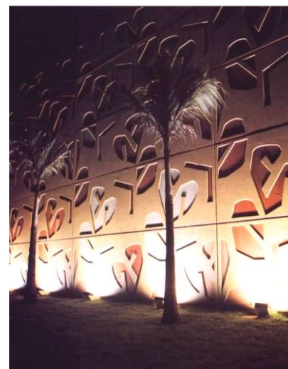
Figura 7.32 A iluminação nos painéis pré-moldados de concreto. Fonte: AU Especial Shopping Centers, 2002, p. 41.
