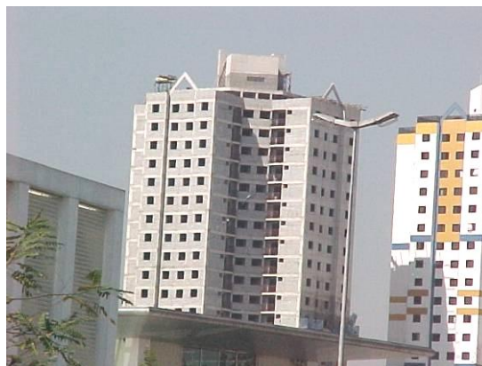
Figura 6.33 Detalhe de edifício em construção no entorno. Fonte: Foto do autor, ago. 2004.
