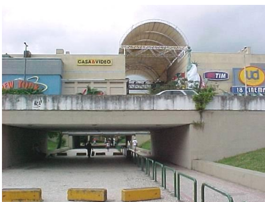
Figura 10.40 Passarela sob a Av. das Américas, ligando o Complexo aos Residenciais.
