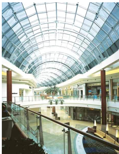
Figura 5.44 Mall At Millenia - detalhe da cobertura em S. Fonte: www.vistawall.com , 12 fev. 2005.
