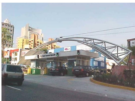
Figura 8.15 Acesso monitorado ao Centro Comercial - portão 2.
