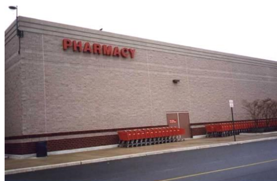
Figura 5.7 Baltimore Outlet - vista externa.
