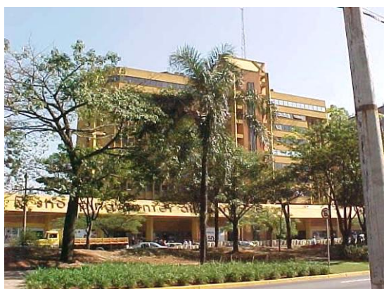
Figura 8.17 Fachada do Shopping Center AlphaVille.
