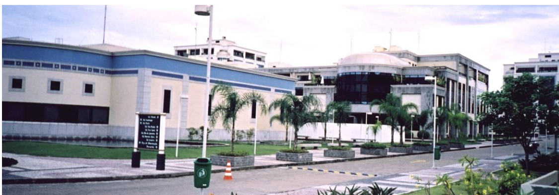
Figura 10.31 Centro Empresarial BarraShopping. Fonte: Foto do autor, mar. 2005.
