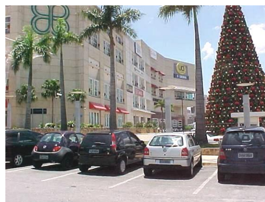
Figura 6.39 Fachada frontal à direita. Fonte: Foto do autor, dez. 2003.
