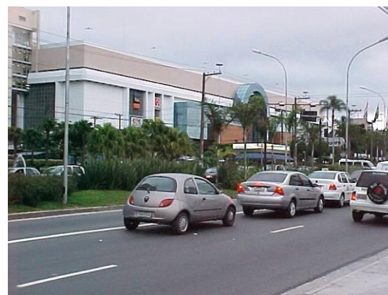
Figura 6.62 Shopping Ibirapuera - fachada frontal. Fonte: Foto do autor, mar. 2005.
