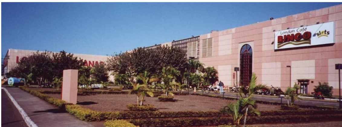
Figura 9.12 A fachada limpa e horizontal, os elementos pré-moldados, a marca das âncoras e o forte paisagismo.
