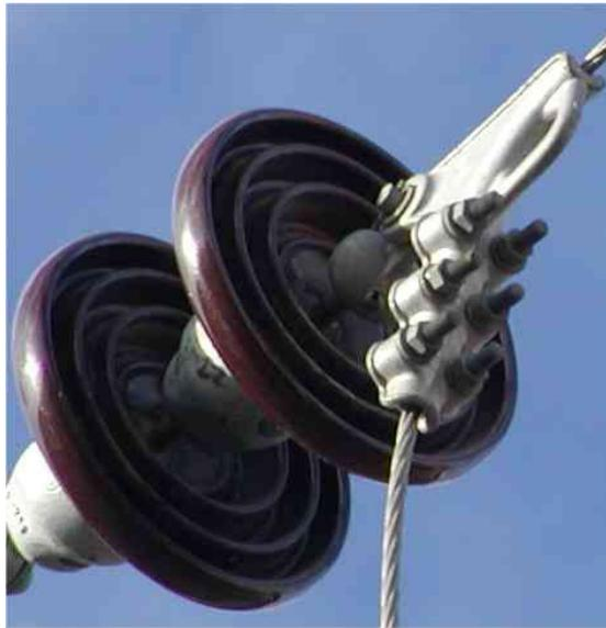
**Figura 5. Fotografia ilustrando isoladores tipo suspensão montado na linha. [24]**
