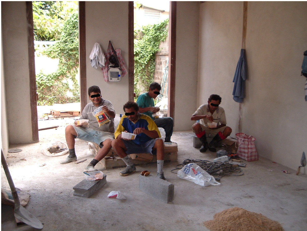
Figura 1: migrantes brasileiros em situação clandestina, no momento de pausa para refeição no canteiro de obras onde trabalham como operários, no centro da cidade de Caiena. As refeições eram preparadas e levadas por uma pessoa conhecida dos trabalhadores, e consumidas durante a ausência do patrão.
