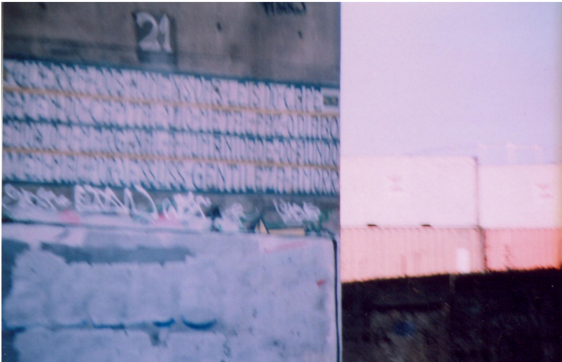
Figura (63) Pilastra 21. Foto da autora
