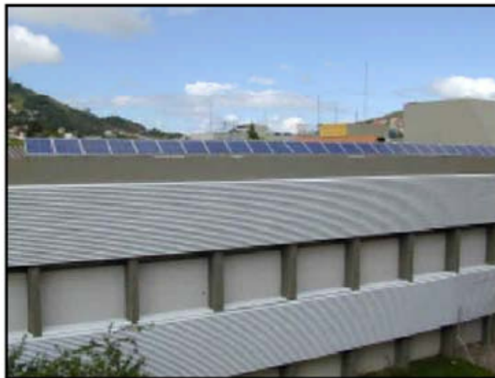
Figura 12 – painéis solares instalados no INEP.
