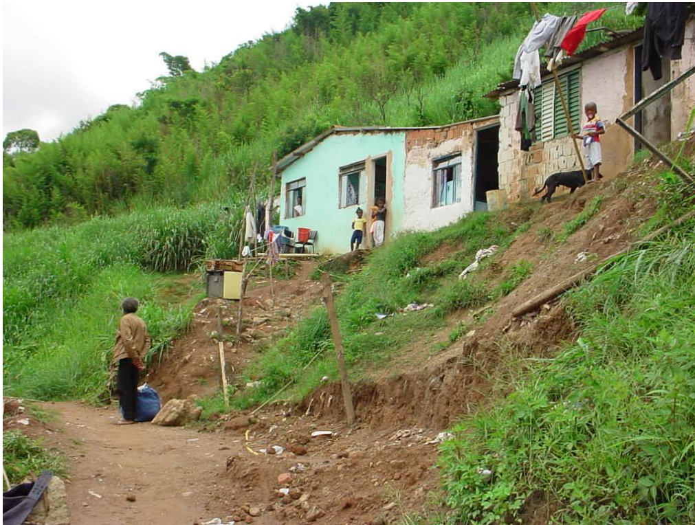
Foto 9: Prolongamento da Rua Arminda Nunes Ribeiro. Moradias precárias, sem esgotamento sanitário, a água e luz eram improvisadas. Fonte: Defesa Civil de Juiz de Fora – MG. 30 jan 2003.
