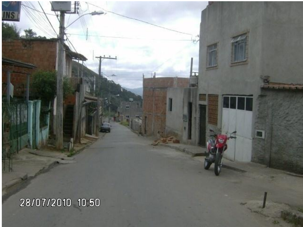
Figura 7: Rua Silvério da Siqueira. Fonte: Acervo Fotográfico de Ana Cláudia Barreto. 28 de Julho de 2010.
