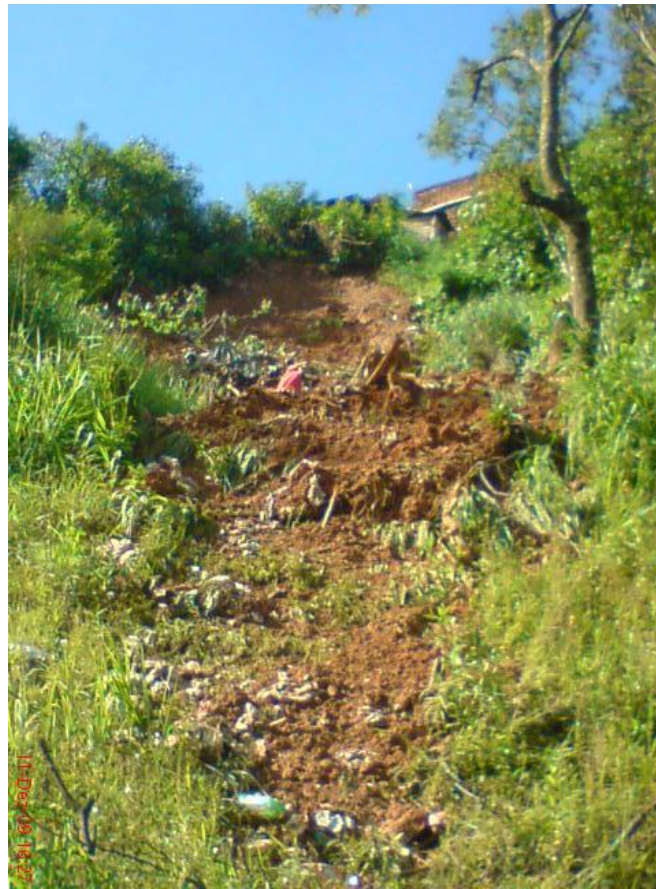
Figura 11: Escorregamento de talude, vindo da Rua Silvério Siqueira. Fonte: Acervo Fotográfico de Ana Cláudia Barreto. 11 dezembro 2009.
