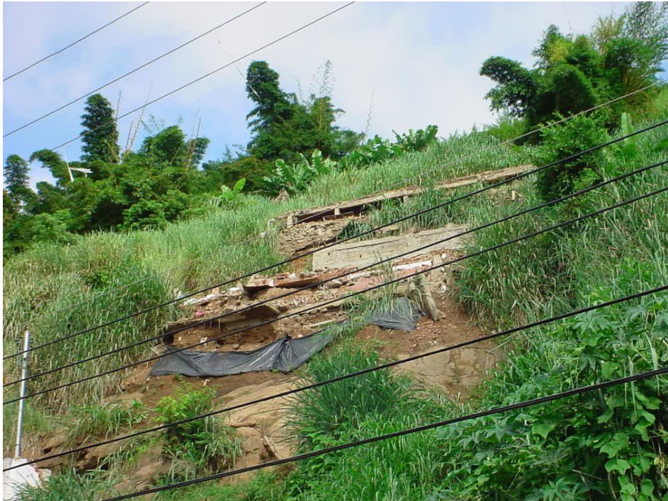
Foto 7: Demolição das moradias construídas em cima da rocha. Fonte: Defesa Civil de Juiz de Fora – MG. 28 Mar 2003.
