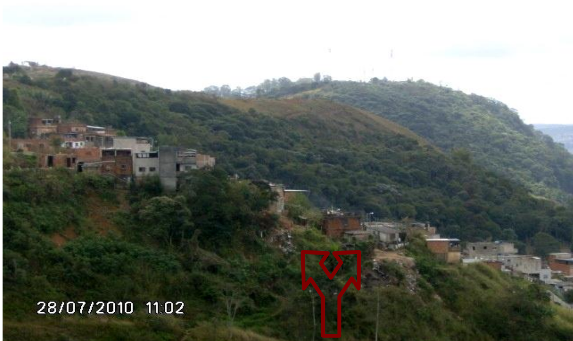
Figura 10: Vista lateral da Rua Silvério Siqueira. Uma das áreas de risco, onde é frequente o deslizamento de terra. Fonte: Acervo Fotográfico de Ana Cláudia Barreto. 28 de Julho de 2010.
