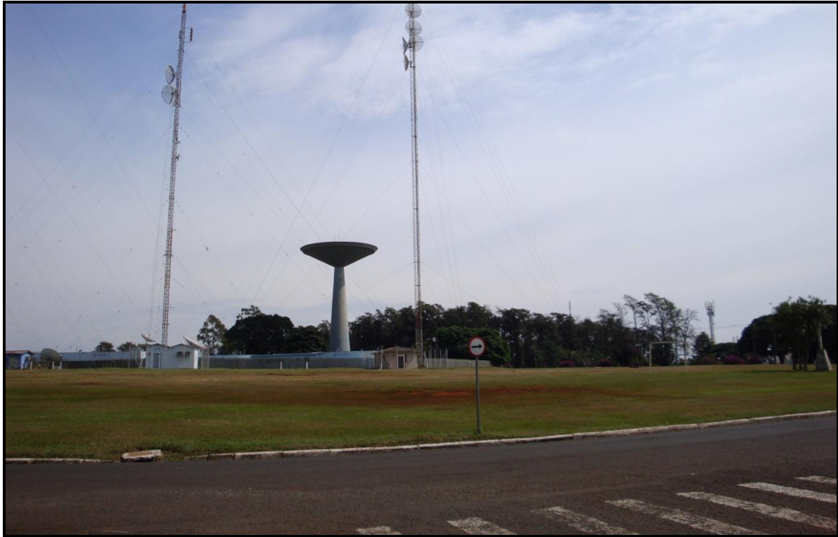
Figura 8 – Praça Pio XII, destacando-se a caixa d’água em forma de cogumelo.
