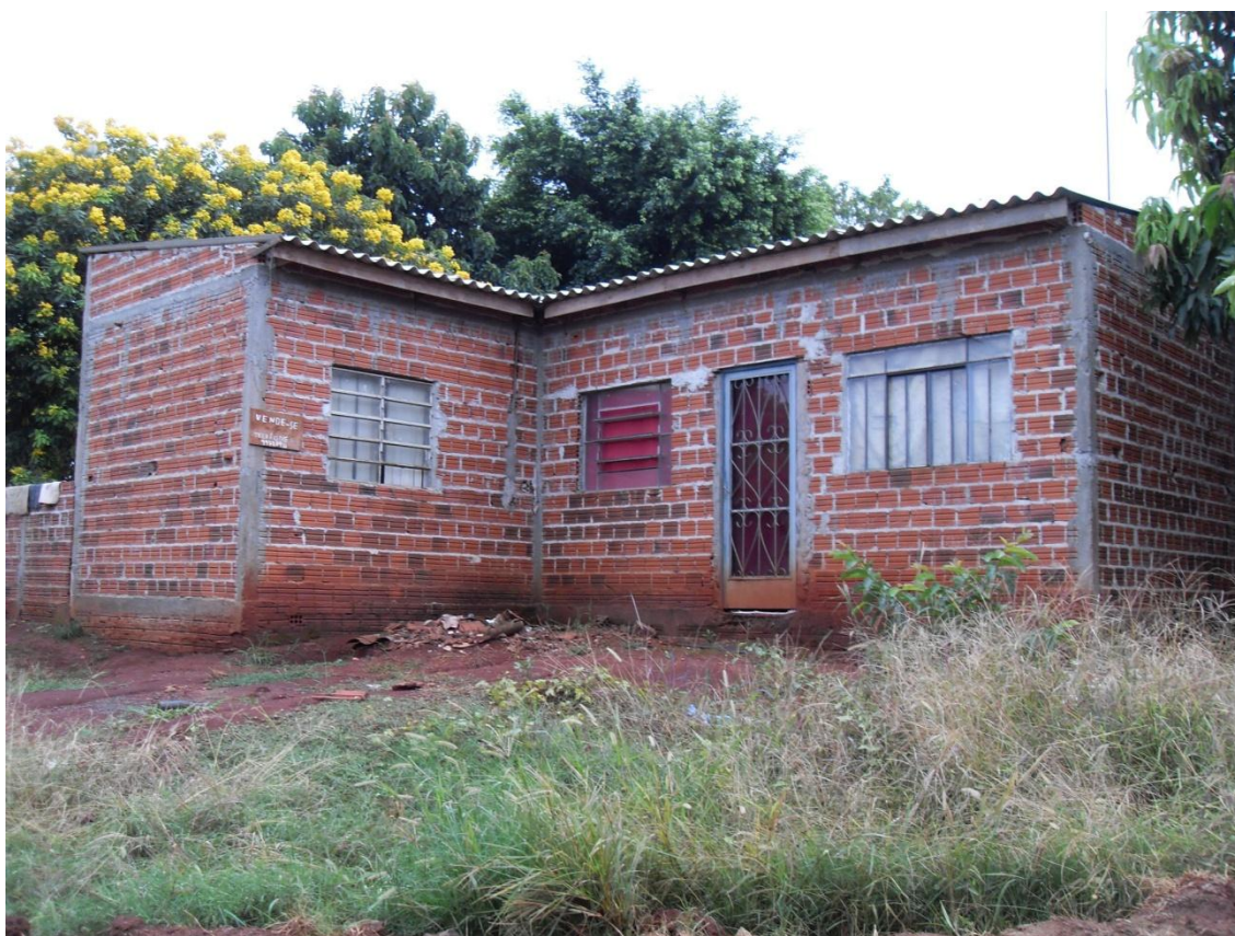
FIGURA 8: TIPOLOGIA DE CONSTRUÇÃO DO RESIDENCIAL TARUMÃ (RUA ATAULFO ALVES)
