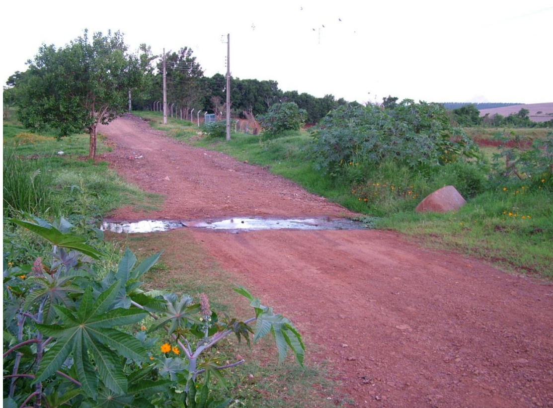
FIGURA 11: NASCENTE DE ÁGUA CRUZANDO A RUA ATAULFO ALVES NO RESIDENCIAL TARUMÃ
