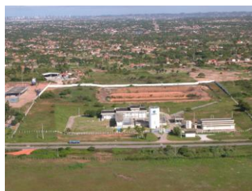
Estação de Tratamento de Água de Extremoz/RN
