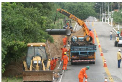
Obra da adutora do Jiqui (Natal/RN) (Parnamirim/RN)
