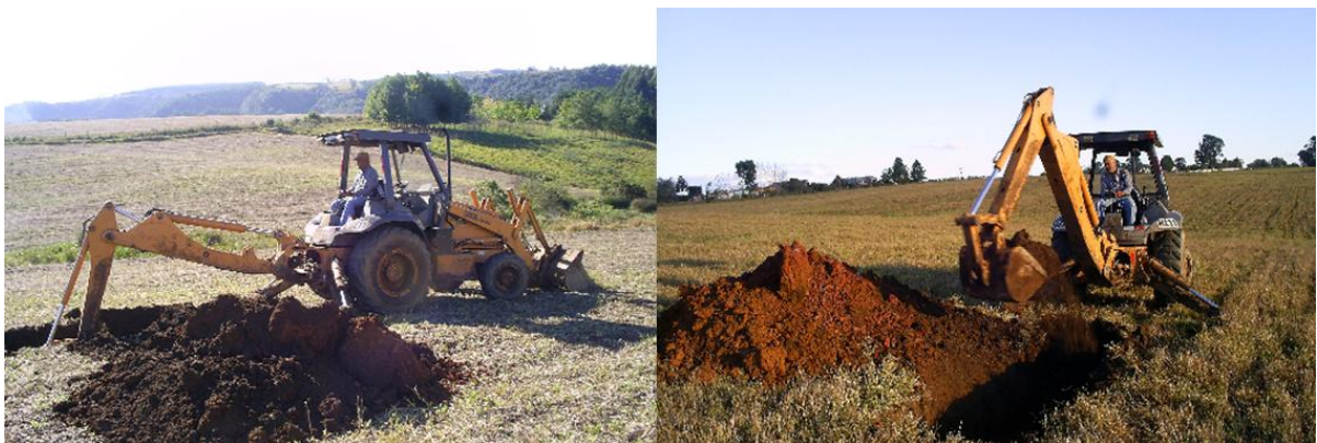
Figura 8 - Abertura dos perfis com retro escavadeira-Epagri/EEL, 2009 (Fotos: Pablo G. Santos).
