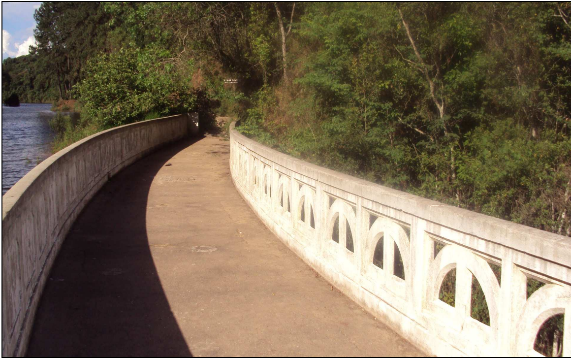
FIGURA 25: Barragem do Cabuçu Fonte: Souza, Luís 06/11/2009.
