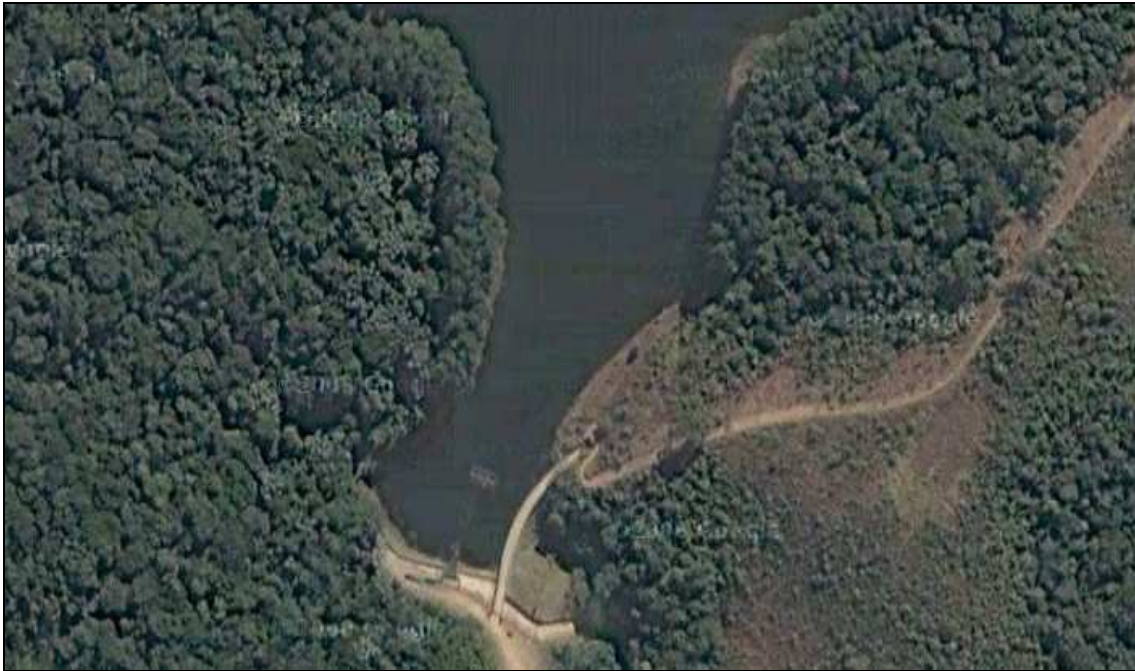
FIGURA 20: Vista aérea da Represa e Barragem do Cabuçu Fonte: Apolo11 (2008).
