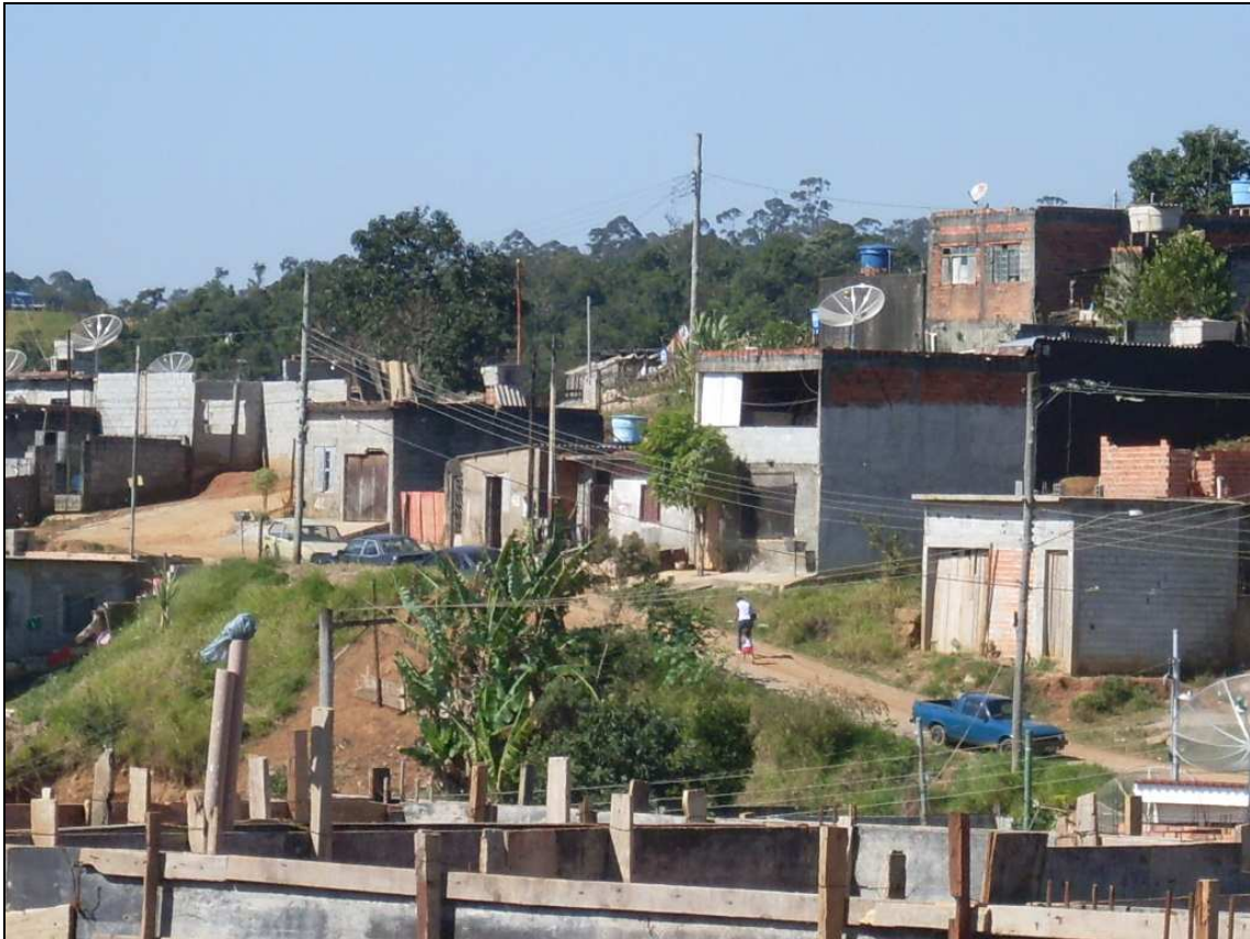
FIGURA 29: Moradias autoconstruídas no bairro Jardim dos Cardosos Autor: Souza, Luís. 27/07/10.
