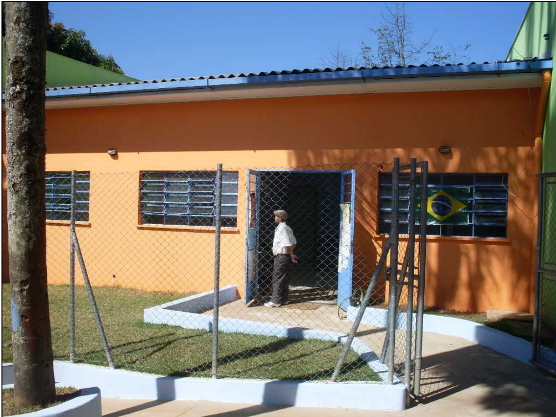
FIGURA 27: Vista da entrada do posto de saúde do bairro Jardim dos Cardosos Autor: Souza, Luís. 27/07/10.
