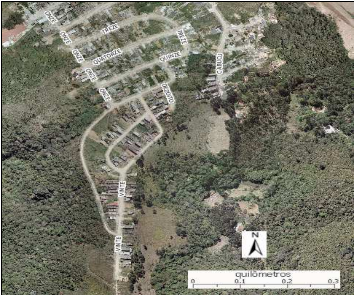
FIGURA 33: Vista aérea das ruas sem pavimentação do Jardim dos Cardosos Fonte: Webgeo (2010).
