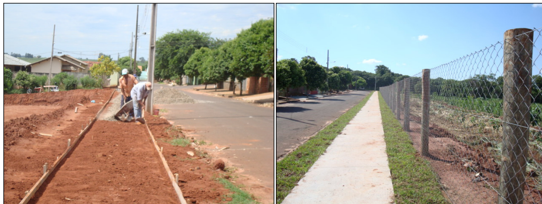
Figura 16: Pista de caminhada localiza defronte ao Conjunto Moradias Marselha. À esquerda em construção, a direita pronta para uso.
