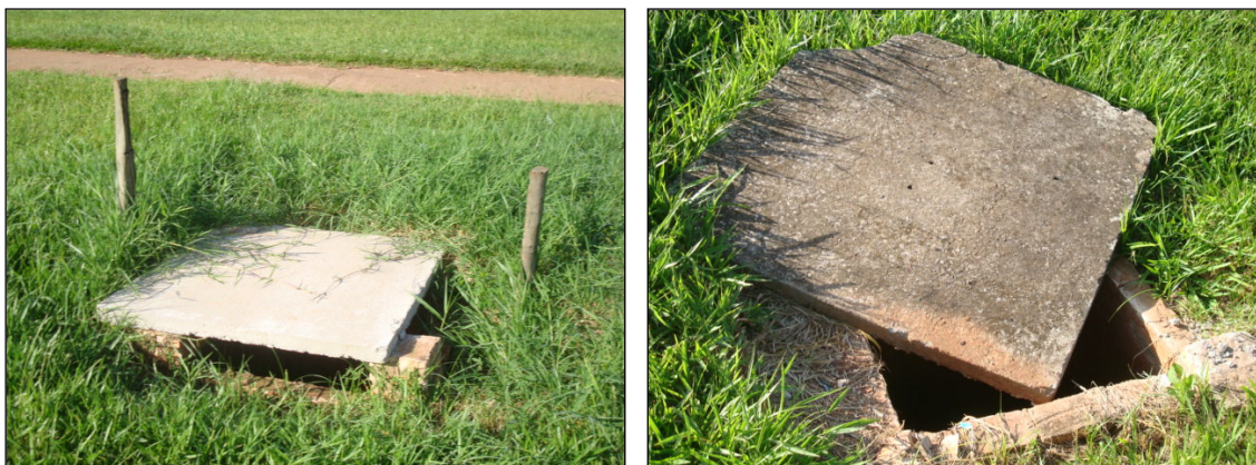
Figura 18: Poços de visita abertos, localizados na área do parque infantil.
