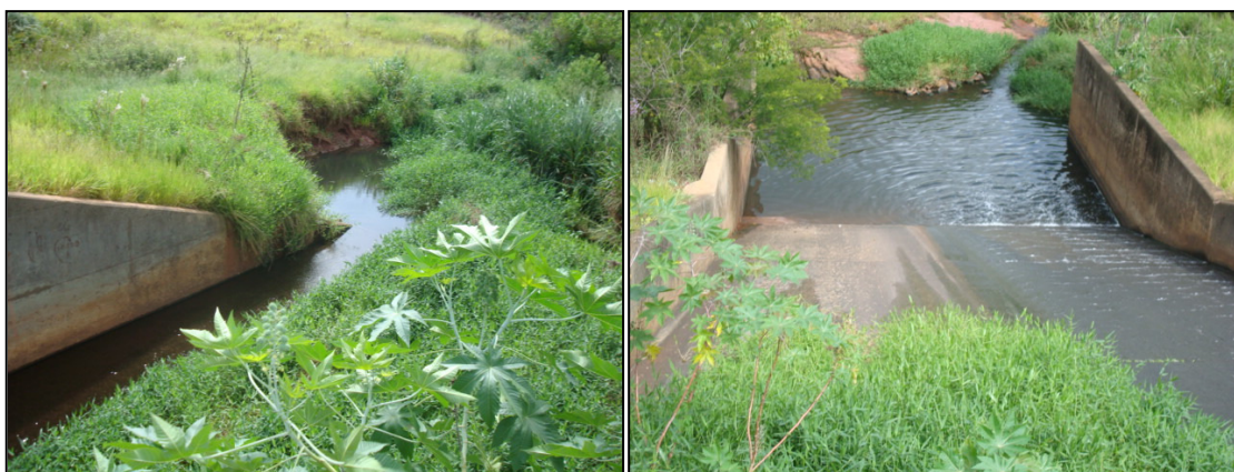
Figura 3: Rampas das barragens para controle da erosão, assoreadas com sedimentos e vegetação. Nadir L. de Souza. 22/01/2009.
