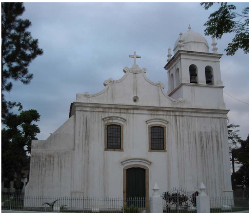
IGREJA DE NOSSA SENHORA DO PILAR DO IGUAÇU
