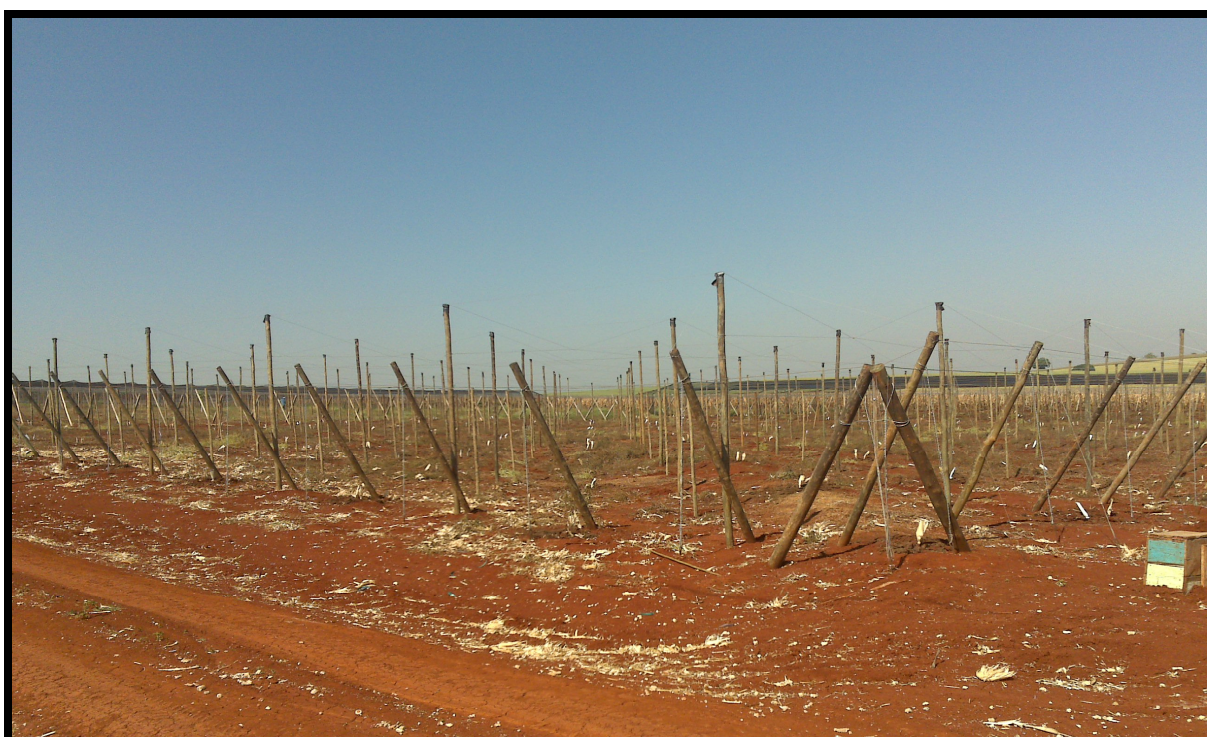
Figura 5 – Montagem da estrutura do parreiral.
