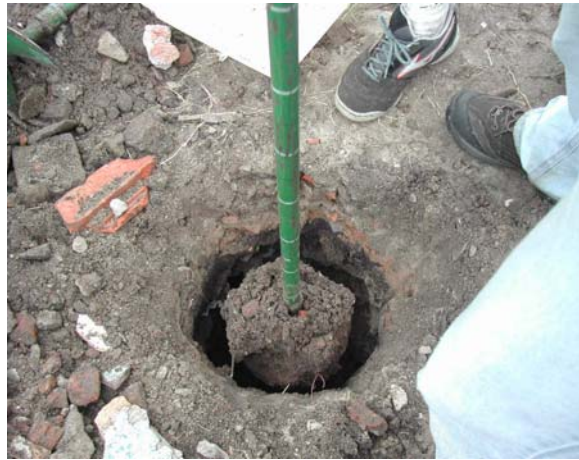
Figura 10 – Perfuração do material de aterro
