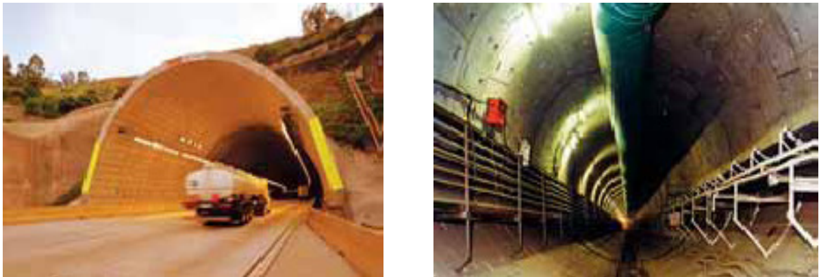
Ilustração 21 – Túneis com concreto projetado com fibras e Anéis segmentados para revestimento de túneis (DRAMIX, 2009).
