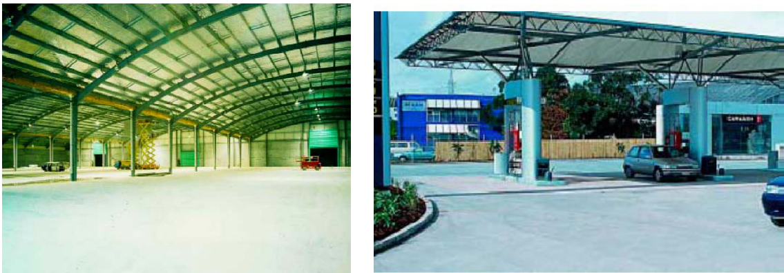
Ilustração 20 – Pavimentação de Galpão Industrial e Posto de Combustível (DRAMIX, 2009).
