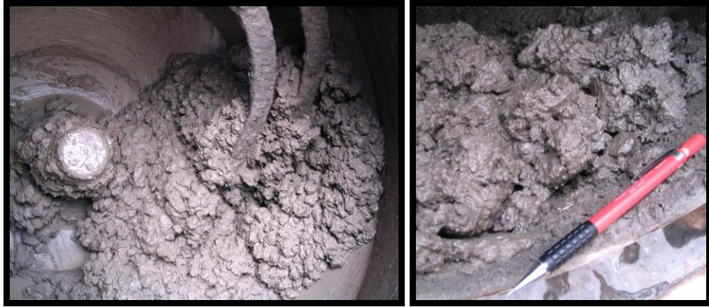
Figura 22: Preparo e aspecto do concreto
