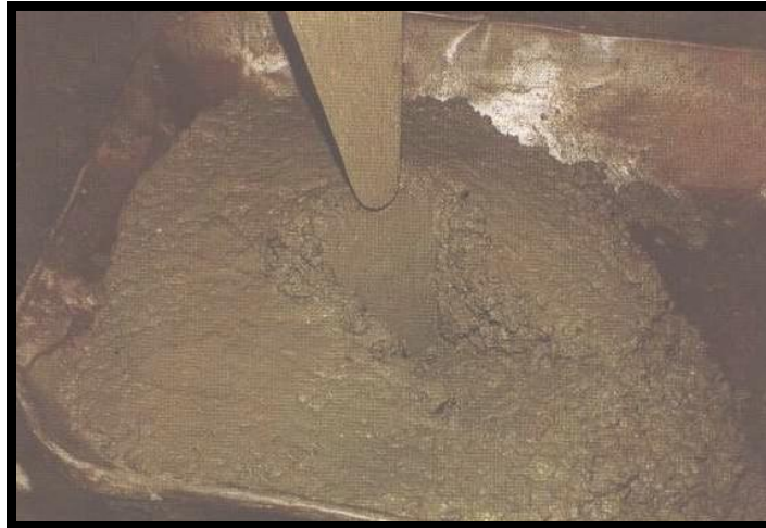
Figura 3: Aspectos da superfície do concreto com teor de argamassa adequada Fonte: Helene e Terzian (2001).
