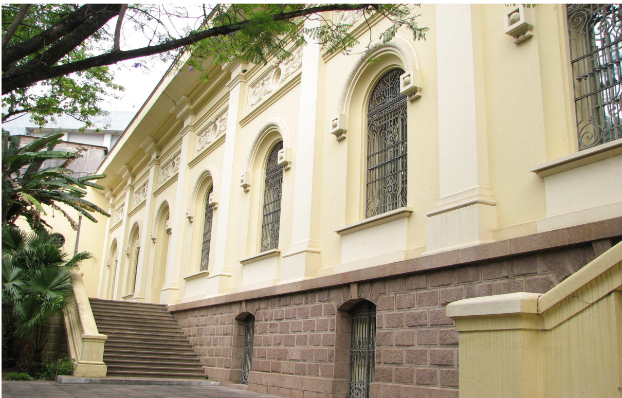
Figura 38 - Foto do prédio I após a restauração, 2001. Porto Alegre. Fonte: Acervo APERS.
