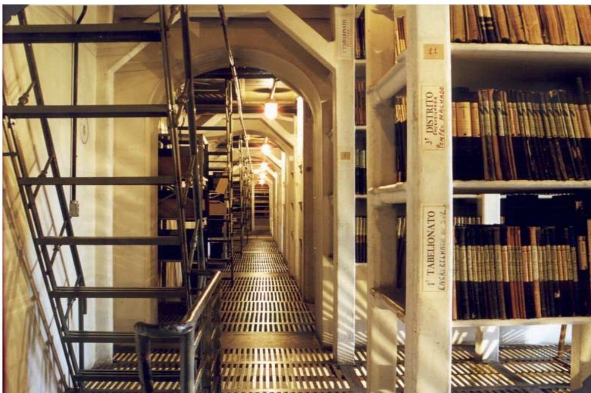
Figura 37– Foto interna do APERS, piso vazado e estante em concreto após a restauração, 2001. Porto Alegre. Fonte: Acervo APERS.
