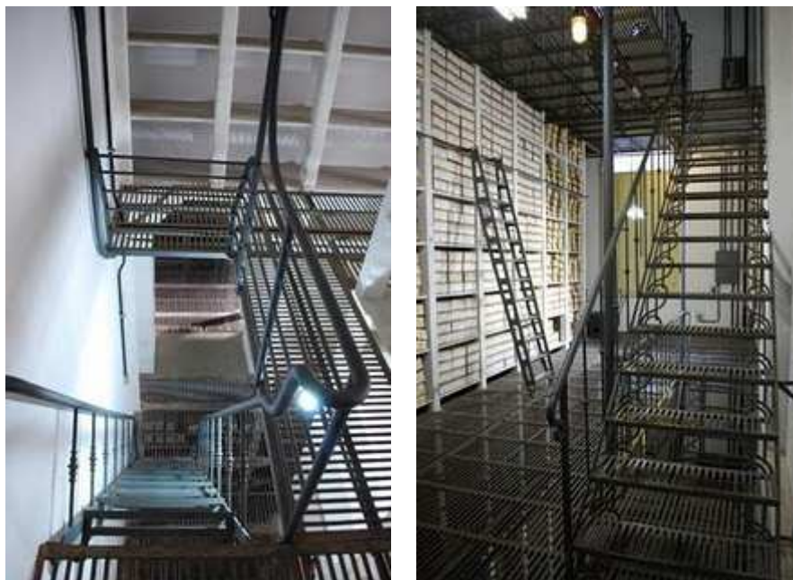
Figura 23 e 24 – Foto da interna Arquivo Público do Estado do Rio Grande do Sul. Escada em trilhos e estrutura em ferro vazada. 1910, Porto Alegre. Fonte: Família Prati. Disponível em: <fotosantigas.prati.com.br>. Acesso em: 20 dez. 2009.
