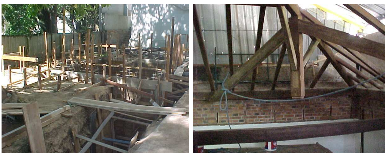
Figura 32- Foto do processo de restauração, obra no piso do pátio, abertura de vala, 1999. Porto Alegre. Fonte: Acervo APERS.
