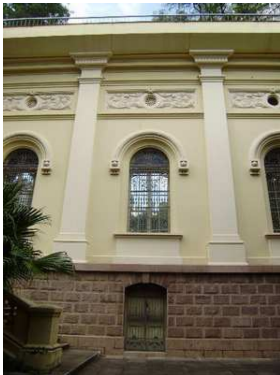
Figura 19 – Foto do Arquivo Público do Estado do Rio Grande do Sul. Representa o prédio em alvenaria e porões em pedra. Porto Alegre. Fonte: Marco Fronckowiak. Disponível em: <bandodebarronoarquivo.com>. Acesso em: 20 maio 2010.
