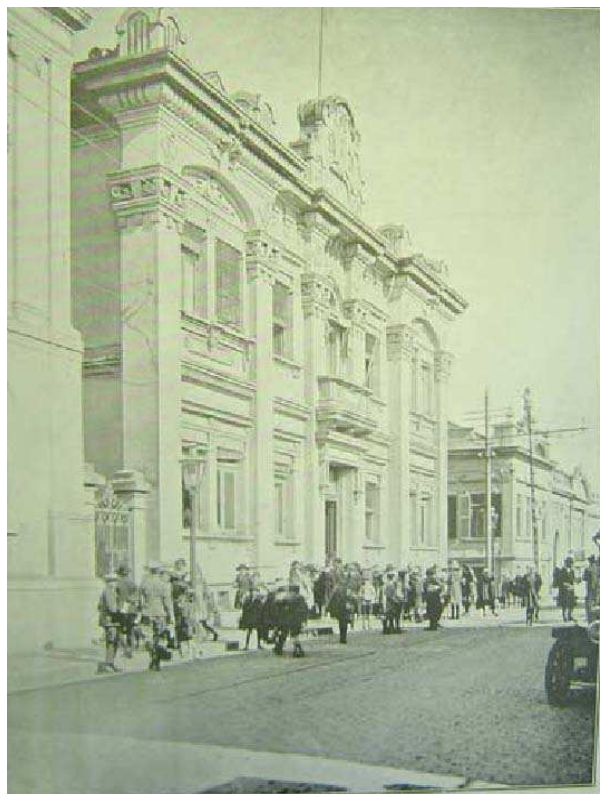
Figura 12 – Foto da Escola Complementar, rua Duque de Caxias, Porto Alegre: ESTADO DO RIO GRANDE DO SUL. [Secretaria de Obras Públicas]. Obras públicas: centenário da Independência . Porto Alegre: Oficinas Graphics d'A Federação, 1922. Acervo: AHRGS.
