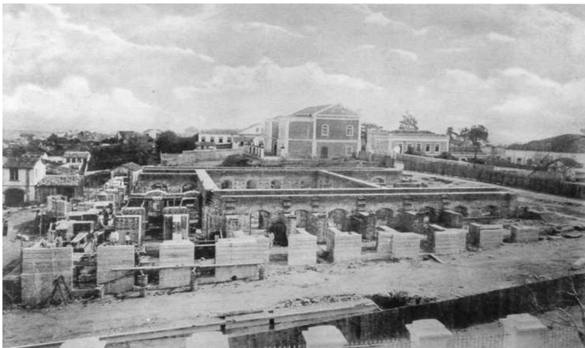
Figura 4 - Foto das obras do Palácio Piratini de acordo com o projeto de Alphonse Herbert, 1898. Disponível em: http://www.estado.rs.gov.br/palaciopiratini/linhaTempo . Acesso em: 08 jan. 2010.
