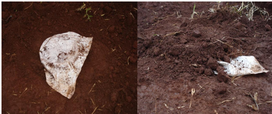
Figura 30: Reposição do geotêxtil e do solo sobre os biorreatores.
