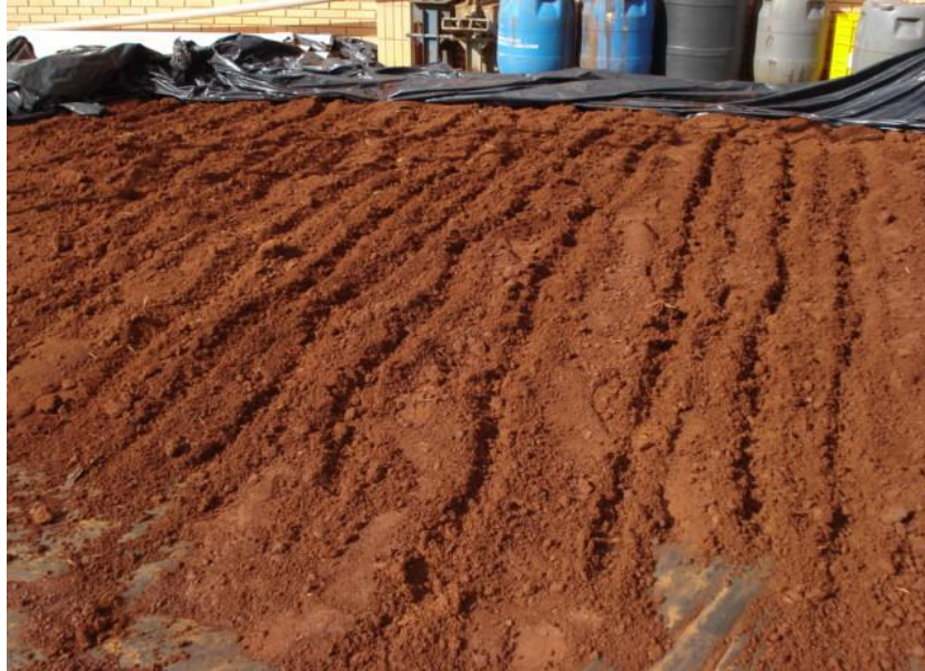
Figura 9: Aeração do solo para perda de umidade.
