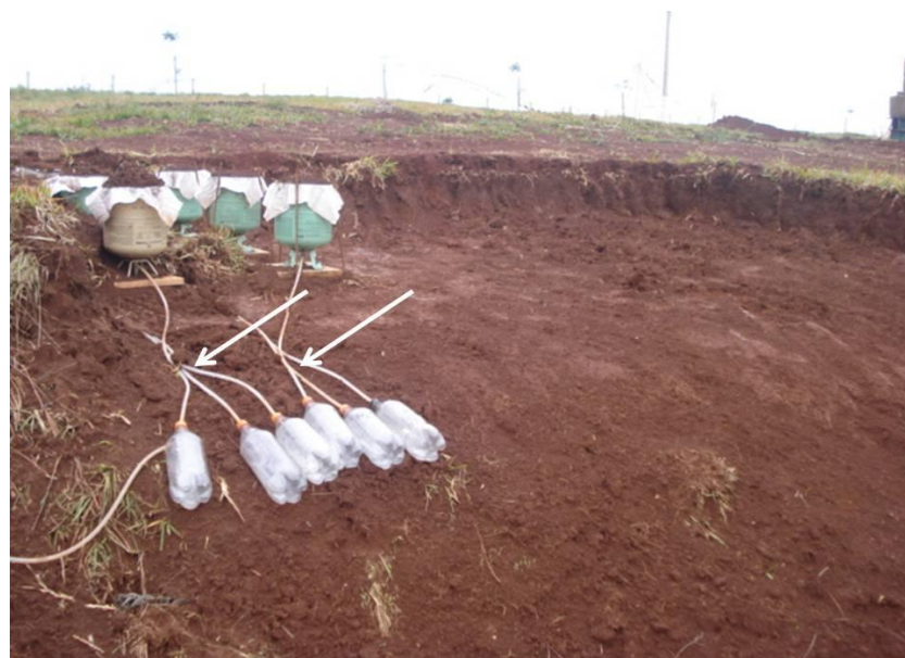
Figura 14: Mangueiras para condução do percolado.
