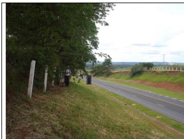
Figura 6.1.5: Corte no terreno realizado para construção da rodovia.
