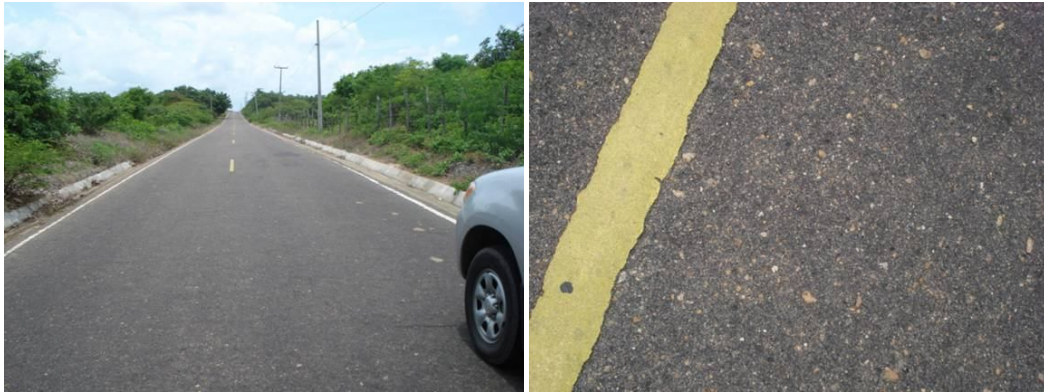
Figura 3.15: Vista geral e no detalhe do revestimento em areia asfalto a frio do trecho Entr. CE-261 – Redonda, em 2010 (Fotos do autor).
