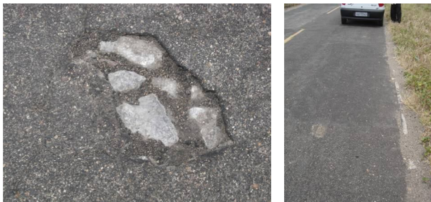
Figura 3.9: Base poliédrica exposta devido ao desgaste e remendo recente já com início de desgaste (Fotos do autor).
