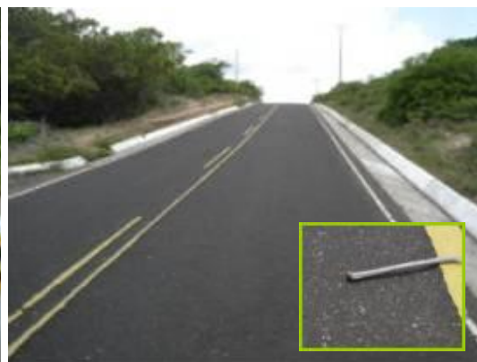
Figura 3.14: AAUF com granulometria mais fina, maior desgaste (Foto do autor).
