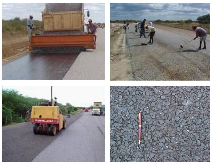
Figura 2.43: Sequência de fotos dos procedimentos construtivos do TSS (Fotos do autor).
