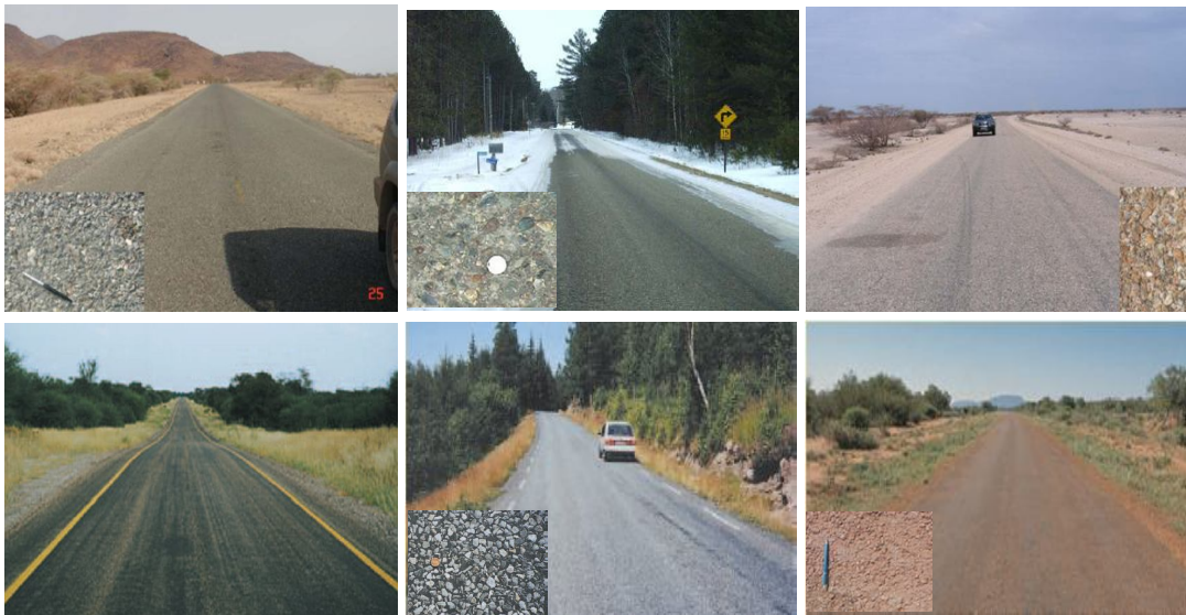
Figura 2. 51: Vista geral de trechos com Otta seal em vários países (OVERBY e PINARD, 2006 e 2007).
