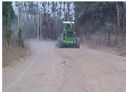
Figura 2.18: Serviço de patrolagem em estrada de terra no Ceará (Foto do autor).
