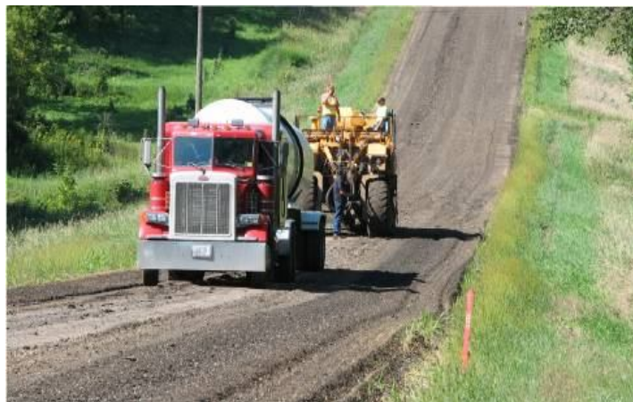
Figura 2.35: Estabilização betuminosa que envolve a nova mistura de cascalho e emulsão (WILDE, 2008).
