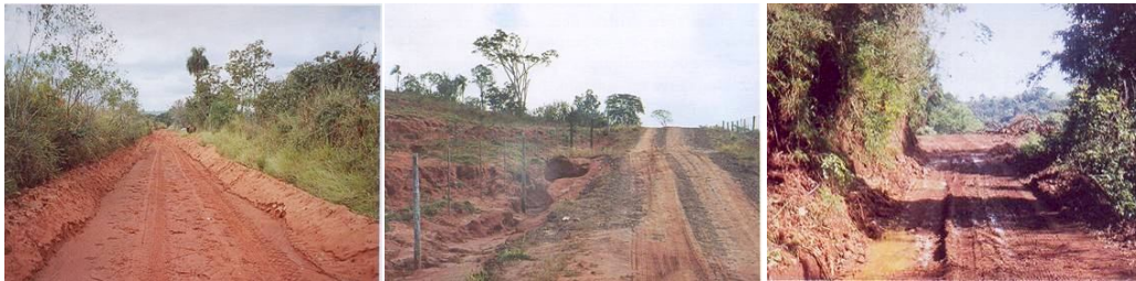
Figura 2.14: Estradas em leito natural na região sul do Brasil (BAESSO e GONÇALVES, 2003).
