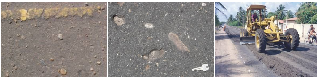
Figura 3.18: Seixos graúdos e espalhamento de motoniveladora são os responsáveis pelo aumento da irregularidade ocasionando desconforto ao rolamento (Fotos do autor).
