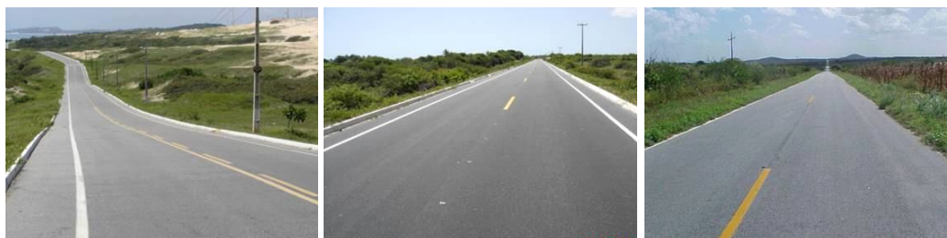
Figura 2.55: Vistas gerais de trechos com revestimento em AAUQ no Ceará (Fotos do autor).
