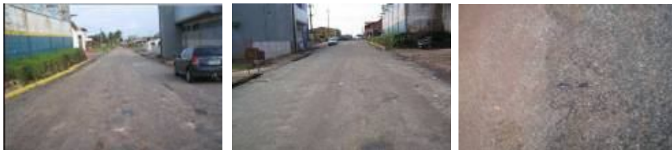
Figura 2.40: Trecho em serviço com capa selante (SANT'ANA, 2009).
