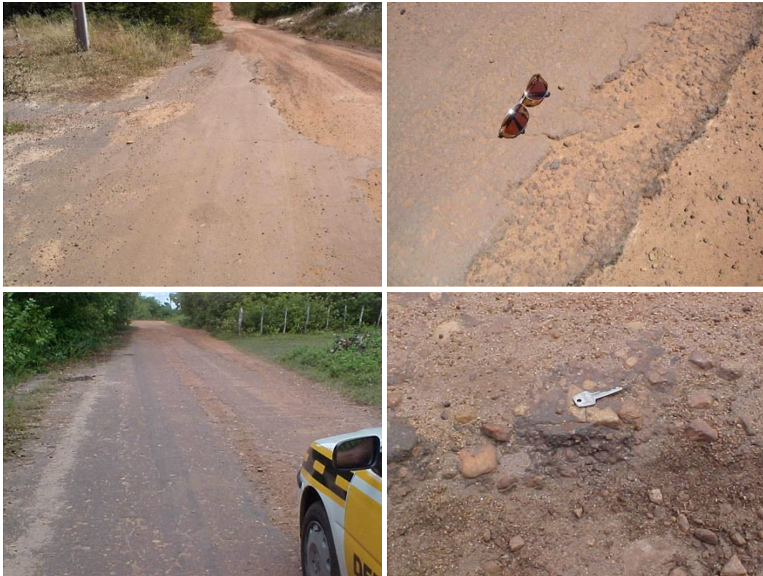
Figura 2.33: Trechos em revestimento primário, no Ceará, apresentando resquícios de solo-betume, vista geral e detalhe (Fotos do autor).
