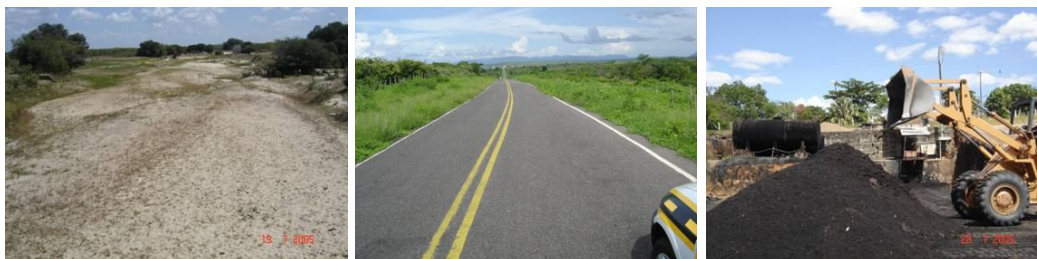
Figura 2.58: Vistas gerais da calha de rio no Ceará, trecho em AAUF e da massa asfáltica enleirada.
