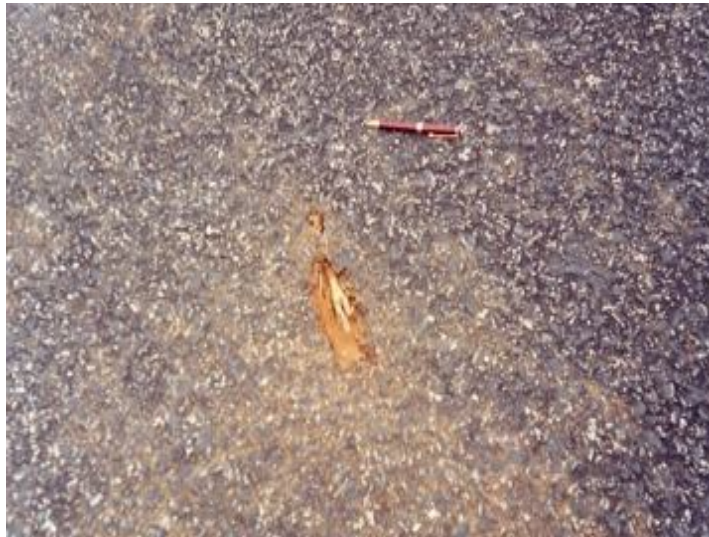
Figura 2.48: Presença de raiz próxima à superfície da base facilita o desgaste pontual dando início ao surgimento de panela (Foto do Autor).
