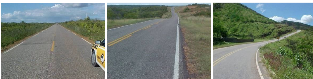
Figura 2.2: Vista geral de trechos com pavimentos econômicos (TSS) no Ceará em regiões com topografias variando de plana até montanhosa.
