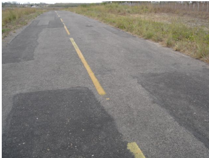
Figura 3.8: Trecho em AAUF em boas condições de rolamento devido a serviços de conservação (Foto do autor).
