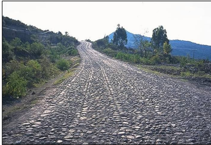
Figura 2.27: Rodovia em região montanhosa com revestimento poliédrico considerado de padrão adequado para a área (KELLER e SHERAR, 2003).
