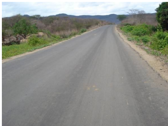
Figura 3.6: Vista geral de trecho em AAUF com RL-1C (Foto do autor).
