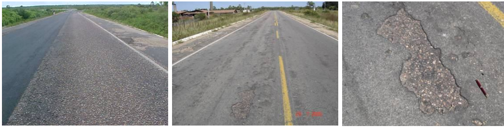
Figura 2.56: Vista geral da BR-116 com revestimento em PMF e após a aplicação de lama.
