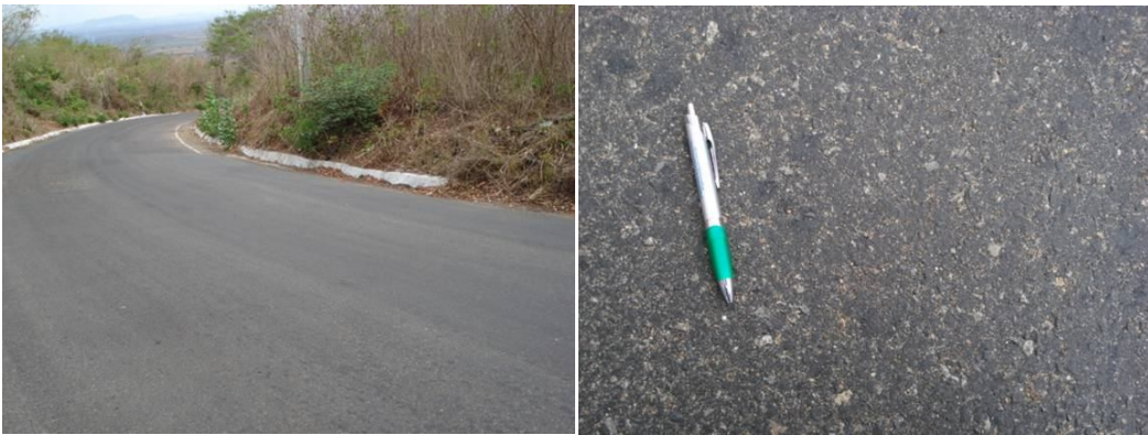
Figura 3.12: Fotos ilustrativas de vista geral revestimento em AAUF e no detalhe, após aproximadamente duas semanas em serviço (Fotos do autor).
