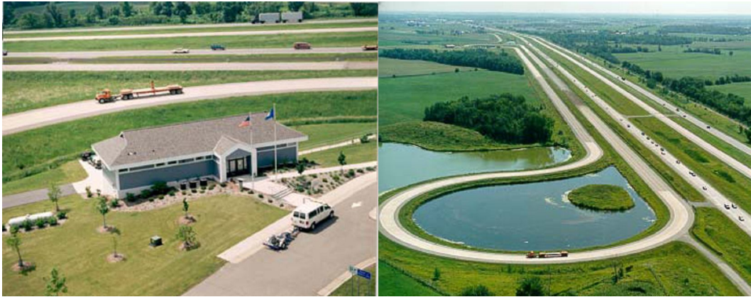
Figura 2.5: Vista geral da infra-estrutura do Projeto de Pesquisa de Estradas - MnROAD (WOREL et al. , 2008).
