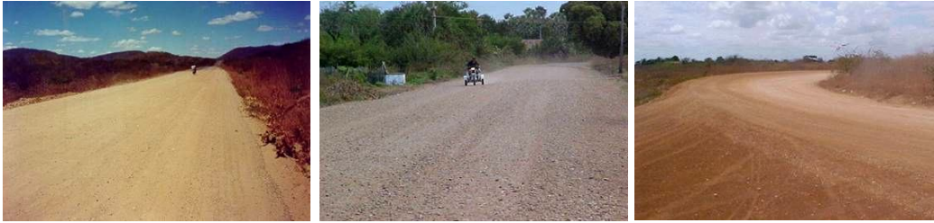
Figura 2.21: Trechos em revestimento primário em várias regiões do Estado do Ceará.
