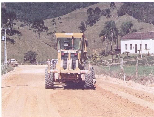
Figura 2.17: Serviço de patrolagem em estrada de terra em Santa Catarina (BAESSO e GONÇALVES, 2003).
