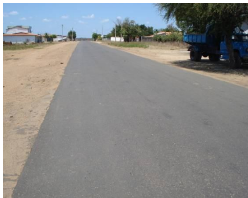
Figura 3.7: Vista geral de trecho em AAUF com RM-1C (Foto do autor).
