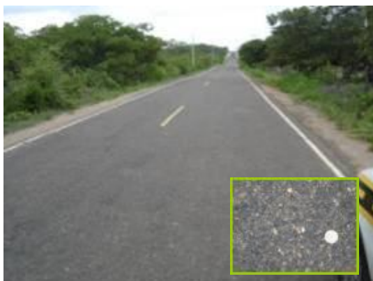
Figura 3.13: AAUF com granulometria grossa, menor desgaste (Foto do autor).
