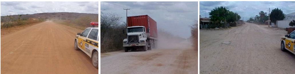
Figura 2.22: Defeitos comuns em revestimento primário como: corrugação, poeira, estreitamento da plataforma.
