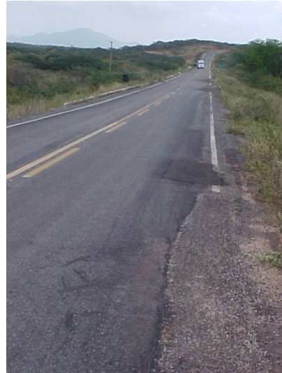
Figura 2.46: Problemas de afundamento de trilha de roda e nas bordas do revestimento, por deficiência de compactação ou seção do pavimento estreita (Fotos do autor).
