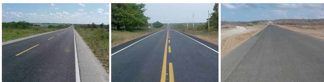
Figura 2.49: Vista geral dos trechos: Cristais – Morada Nova, Croata – Pentecoste e Russas – Divisa CE/RN, logo após construção em 2003 (Fotos do autor).
