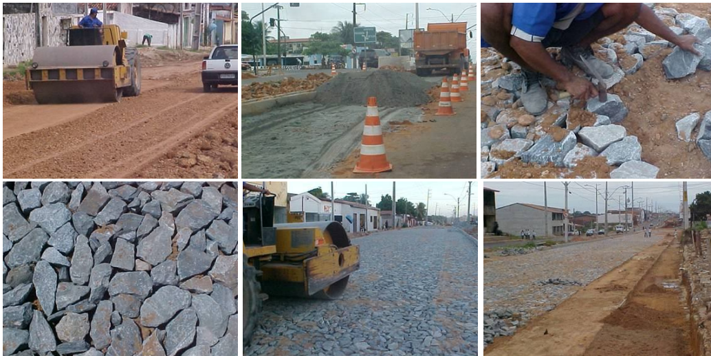
Figura 2.28: Ilustração da seqüência construtiva de um pavimento poliédrico (Fotos do autor).
