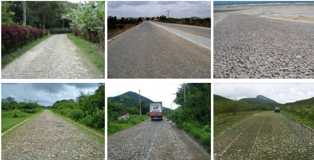
Figura 2.30: Vista geral de rodovias em revestimento poliédrico no Ceará (Fotos do autor).
