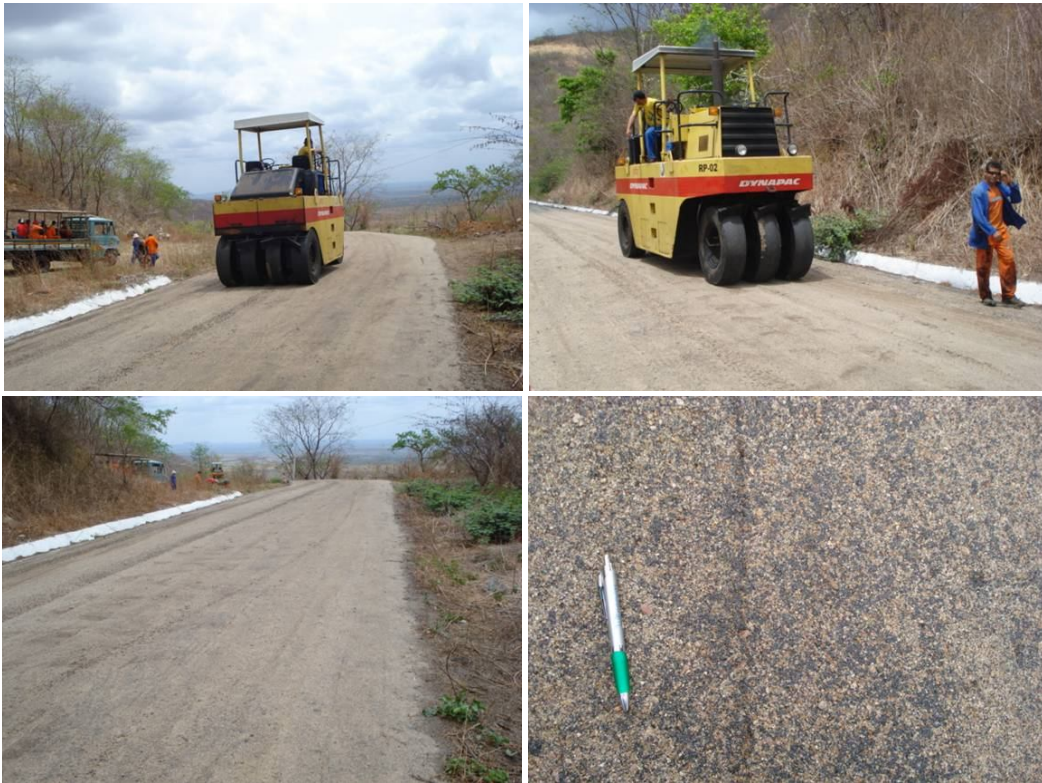
Figura 3.11: Processo construtivo da areia asfalto a frio com emulsão RL-1C (Fotos do autor).
