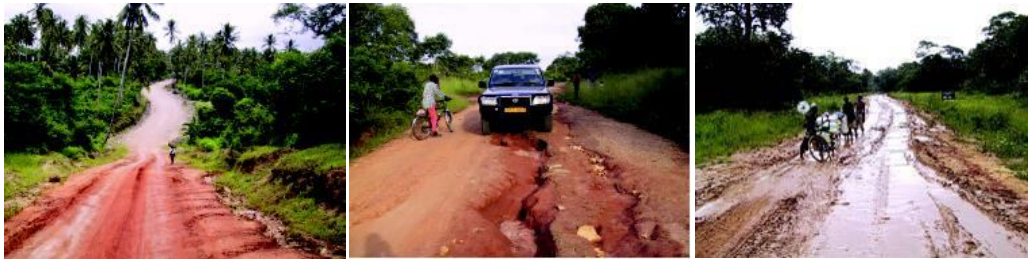
Figura 2.13: Estradas em leito natural na região do sul da África (SADC, 2003).
