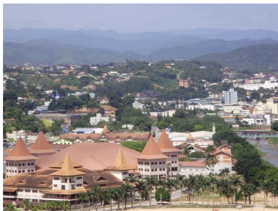
Figura 6 – Vista aérea do parque da Fenarreco.
