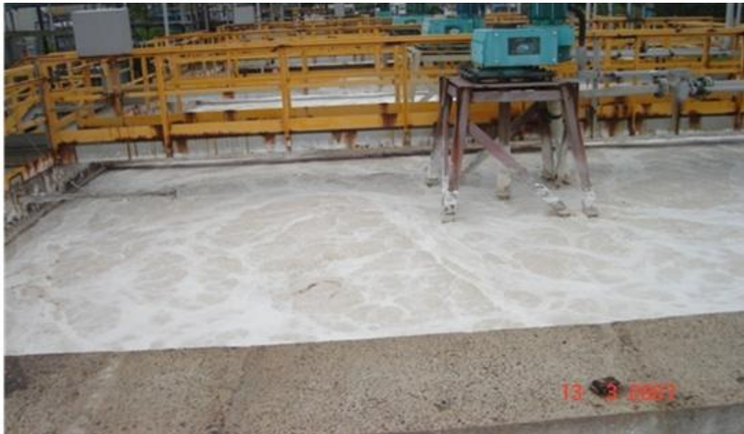
Figura 6 – Tanques de aeração – sistema de lodos ativados
