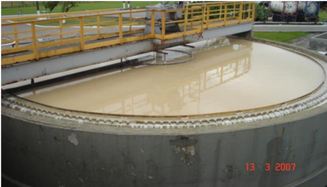
Figura 7 – Sedimentador ou decantador secundário
