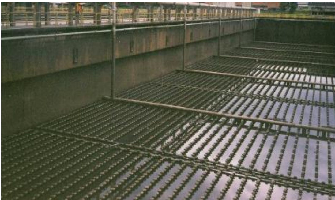
Figura 8 – Sistema de aeração com ar difuso
